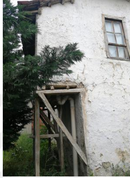
şekil 3. 78 Cepheden çıkan hela örneği, E024, (Doğan Talyak, 2021)
