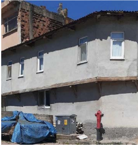
ğekil 4. 14 Çimento sıva uygulaması, E052(Doėan Talyak, 2021)
