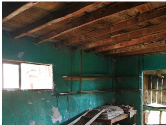
ğekil 3. 41 DöÇeme kiriÇerinin açıkta olduğu tavan uygulaması, E001, (Doğan Talyak, 2021)
