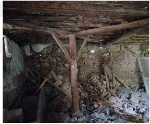
şekil 3. 44 Bodrum kat çapraz kiriş E001, (Doğan Talyak, 2021)
