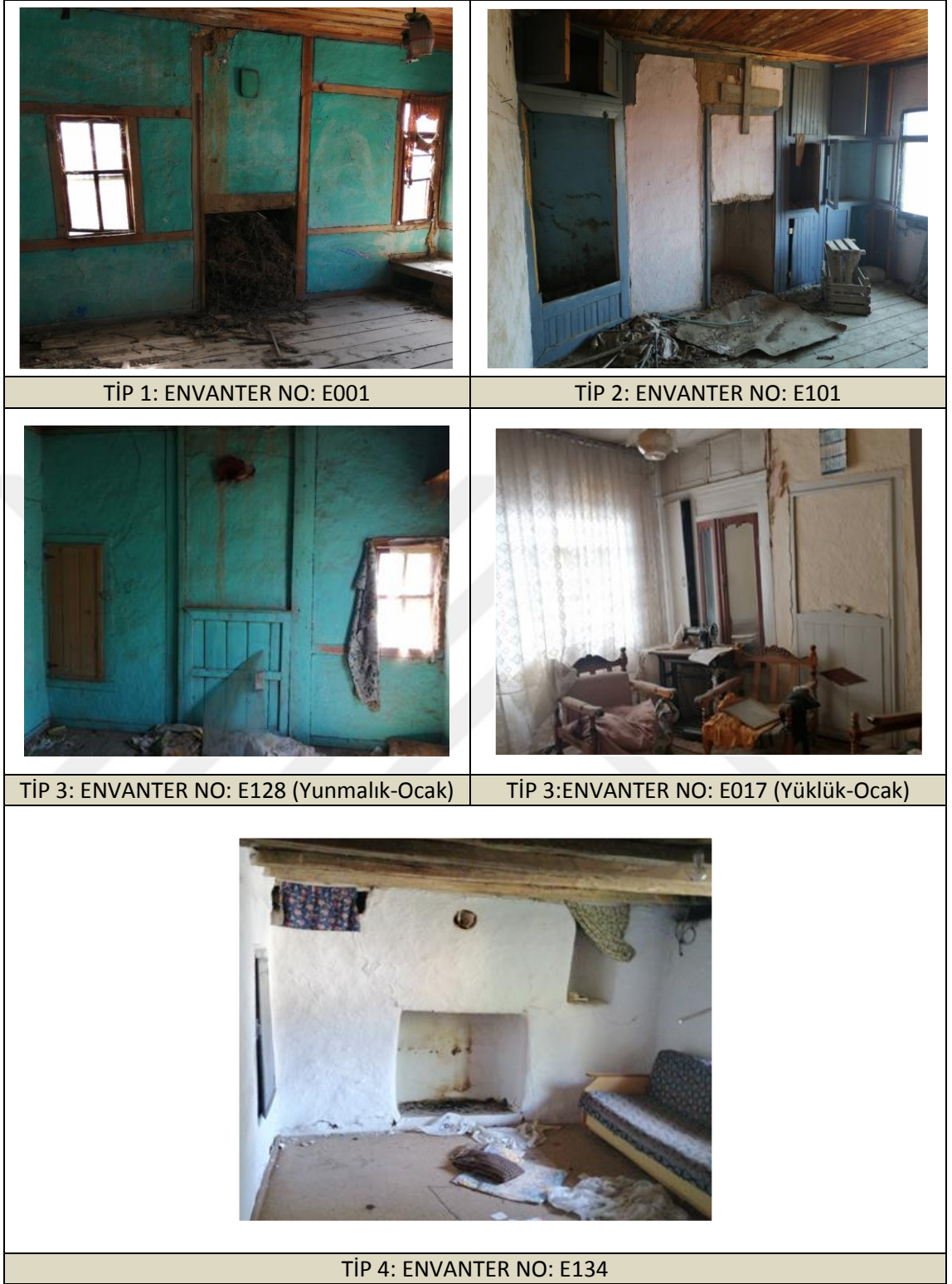
Şekil 3. 62 Elbeyli geleneksel yapı ocak duvarı tipleri, (Doğan Talyak, 2021)
