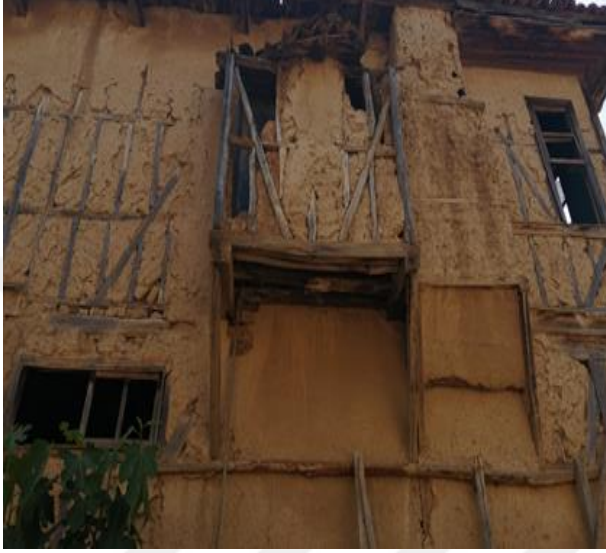
şekil 4. 16 Kerpiç malzeme kaybı, E001, (Doğan Talyak, 2021)
