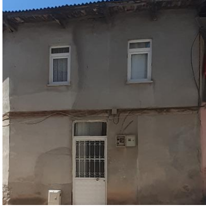
ğekil 4. 8 PVC pencere, metal kapı deđiđmi, E052, (Dođan Talyak, 2021)
