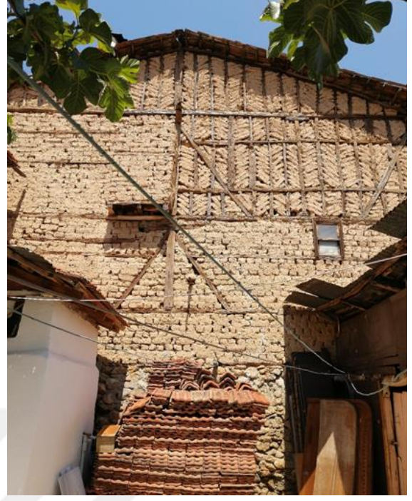
Şekil 3. 52 Yatay, dikey ve çapraz kerpiç tuğla uygulaması, E044, (Doğan Talyak, 2021)
