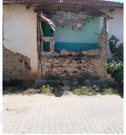
şekil 4. 17 Ahşap karkas sistemde görülen kopmalar, E106, (Doğan Talyak, 2021)
