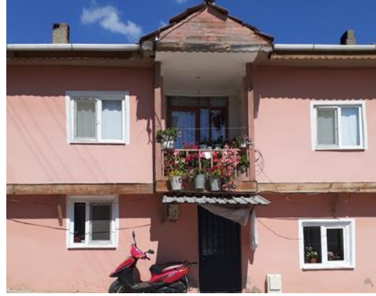
ğekil 4. 9 PVC pencere, metal kapı deđiđmi, E052, (Dođan Talyak, 2021)
