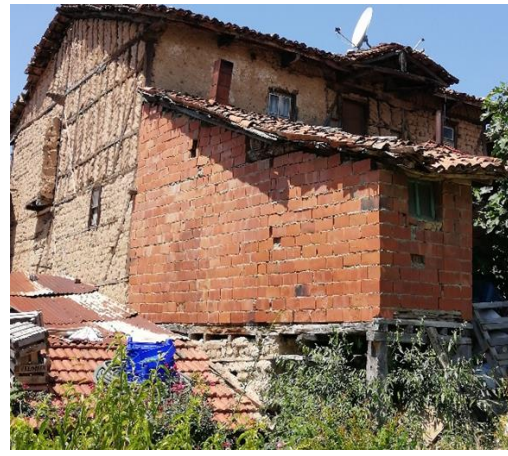
ğekil 4. 24 Yapıya eklenen niteliksiz ek, E044, (Doğan Talyak, 2021)
