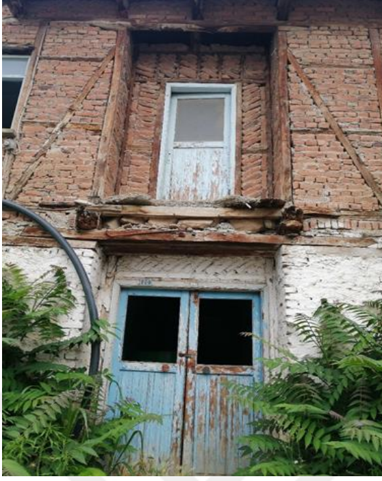
Şekil 3. 51 Harman tuğla uygulaması, E023, (Doğan Talyak, 2021)
