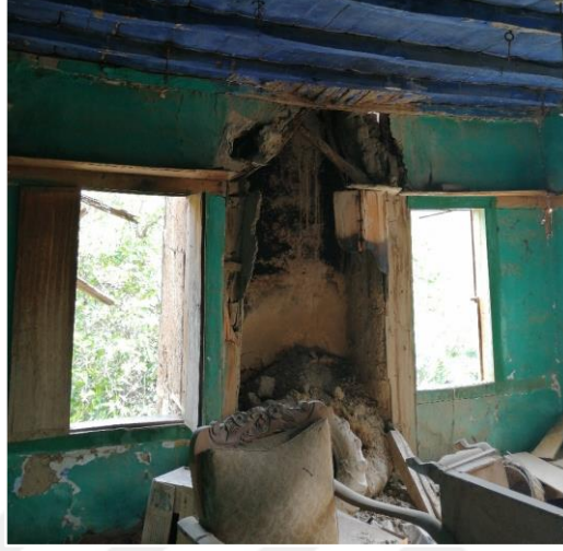
ğekil 3. 63 Yağmaklı ocak örneği, E001, (Doğın Talyak, 2021)
