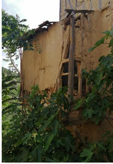
şekil 3. 77 Cepheden çıkan hela örneği, E001, (Doğan Talyak, 2021)
