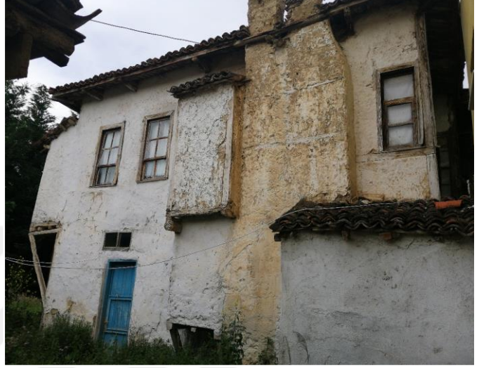
Şekil 3. 67 Cepheye taşınan yunmalık, E025, (Doğan Talyak, 2021)
