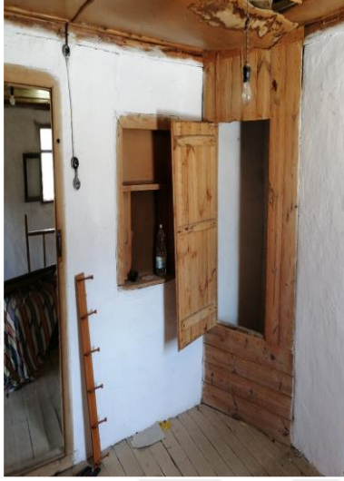
Şekil 3. 66 Yunmalık örneği, E0134, (Doğan Talyak, 2021)
