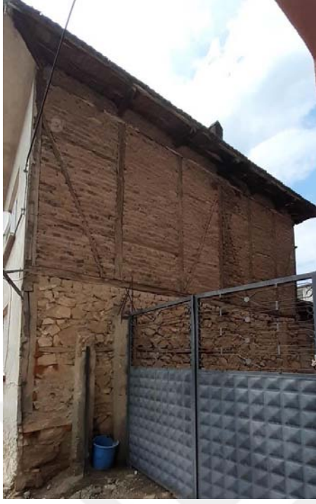
ğekil 3. 49 Zemin kat ahÇap hatıllı yığma moloz taÇ,E015, (Doğın Talyak, 2021)
