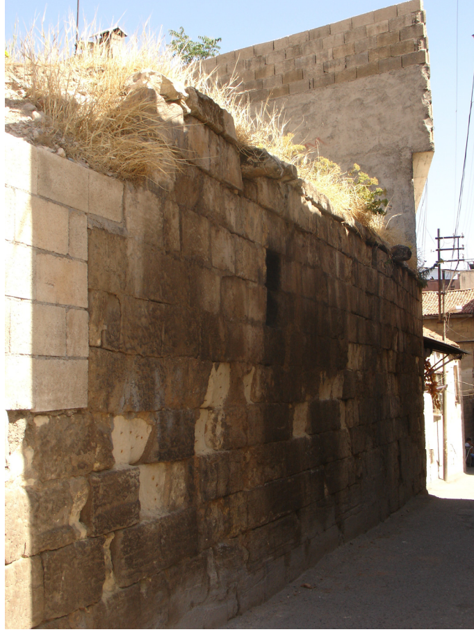
Fotoğraf 4.174 Batı Cephe
