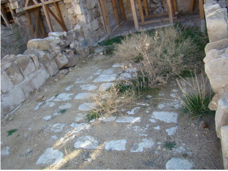
Fotoğraf 4.135 Z38 Döşeme kaplaması
