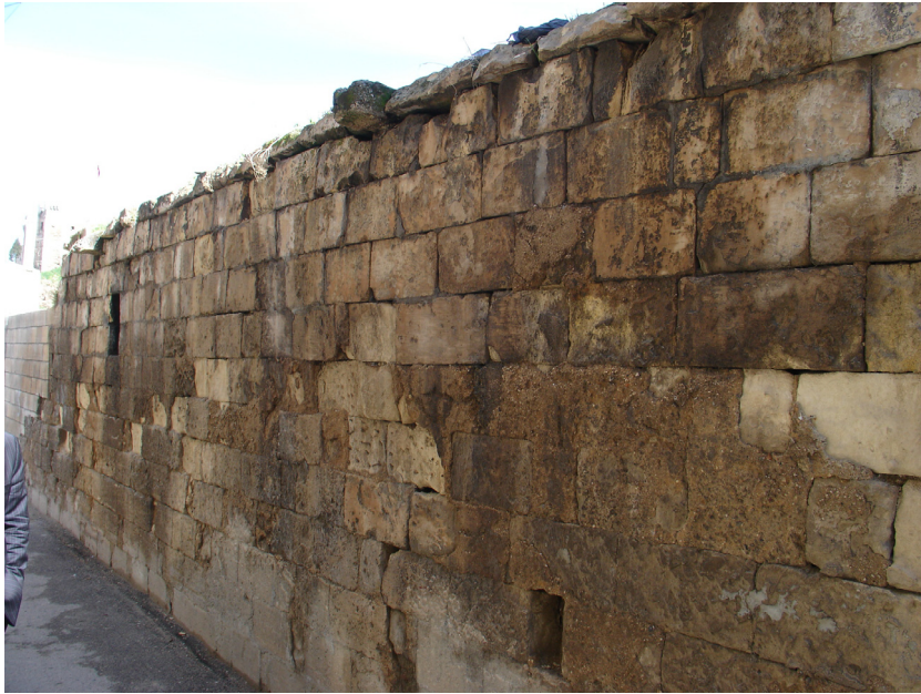
Fotoğraf 4.173 Batı Cephe
