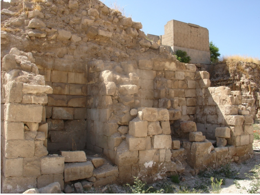
Fotoğraf 4.146 Z50,51,52 Doğu cephe görünümü
