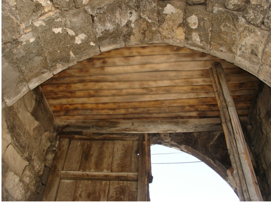
Fotoğraf 4.109 Z16 Ahşap Kirişleme Üst Örtü
