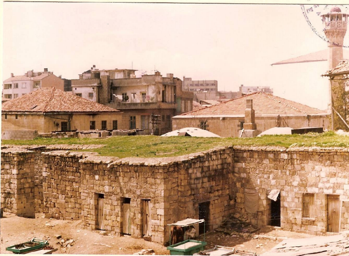
Foto 12- Hanın avluya bakan batı cephesinden detay görünüşü (geri planda Handaniye Camii).
