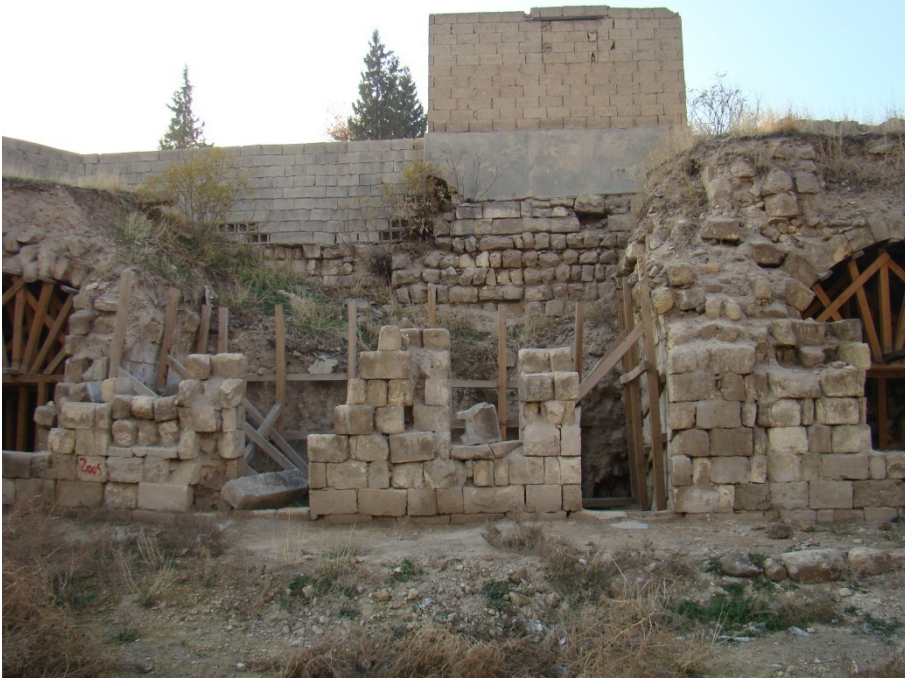
Fotoğraf 4.149 Z54 Doğu cephe görünümü
