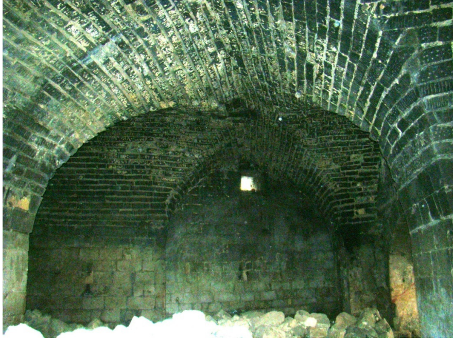
Fotoğraf 4.152 Z56 güney bölümü, çapraz tonoz üst örtü
