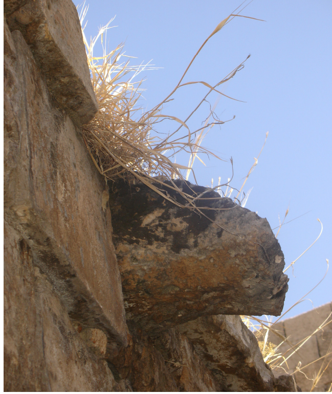
Fotoğraf 4.175 Batı Cephe
