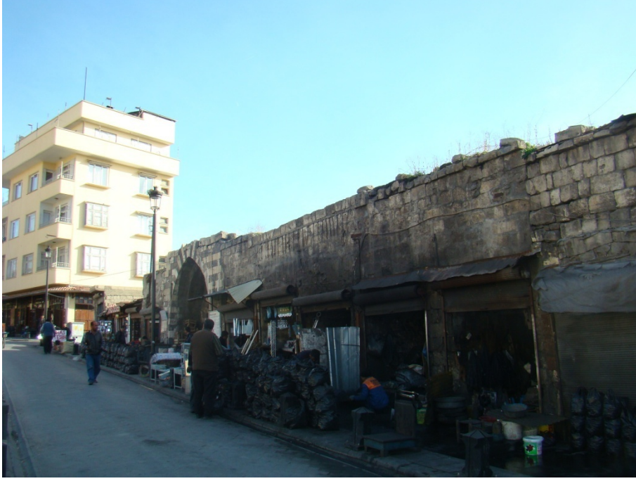
Fotoğraf 4.98 Kuzey Cephe batı dükkanları
