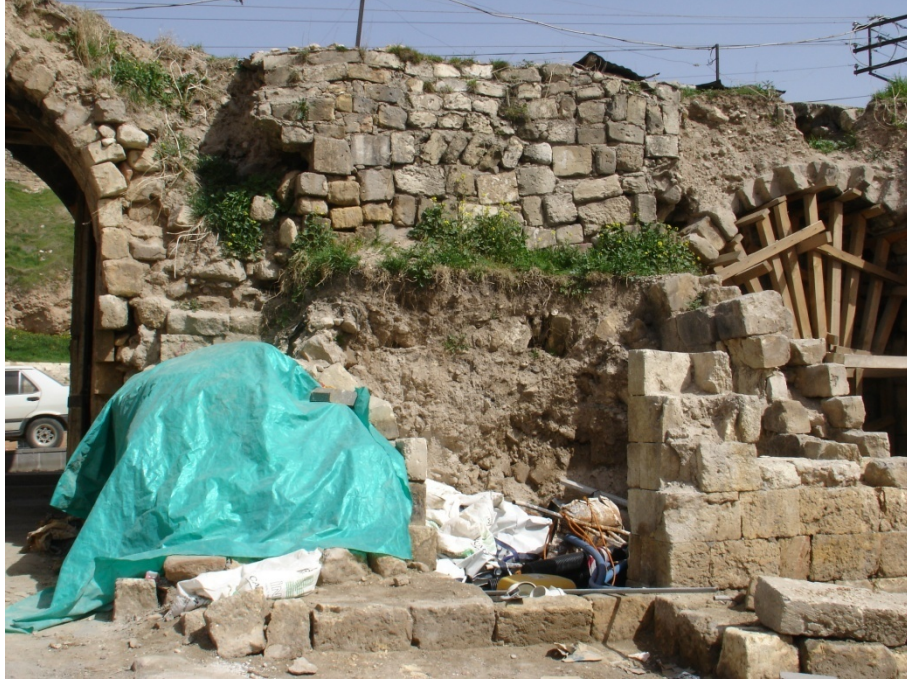
Fotoğraf 4.117 Z17 Güney cephe görünümü
