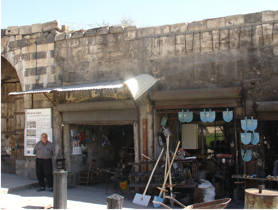
Fotoğraf 4.168 Kuzey cephe batı dükkanları
