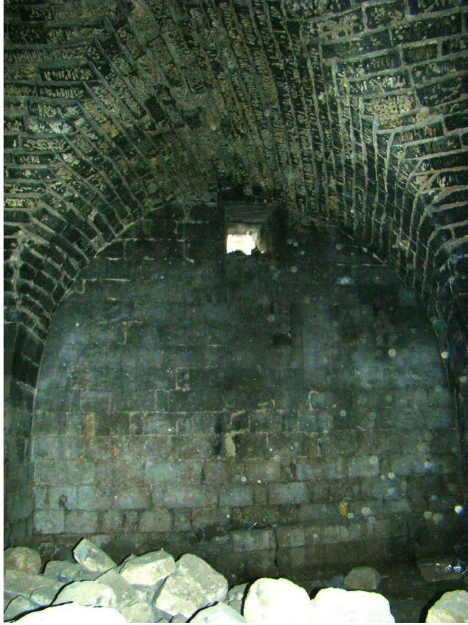
Fotoğraf 4.152 Z56 güney bölümü, çapraz tonoz üst örtü
