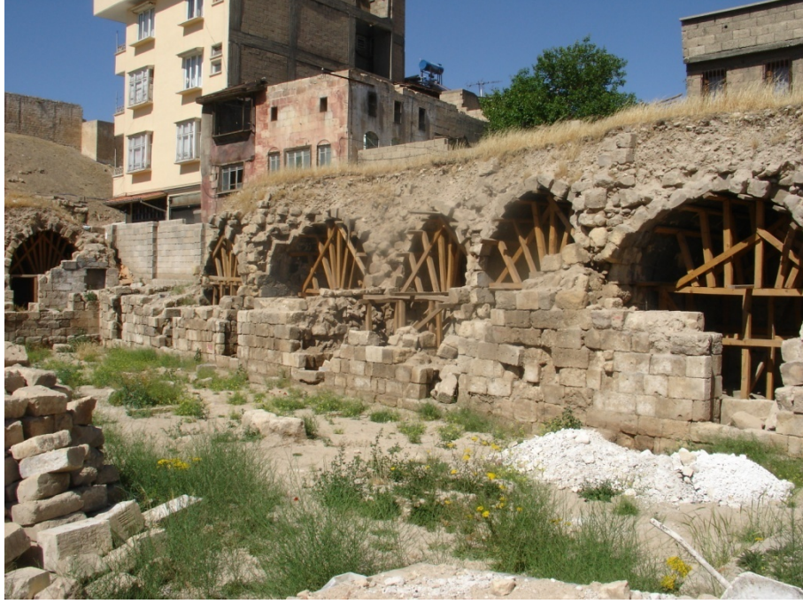
Fotoğraf 4.119 Doğu kanadı görünüm
