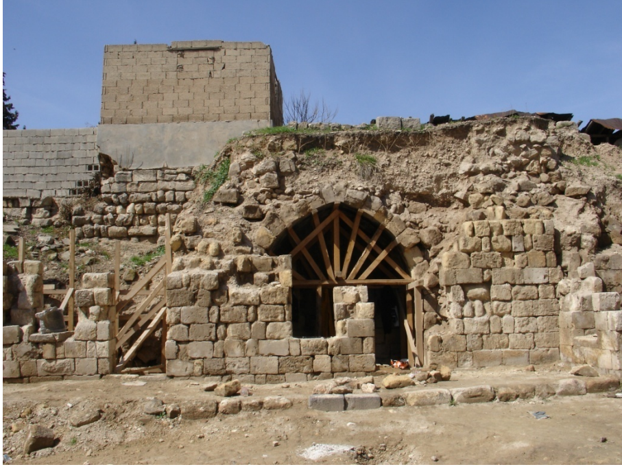
Fotoğraf 4.150 Z 55 Doğu cephe görünümü
