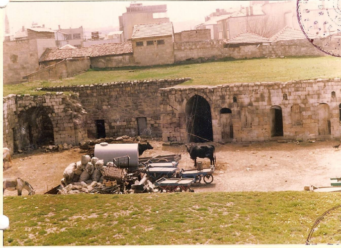
Foto 14- Hanın avluya bakan güney cephesinin görünüşü.
