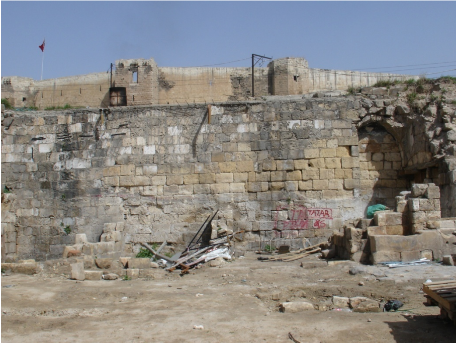
Fotoğraf 4.113 Kuzeybatı kanadının güney cephe görünümü
