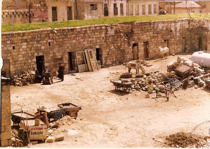
Foto 8- Hanın avluya bakan doğu cephesinin görünüşü.
