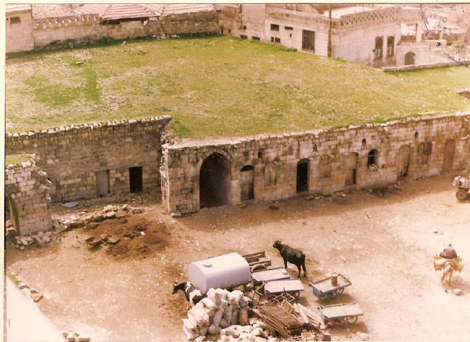
Foto 15- Hanın avluya bakan güney cephesinin kusbakışı görünüşü.
