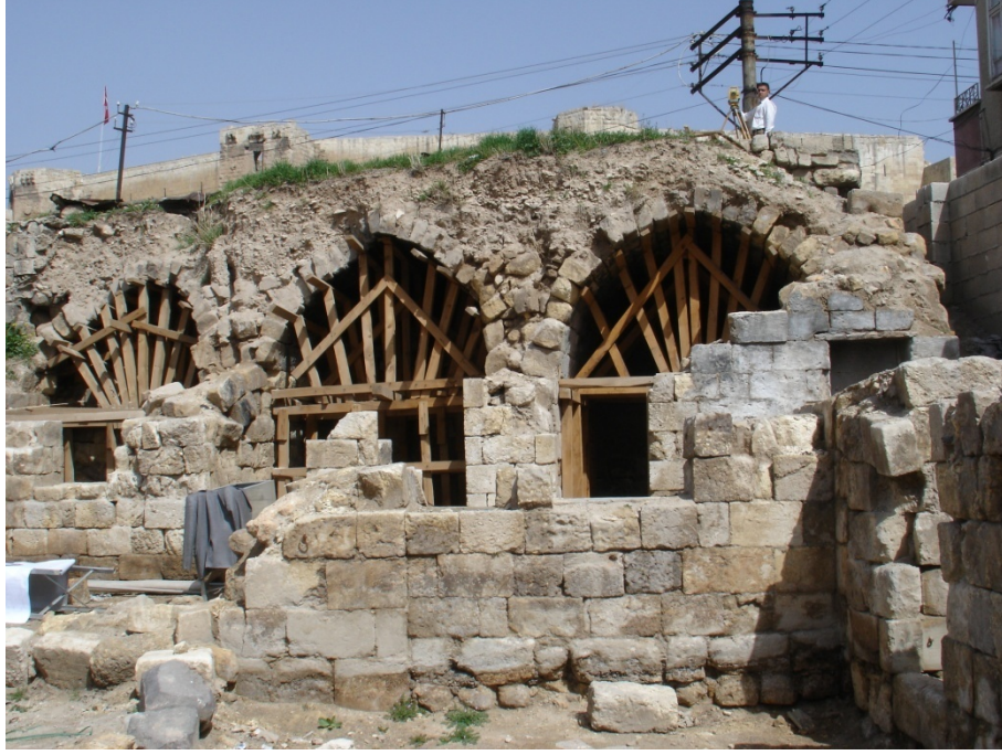
Fotoğraf 4.118 Z19-Z20- Z21 Güney cephe görünümü
