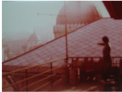
Fotoğraf 3.43 Çatı Örtüsü
