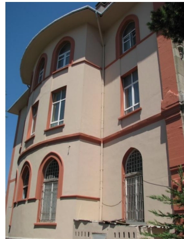
Fotoğraf 3.68 Şehzadebaşı V.Vakıf Han Güneybatı Cephe Pencereleri (F.B Erol-2013)
