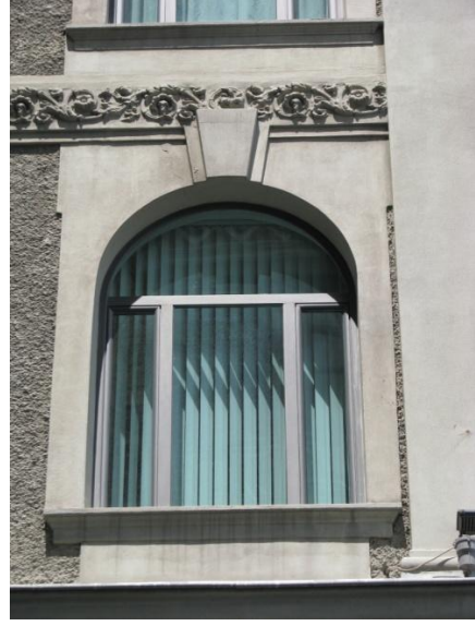
Fotoğraf 3.100 VI. Vakıf Han Kemankeş Caddesi Güney Cephesi 2.kat penceresi (F.B Erol-2013)
