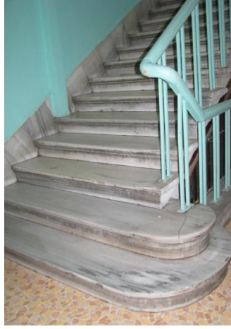
Fotoğraf 3.75 Şehzade başı V. Vakıf Han Mermer Kaplı Kat Merdiveni (F.B Erol -2013)
