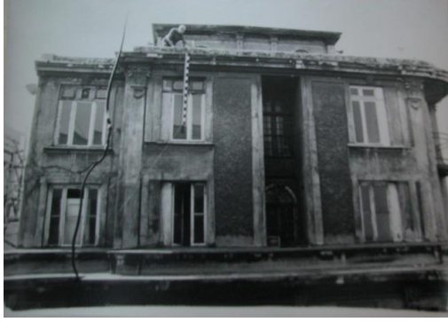
Fotoğraf 3.92 VI. Vakıf Han Cephesi Kemankes Caddesine Bakan Son İki Kat
