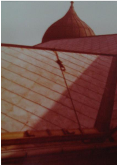
Fotoğraf 3.42 Çatı Örtüsü
