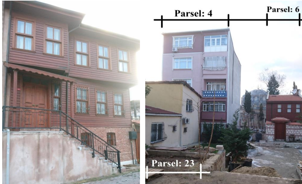
Şekil 3.28 9 Numaralı Parsel Kuzey Doğu ve Arka Bahçesinden Görünümü (Furkan Kaplan, 2017)
