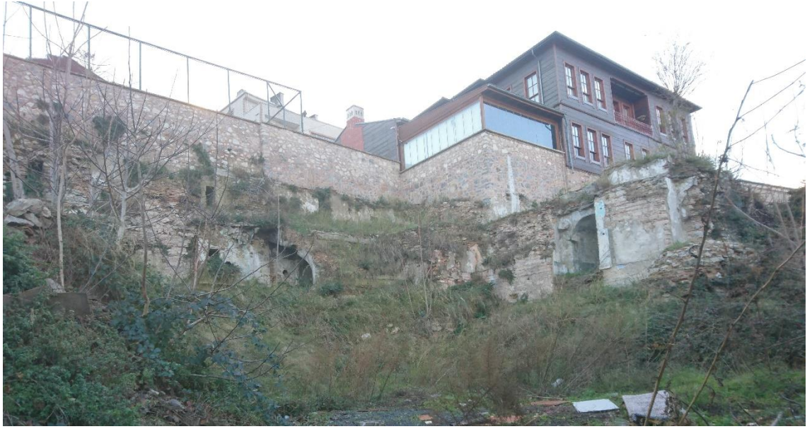
Şekil 3.34 İstinat Duvarı ve Blakhernai Sarayı Kalıntıları (Furkan Kaplan, 2017)
