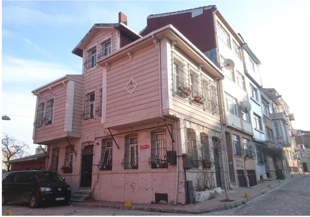
Şekil 3.117 7 Numaralı Parsel, Şişhane Caddesinden Bakış (Furkan Kaplan, 2017)
