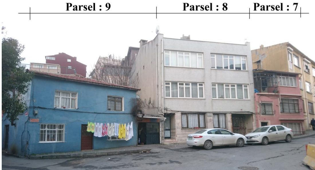
Şekil 3.37 Dervişzade Sokağına Bakan Yapılar (Furkan Kaplan, 2017)
