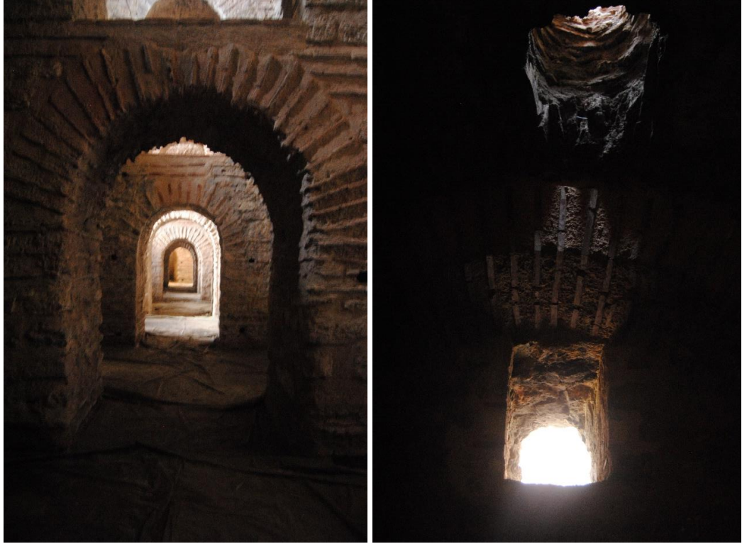
Şekil 3.50 Bodrum Kat Koridoru ve Havalandırma Bacası
