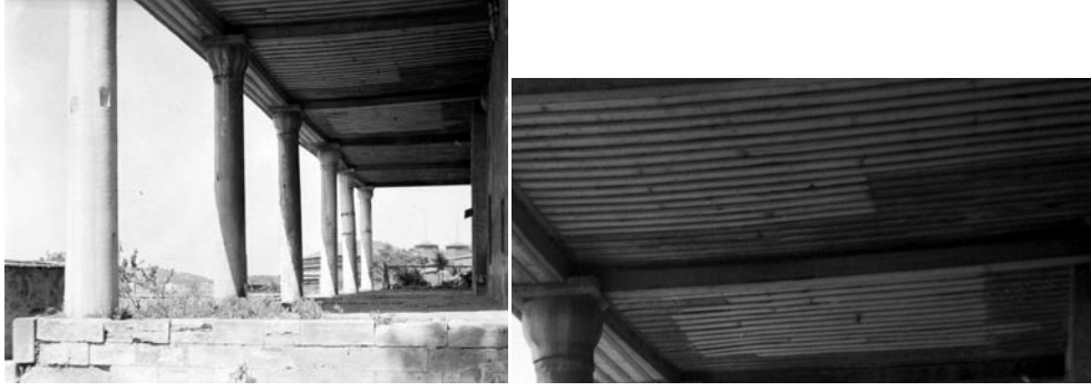
Fotoğraf 3. 40 Son Cemaat Yerinde Bulunan Ek Yapının Kaldırılması ve Revak Ahşaplarının Onarılması (Encümen Arşivi, 1940)
