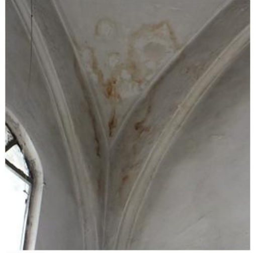
Fotoğraf 3. 148 Türbe Kalem İşi Süslemelerinde ve Tabhâne Duvarlarında Nemin Yol Açtığı Mantarlaşma Tahribatı
