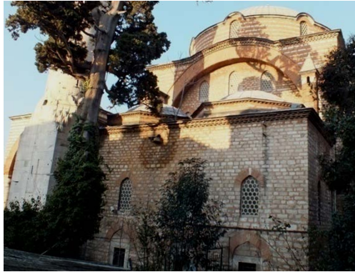
Fotoğraf 3. 98 Caminin Batı Cephesinde Aktarım Sistemi Elemanının İşlevini Yerine Getirememesinden Dolayı Oluşan Nemlenme
