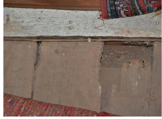
Fotoğraf 3. 66 Kadınlar Mahfili Giriş Kat Döşemesine Ait Özgün Ahşap Doku
