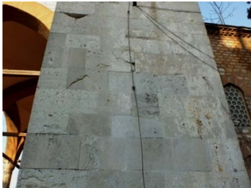
Fotoğraf 3. 103 Kalsiyum Karbonat Tuzlarının Yol Açtığı Kabuk Oluşumu ve Oluşan Tahribat
