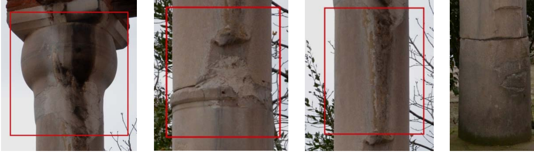
Fotoğraf 3. 112 Son Cemaat Yerinin Sol Kolunun En Ucunda Yer Alan Sütun Üzerinde Görülen Bozulmalar
