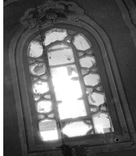
Fotoğraf 3. 78 Türbe İçinde Tahrip Olmuş Pencere Dışlığı (1940)
