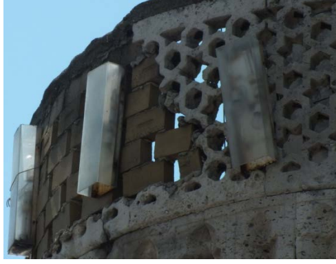
Fotoğraf 3. 36 Minare Şebekesinin Kırılan Bölümüne Yapılan Muhdes Tamamlama
