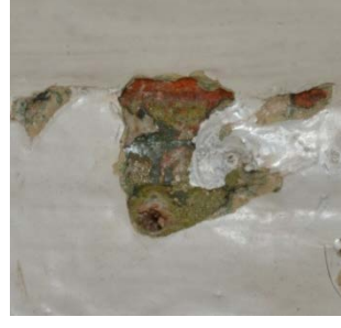
Fotoğraf 3. 88 Boyalı Kadınlar Mahfilinin Ahşaplarının Altında Görülen Boya Tabakası
