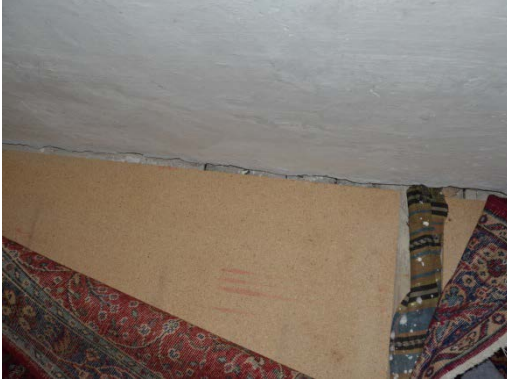
Fotoğraf 3. 65 Kadınlar Mahfili Üst Kat Döşemesinin Sunta Malzeme İle Güçlendirilmesi
