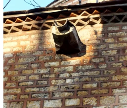
Fotoğraf 3. 98 Caminin Batı Cephesinde Aktarım Sistemi Elemanının İşlevini Yerine Getirememesinden Dolayı Oluşan Nemlenme
