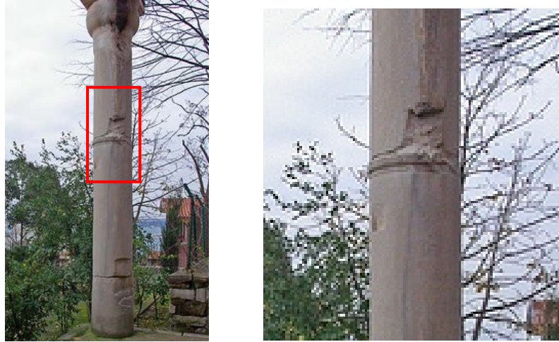
Fotoğraf 3. 45 Son Cemaat Yerinin Solunda Bulunan Sütunun Yer Değiştirmiş Parçalarının Görünüş ve Detayı
