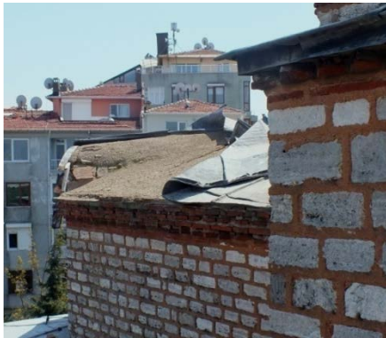
Fotoğraf 3. 126 Güneydoğuda Yarım Kubbe Üzerinde Dağılmış Kurşun Plaka
