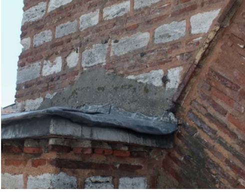
Fotoğraf 3. 100 Çimento Katkılı Harç Kullanımı
