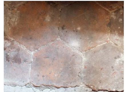
Fotoğraf 3. 63 Son Cemaat Yerine Bakan Duvarın Kuzeydoğu Yönünde Yer Alan Pencere Sahanlığında Bulunan Özgün Tuğla Döşeme Örneği
