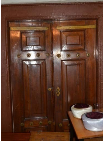
Fotoğraf 3. 107 Giriş Cephesinde, Kuzeybatı Duvarında Bulunan Pencerenin Ahşap Kepengi
