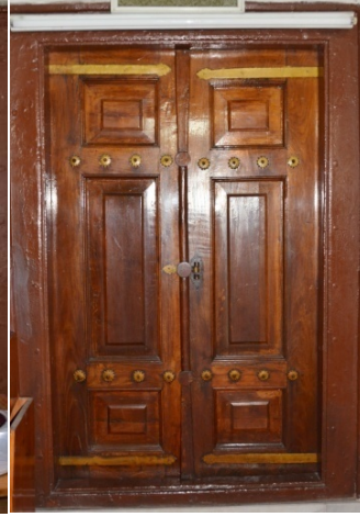
Fotoğraf 3. 108 Giriş Cephesinde, Kuzeydoğu Duvarında Bulunan Pencerenin Ahşap Kepengi
