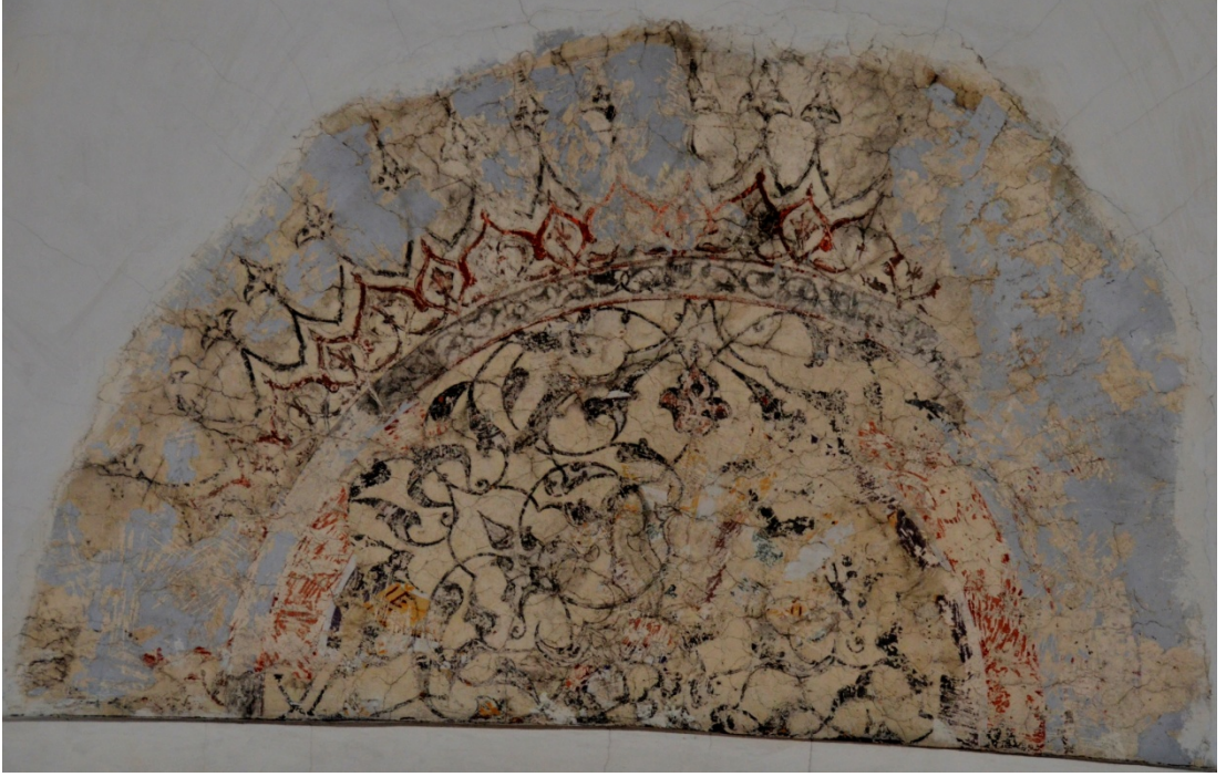
Fotoğraf 3. 141 Kalem İşlerinde Donma-Çözülme Mekanizmasının Neden Olduğu Çatlama, Dökülme vb. Tahribatlar
