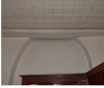
Fotoğraf 3. 87 Kadınlar Mahfilinin Tavanının Pencere Kemerleriyle Çakıştığı Nokta
