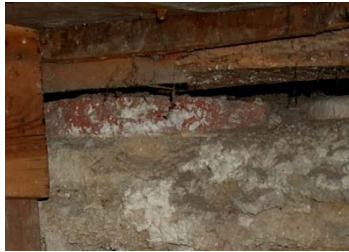
Fotoğraf 3. 121 Harim Kısımında Muhdes Ahşap Kaplamanın Altında Bulunan Tuğla Doku
