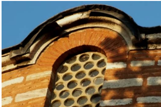
Fotoğraf 3. 99 Caminin Batı Cephesinde Dağılmış Kurşun Levhalar
