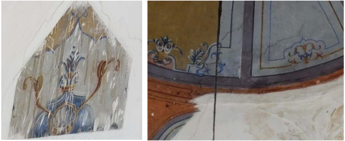
Fotoğraf 3. 105 Türbenin Kuzey Duvarında Yer Alan Kalem İşi Örneği
