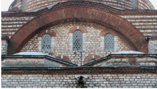
Fotoğraf 3. 101 Doğu Cephede, Kurşun Levhaların Duvarla Birleşme Yerlerinde Çimento Kullanımı
