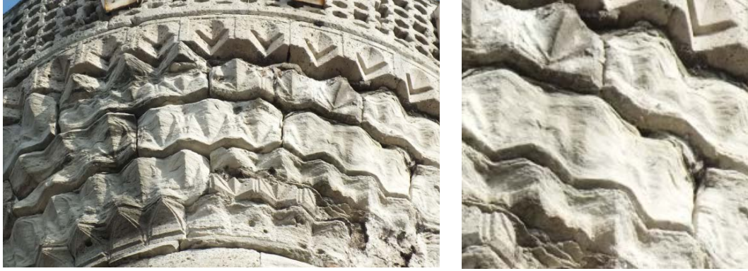
Fotoğraf 3. 128 Minare Şerefesi Mukarnaslarında Rüzgârın ve Atmosferik Asitlerin Neden Olduğu Aşınmalar
