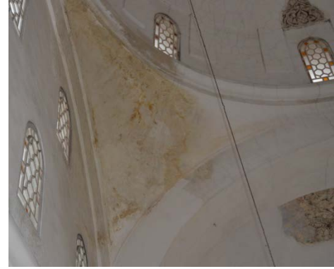
Fotoğraf 3. 97 Caminin Güneydoğu Cephesinde Dağılmış Kurşun Levhaların İç Mekânda Sebep Olduğu Tahribat
