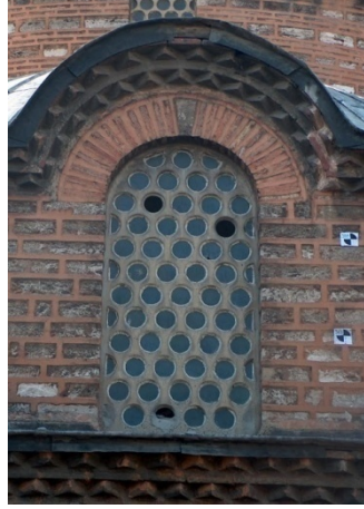
Fotoğraf 3. 30 Yarım Kubbe Kasmağında Bulunan ve Silme Üzerine Taşırılan Pencere Detayı (Vakıflar 2.Bölge Müdürlüğü Arşivi)
