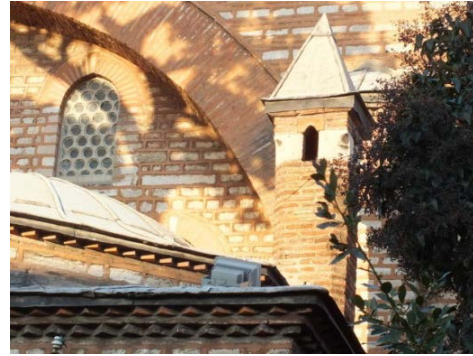
Fotoğraf 3. 60 1953 Onarımında Yapılan Bacanın Günümüzdeki Durumu
