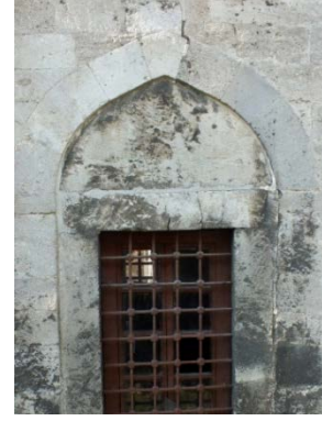
Fotoğraf 3. 131 Türbenin Doğusunda, Pencere Kemerinde Açılma
