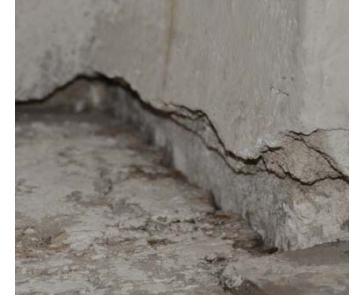
Fotoğraf 3. 89 Boyalı Kadınlar Mahfilinin Yapıyla Birleşme Noktaları
