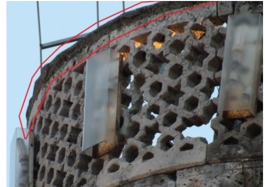
Fotoğraf 3. 102 Çimento İle Yapılan Hatalı Restorasyon Uygulaması
