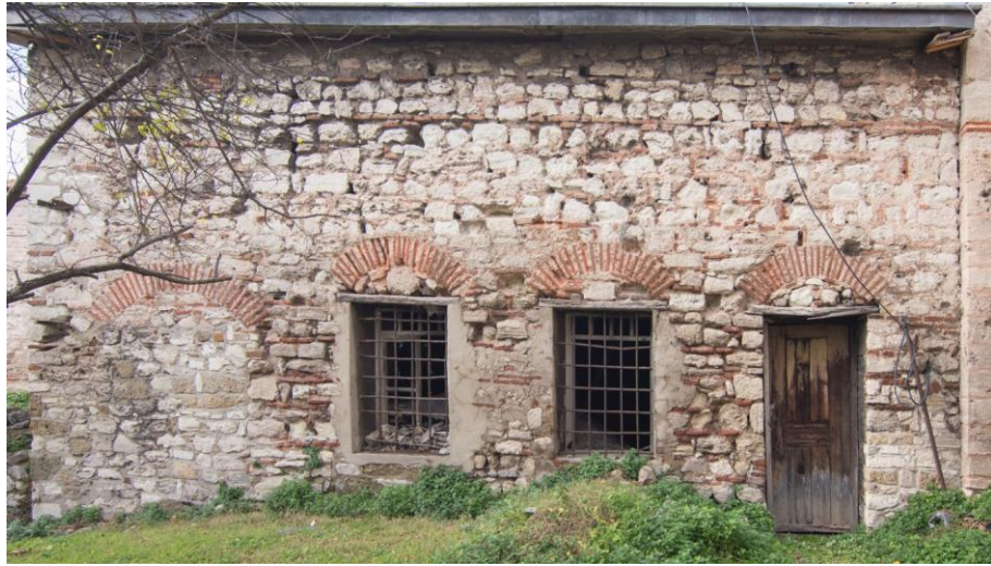
Şekil 2.50. Güneydoğu cephesinde yer alan kapı ve pencerelerin görünümü
