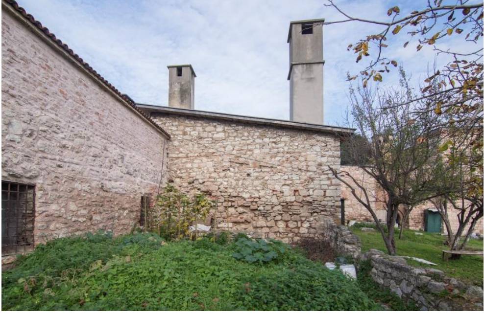
Şekil 2.52. Yapının güneybatı cephesi
