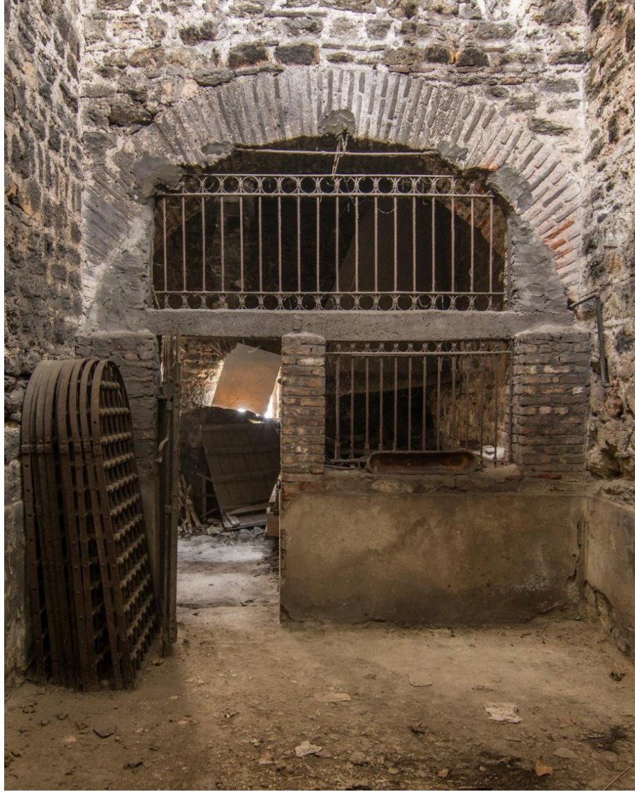
Şekil 2.54. Mekanları bölen harman tuğla örgülü kagir duvarın görünümü
