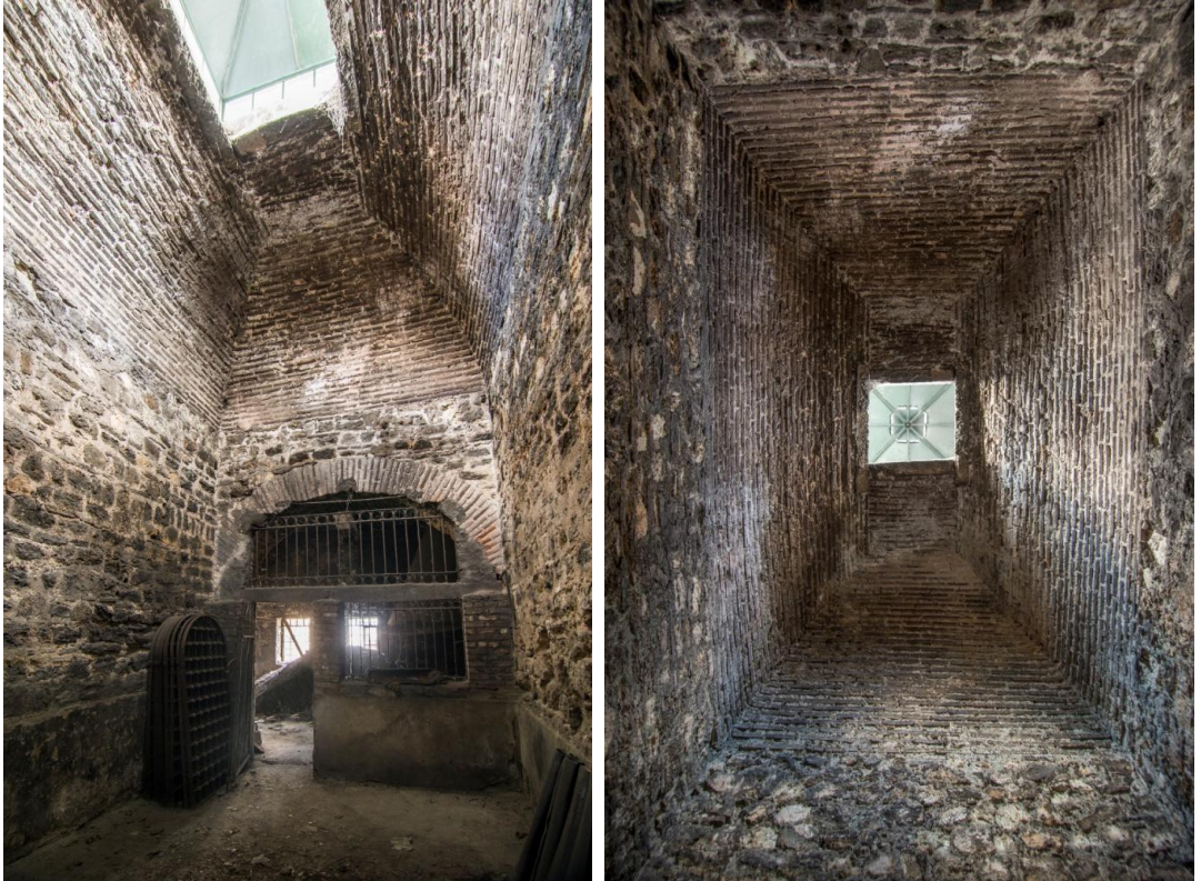
Şekil 2.44. Z02 mekanı duvar-tonoz birleşimi ve örtü sisteminin görünümü
