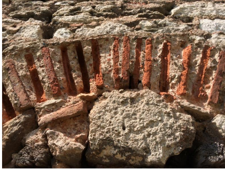
Şekil 2.67. Güneydoğu cephesi pencere üzerinde yer alan kemer tuğlalarında meydana gelmiş yüzey kayıpları
