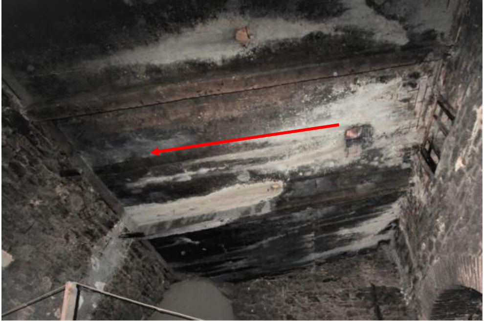
Şekil 2.36. Z01 mekanının tek yöne eğimli örtü sisteminin görünümü
