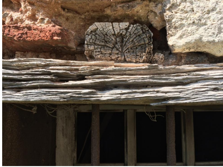
Şekil 2.65. Güneydoğu cephesi, pencere düz atkısı ve hatılda görülen ahşap bozulmaları (böcek tahribatı, malzeme kaybı)
