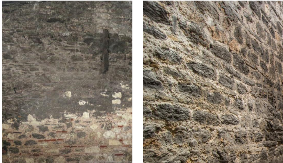
Şekil 2.69. Z01 mekanı duvar yüzeylerindeki is kirliliği (solda) Z02 Mekanı duvar yüzeylerindeki is kirliliği (sağda)
