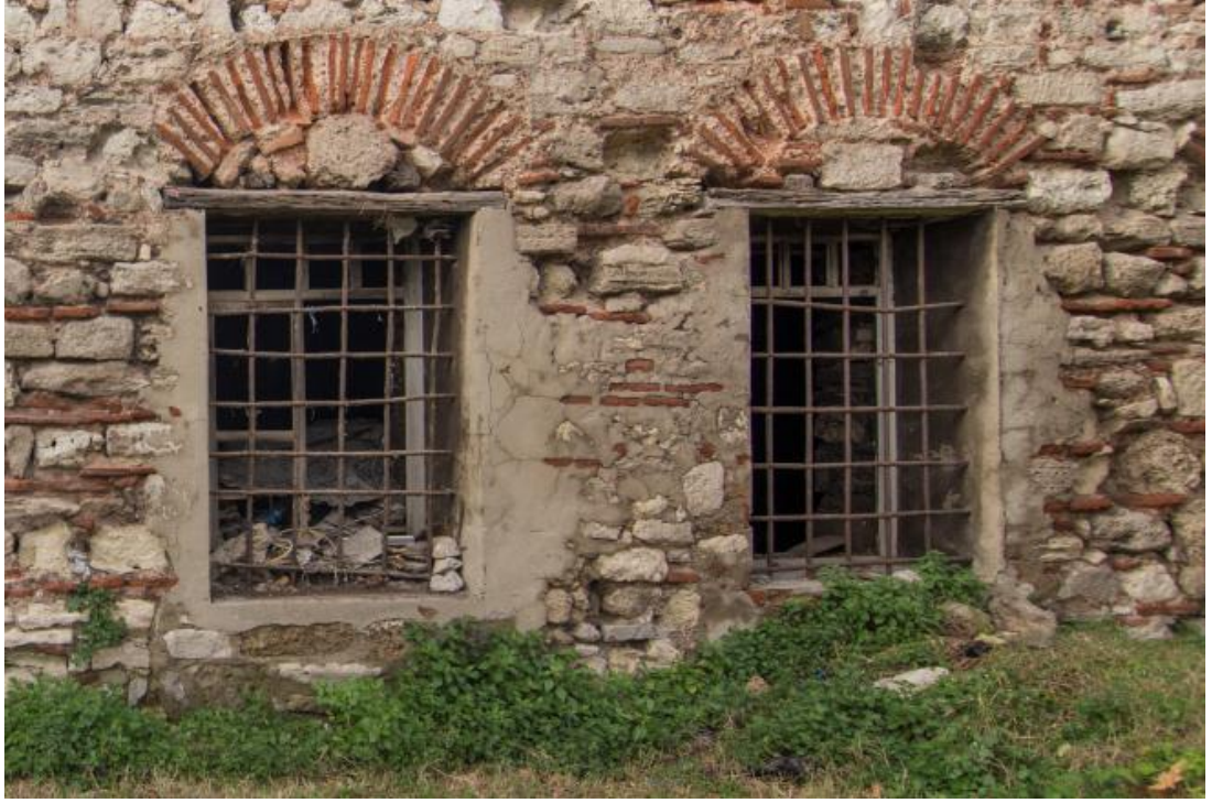
Şekil 2.33. Yapının güneydoğu cephesinde yer alan pencereler
