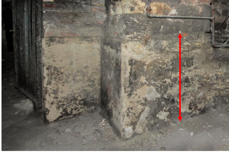
Şekil 2.57. Z01 mekanı iç sıva görünümü
