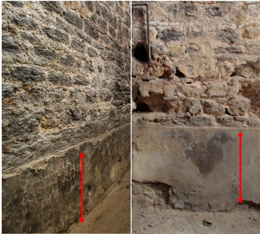
Şekil 2.58. Z02 mekanı iç sıva görünümü
