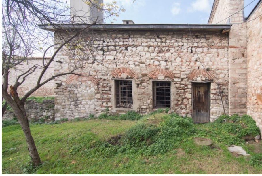
Şekil 2.49. Yapının güneydoğu cephesi
