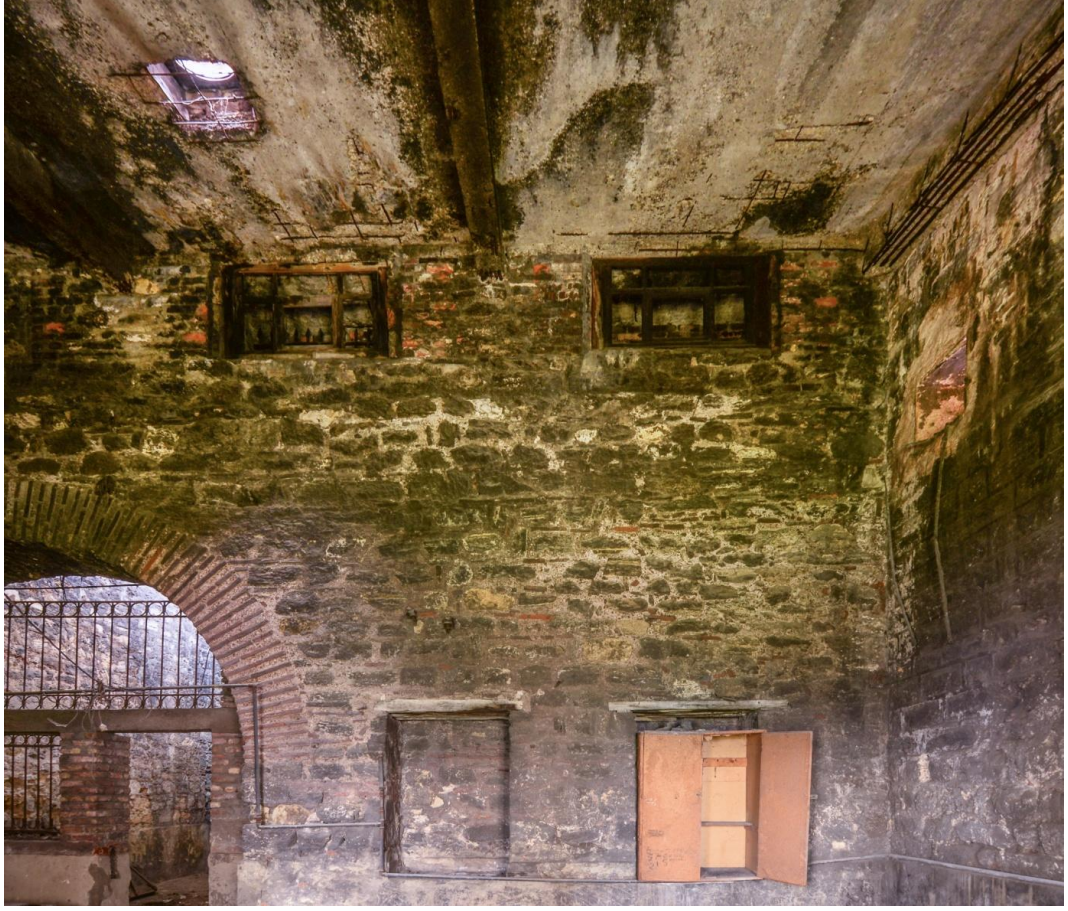
Şekil 2.31. Z01 mekânı nişler ve üzerindeki pencereler
