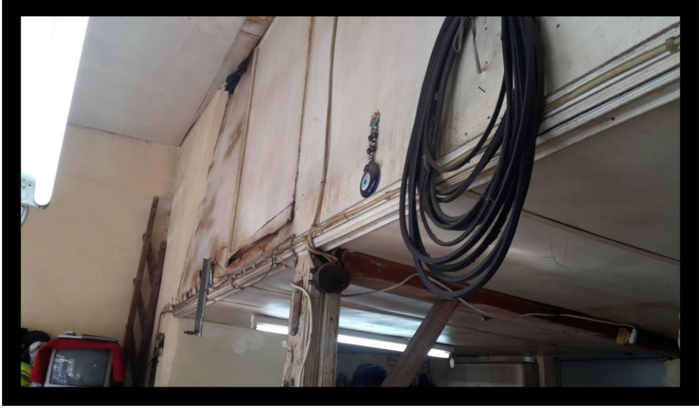
Fotoğraf 6.11: Cephe 3, Ek No 15, İç Mekan Fotoğrafı
