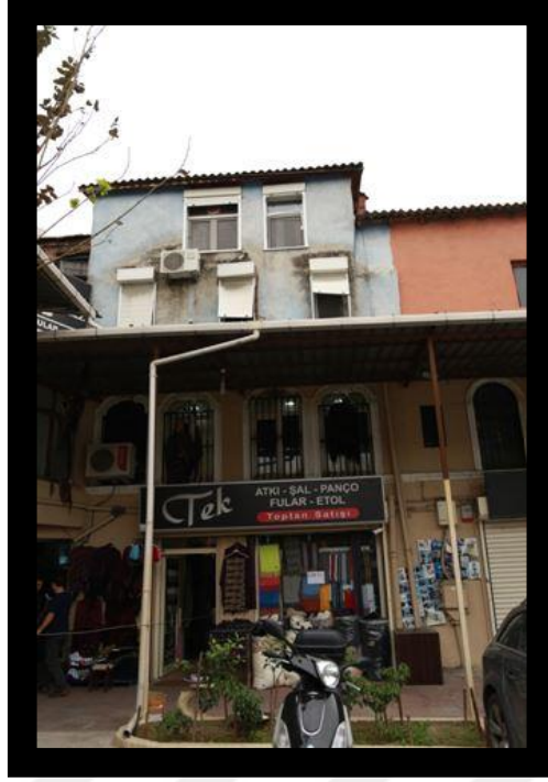
Fotoğraf 6.2 : Cephe 2, Ek No 10, Avludan Cephe Görünüş
