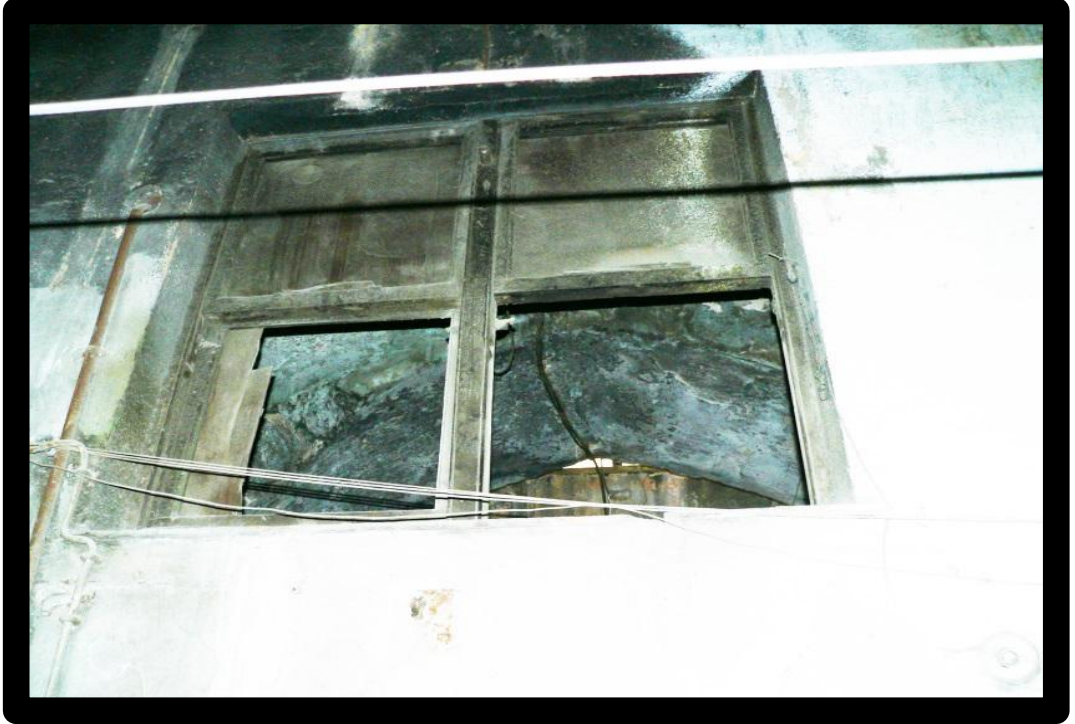
Fotoğraf 6.18: Cephe 2, Revak Koridoru, Arkadın Ekin İçinden Geçme Durumu
