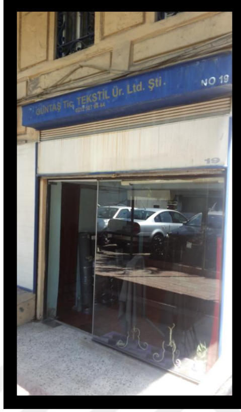
Fotoğraf 6.6: Cephe 2, Ek No 6, Avludan Cephe Görünüş
