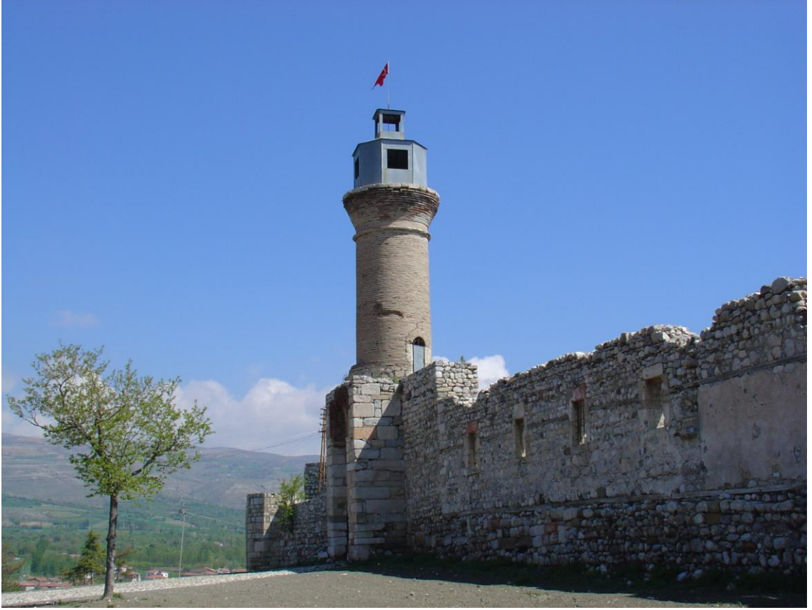
Fotoğraf -14, Zile Kalesi Saat Kulesi ve Silahlık binası batı cephesi, (A.Seçkin-2009)
