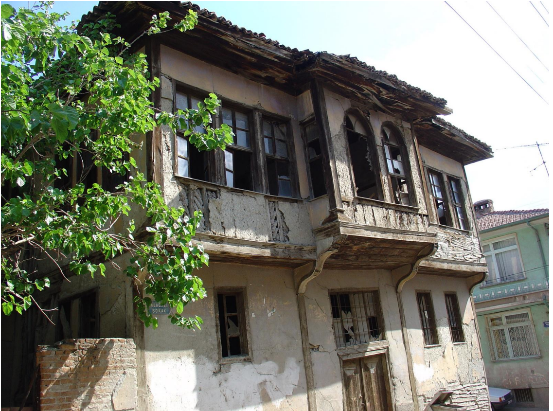
Fotoğraf -139, Gaydaroğlu Konağı Kuzey cephesi, (A.Seçkin-2009)
