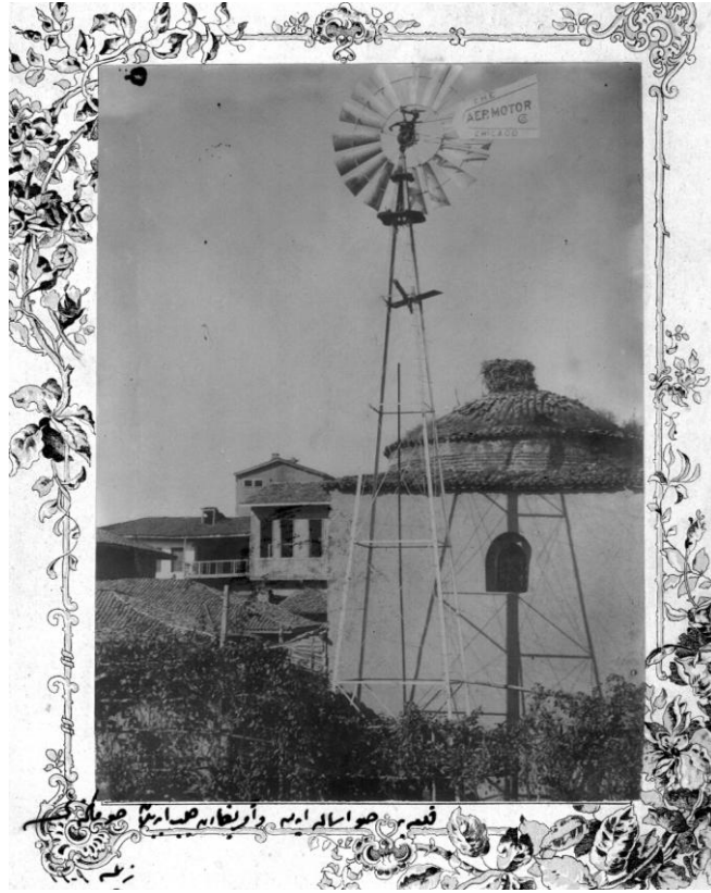
Fotoğraf-29, Bedesten arkası, kaledeki depoya su basan pompa kaynak (Zile Belediyesi-1909)
