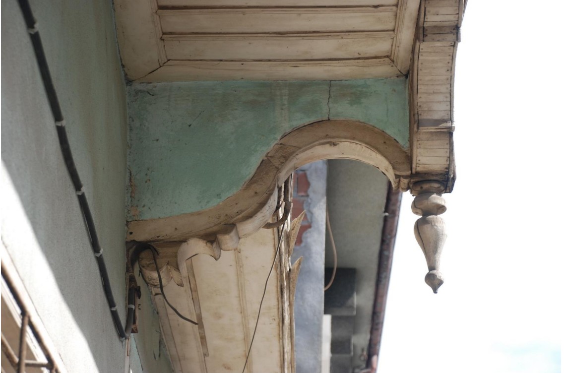
Fotoğraf -127, Gürsoy evi konsol başı ve ahşap furuş, (A.Seçkin-2009)
