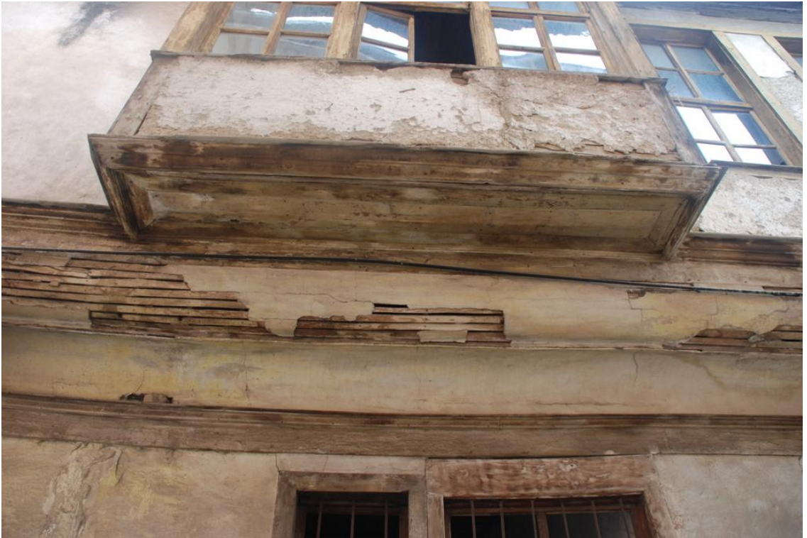
Fotoğraf -123, Sarioğlu Konağı yan cephesi bağdadi silme, (A.Seçkin-2009)
