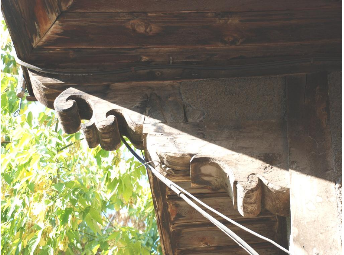
Fotoğraf -121, Göynücekli evi ahşap konsol başı, (A.Seçkin-2009)
