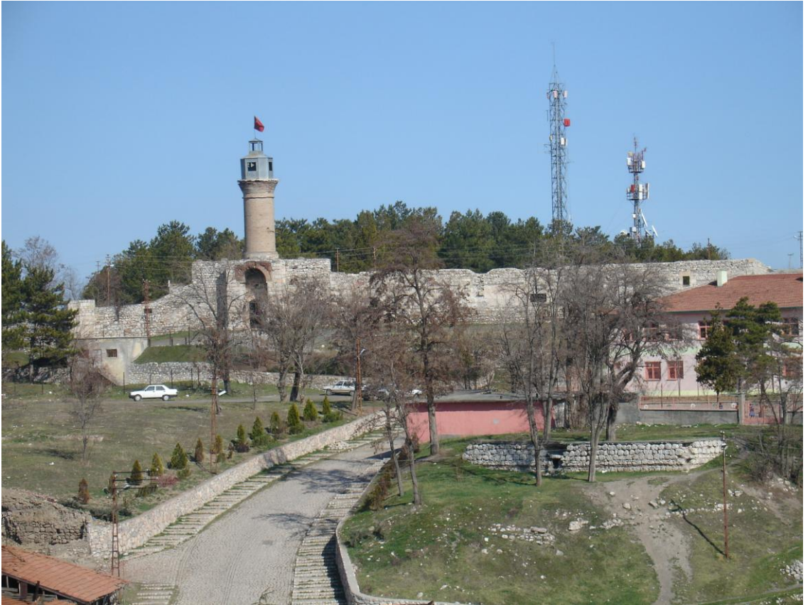
Fotoğraf -15, Zile Kalesi saat kulesi ve silahlık binası batı cephesi, (A.Seçkin-2009)
