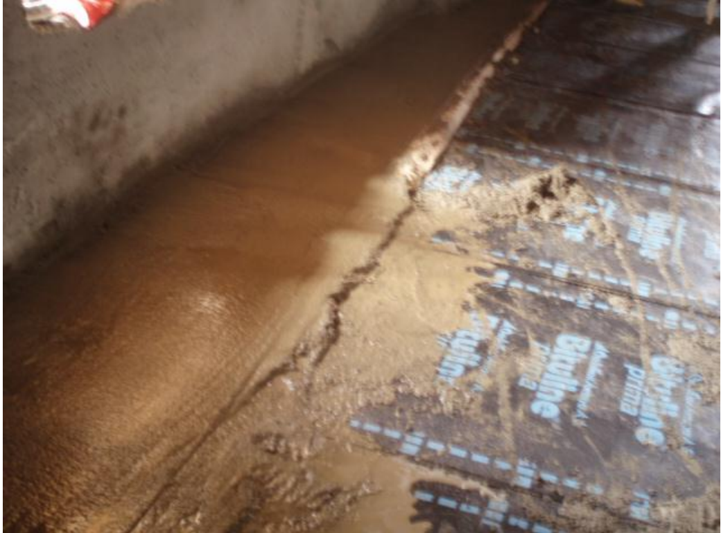
Fotoğraf 142: Zemin döşemesinde kullanılan su yalıtım maddesi (Ş. Öztürk)
