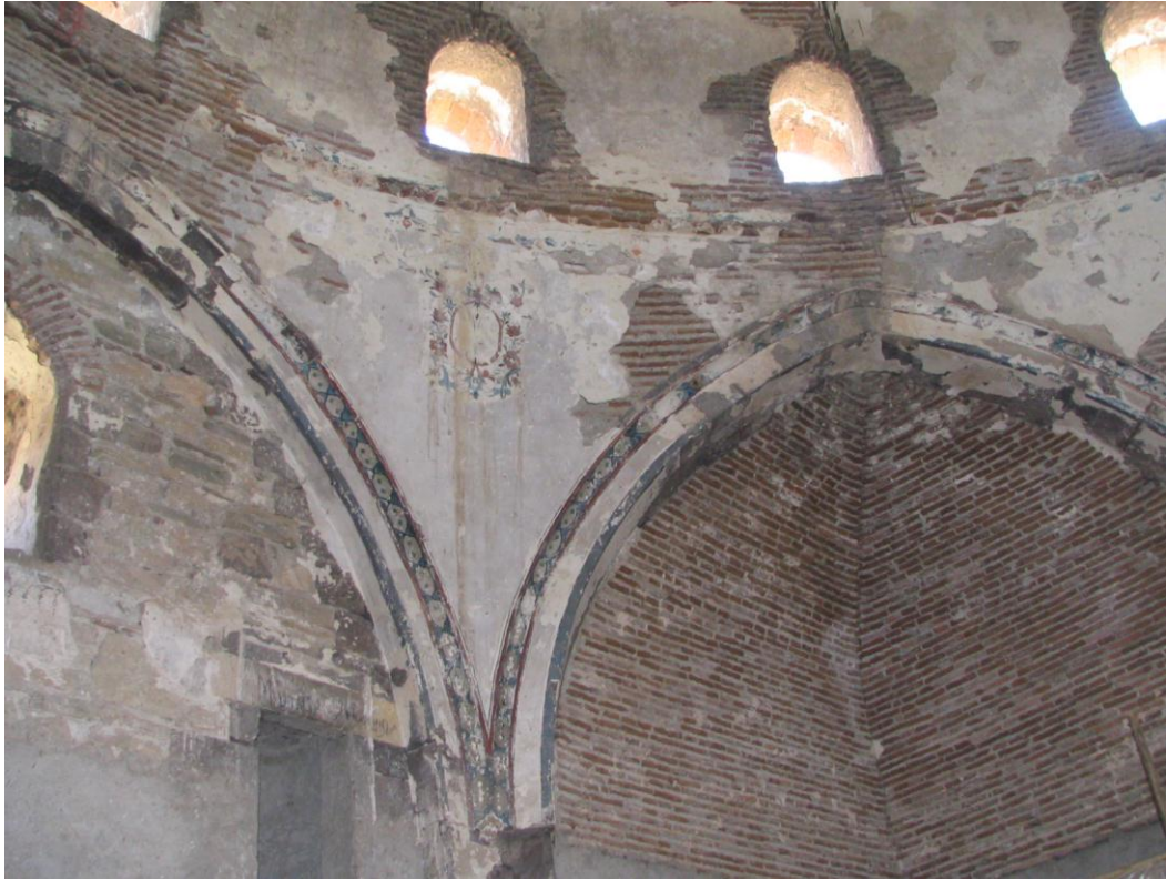
Fotoğraf 234: Islanma-kurama sonucunda hassaslaşan sıva parçaları (Ş. Öztürk)
