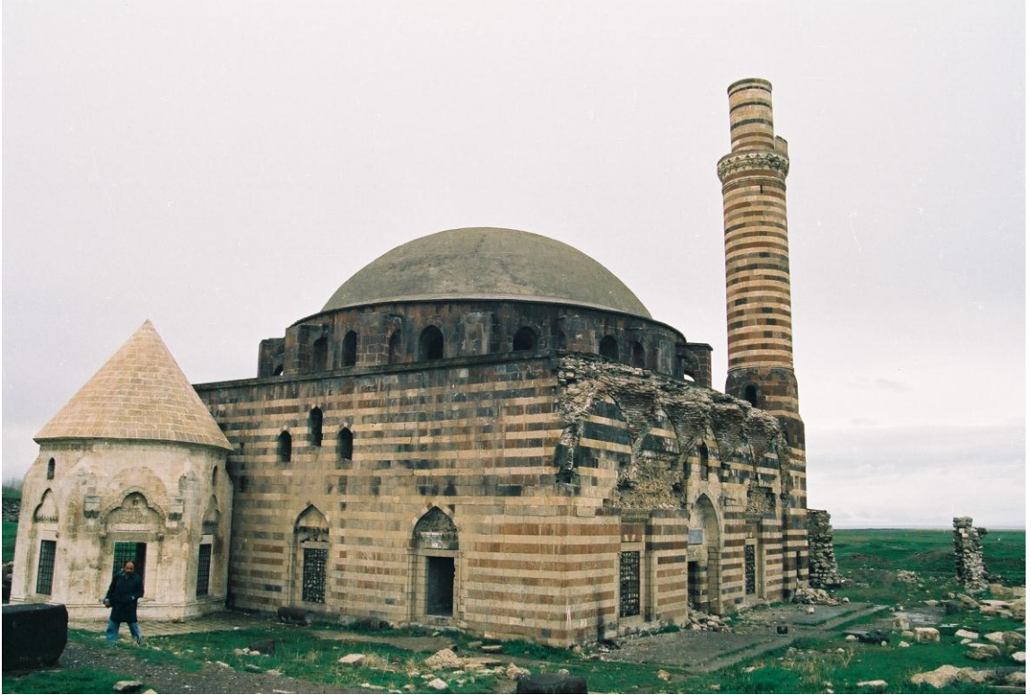
Fotoğraf 172: Kubbenin çimento ile restorasyonu (N. Kılavuz)
