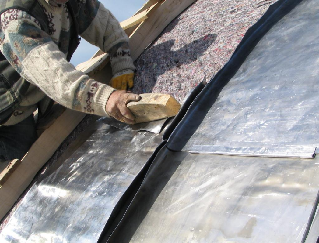
Fotoğraf 136: Kubbeye kurşun levhaların yerleştirilmesi (Ş. Öztürk)
