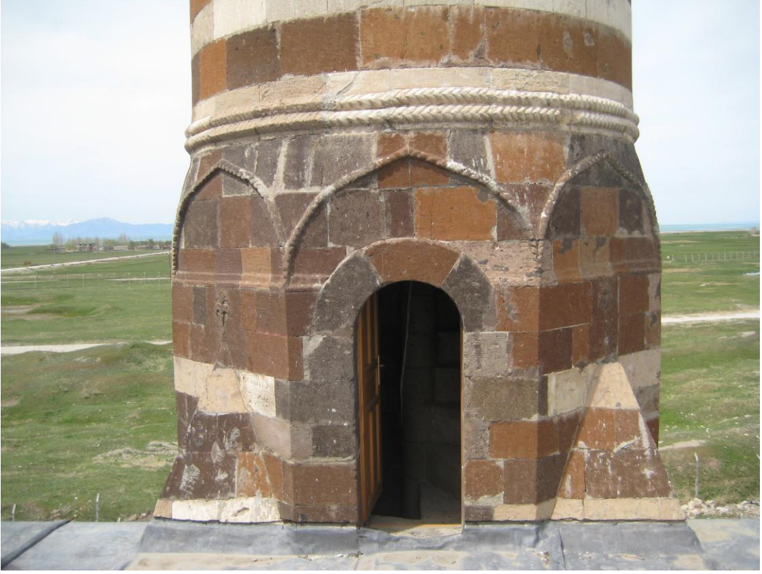
Fotoğraf 61: Minareden caminin damına çıkan kapı, batıdan
