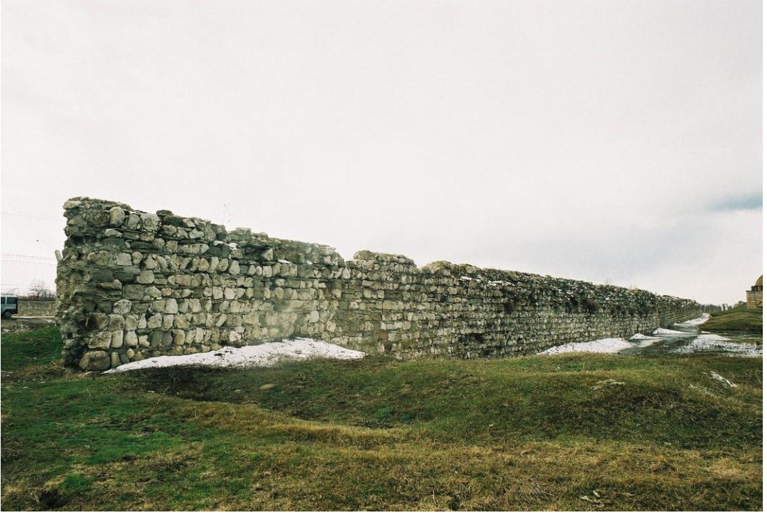
Fotoğraf 31: Güney sur kalıntılarının günümüzdeki görünümü, güneyden
