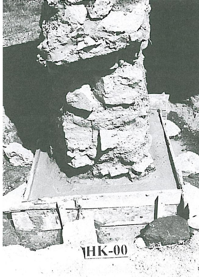
Fotoğraf 120: İmaretin koruma altına alınan güneybatı ayağı (A. Uluçam)
