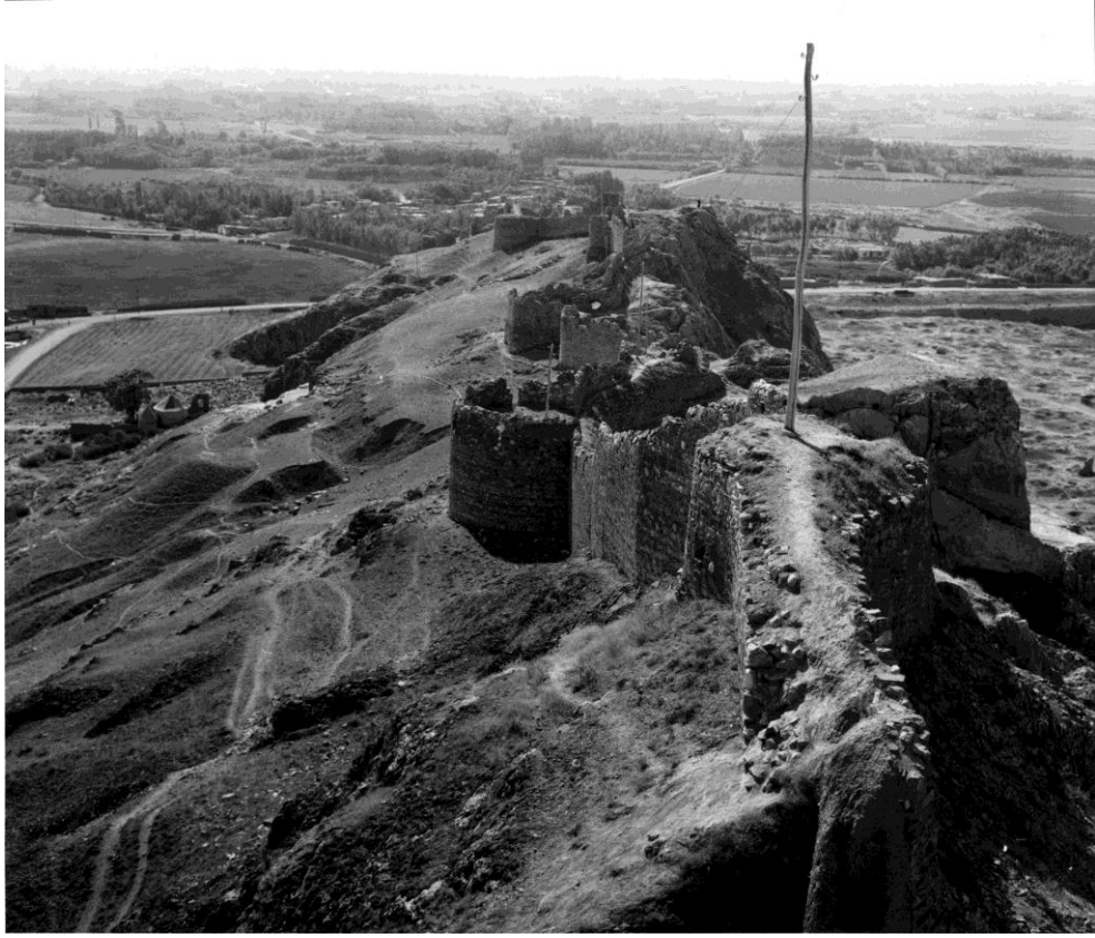
Fotoğraf 7: Aşağı Kenti korumak amacıyla doğu yönüne doğru dar bir şerit halinde devam eden savunma duvarları (N. Kılavuz)
