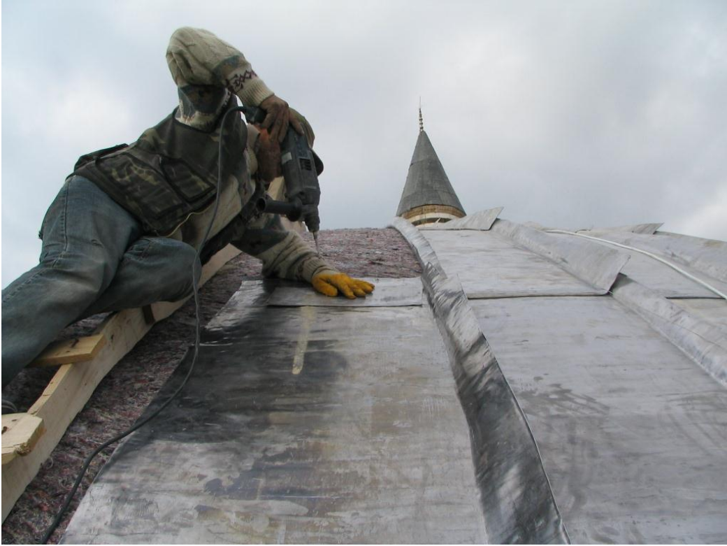
Fotoğraf 140: Kubbeye kurşun levhaların yerleştirilmesi (Ş. Öztürk)
