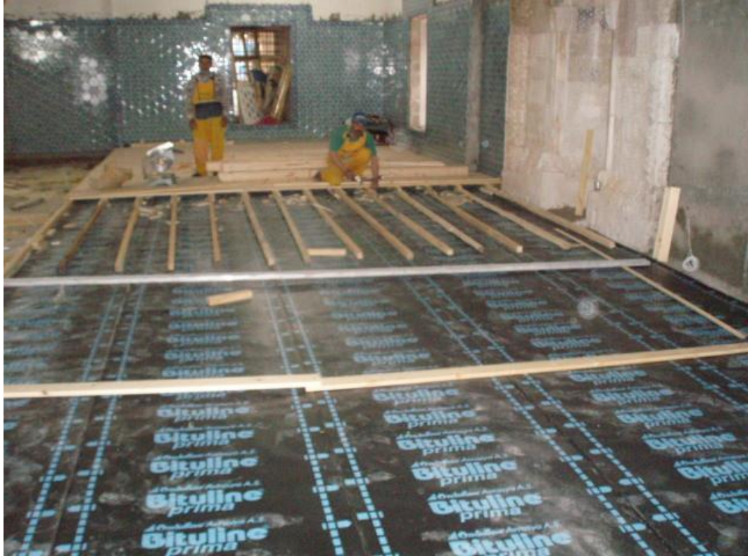
Fotoğraf 144: Yalıtım malzemesi üzerine ahşap döşemenin yapılması (Ş. Öztürk)
