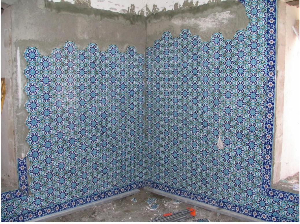
Fotoğraf 131: inilerin duvarlara yerleřtirilmesi (ř. ztürk)
