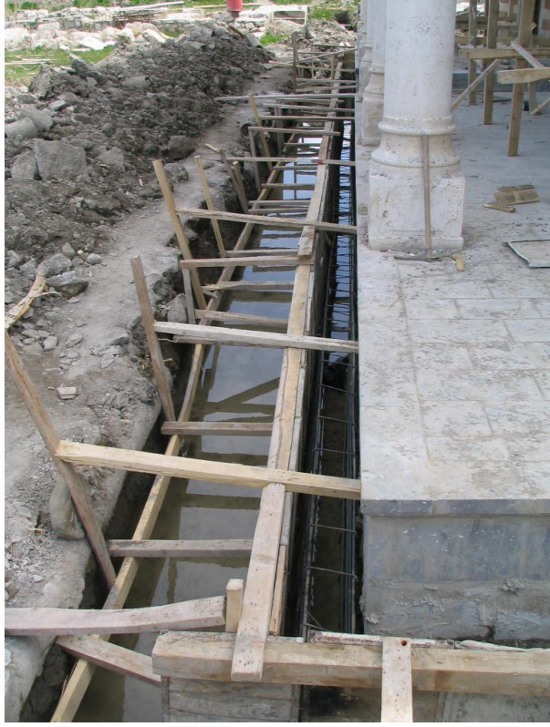
Fotoğraf 149: Açılan kanalda su tesviyesini sağlamak amacıyla eğimin oluşturulması (Ş. Öztürk)
