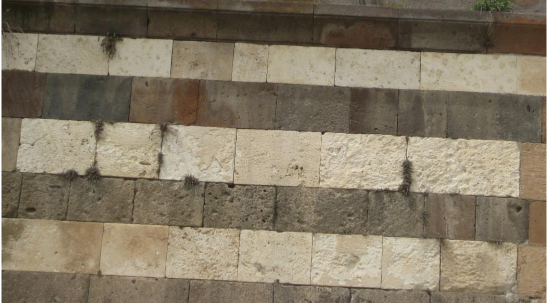
Fotoğraf 182: Taş yüzeyindeki bitkisel oluşumlar
