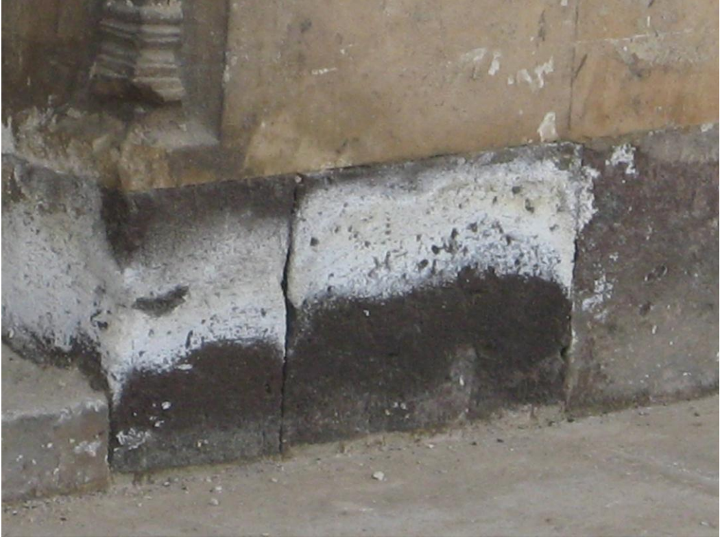
Fotoğraf 175: Tuzun etkisi ile çiçeklenmenin gözleendiđi Ahlat taşı
