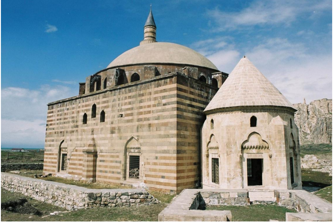
Fotoğraf 45: Güney Cephesi
