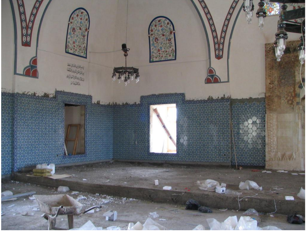
Fotoğraf 133: Çinilerin duvarlara yerleştirilmesi (Ş. Öztürk)
