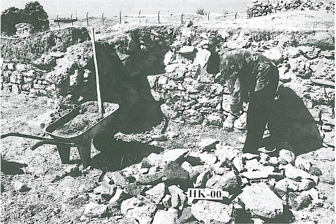
Fotoğraf 122: İmaretin batı duvarında konservasyon çalışması (A. Uluçam)
