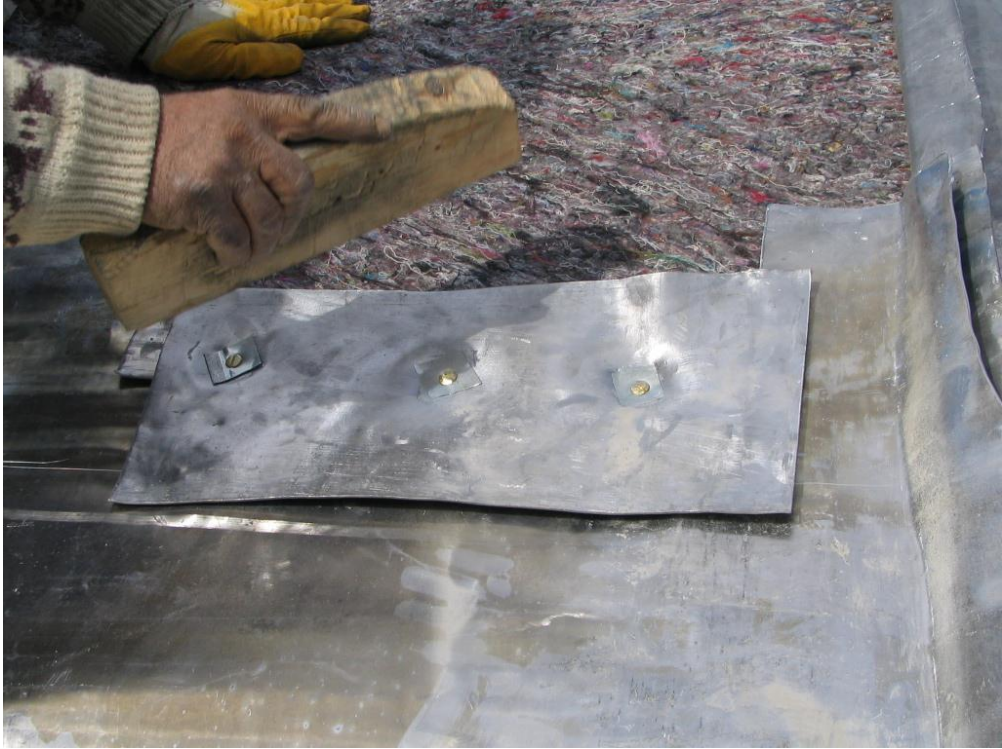
Fotoğraf 138: Kubbeye kurşun levhaların yerleştirilmesi (Ş. Öztürk)
