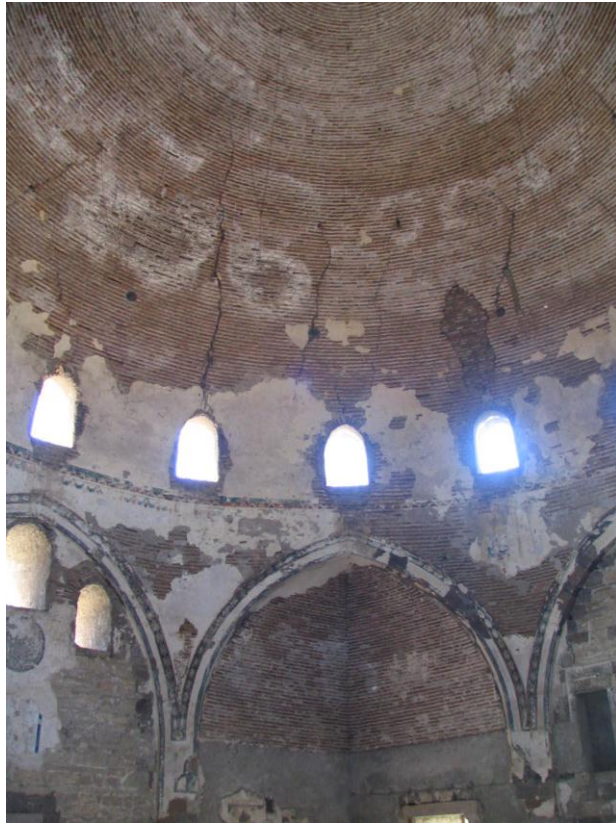
Fotoğraf 228: Hüsrev Paşa Cami'ndeki sıvaların depremlerin etkisiyle oluşan tahribatı (Ş. Öztürk)
