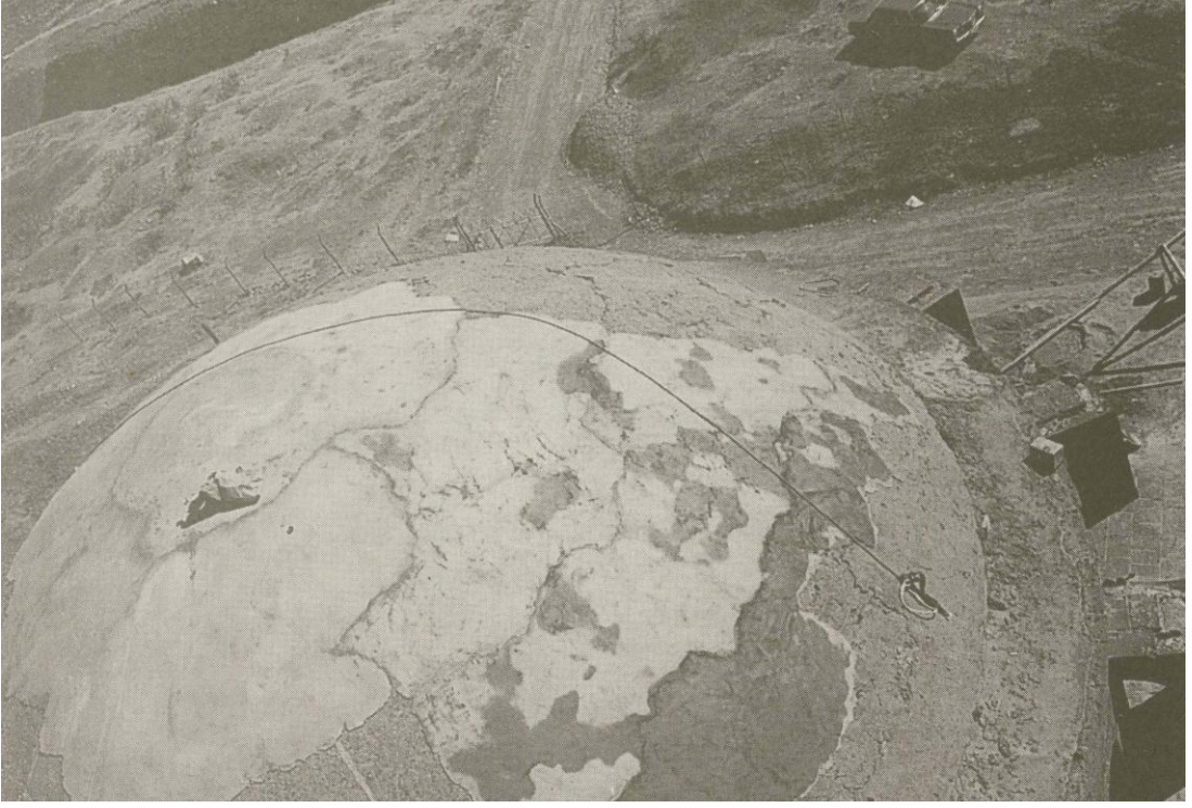
Fotoğraf 87: Kubbede yapılan onarım çalışmaları (Uluçam–Kavaklı)
