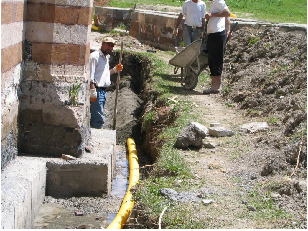
Fotoğraf 147: Cami etrafına açılan kanal (Ş. Öztürk)
