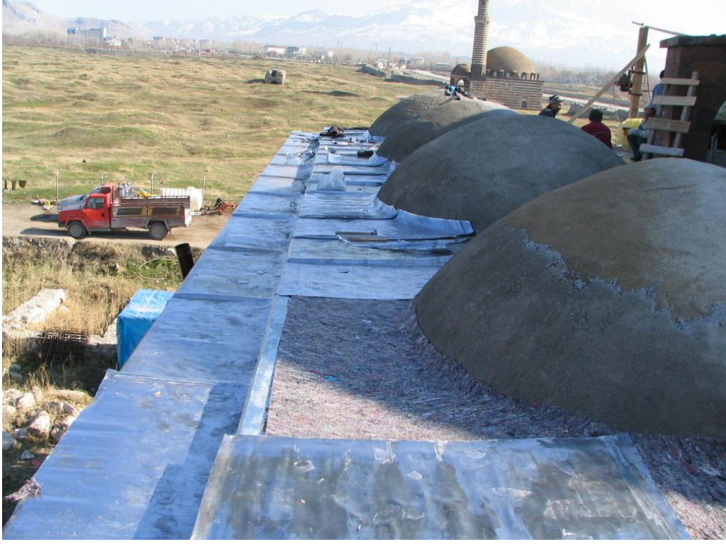
Fotoğraf 139: Kubbeye kurşun levhaların yerleştirilmesi (Ş. Öztürk)
