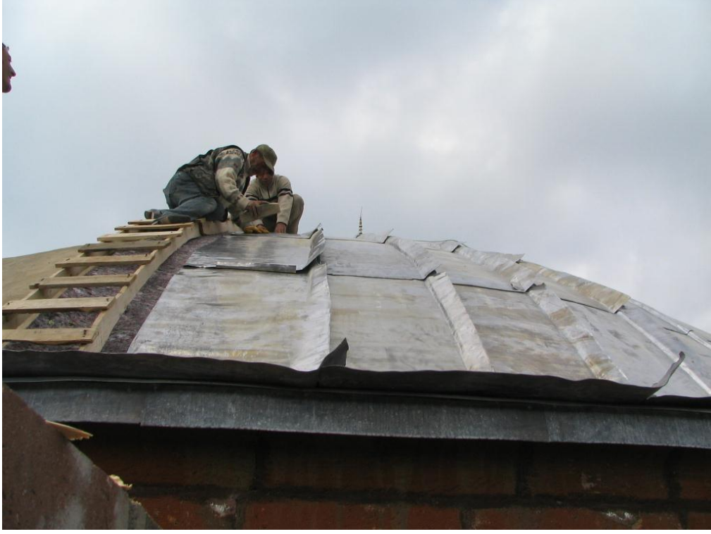
Fotoğraf 137: Kubbeye kurşun levhaların yerleştirilmesi (Ş. Öztürk)
