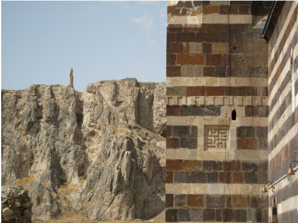
Fotoğraf 56: Minare duvarda ki kufi yazı
