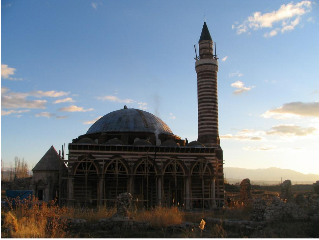
Fotoğraf 141: Kubbedeki payanların restorasyonu ve yüzeydeki çatlakların kireç harcı ile enjeksiyon işlemi (Ş. Öztürk)
