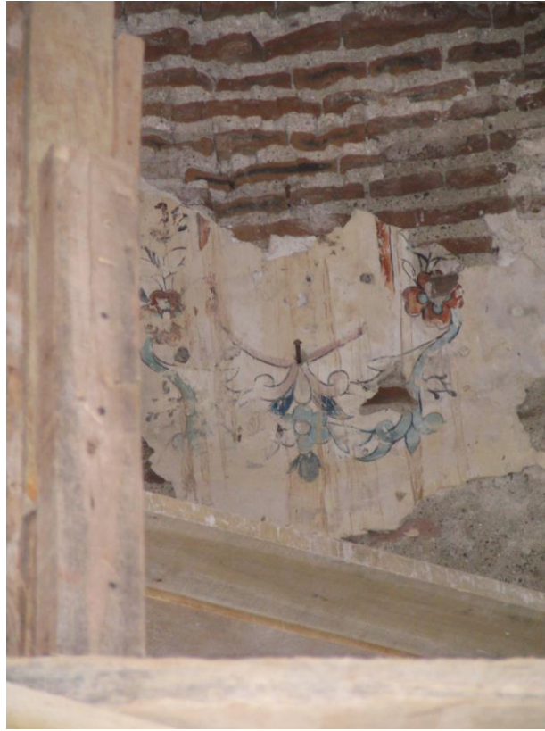
Fotoğraf 232: Kalem işi, sıva, tuğla ve harcın nemli görüntüsü (N. Mercan)
