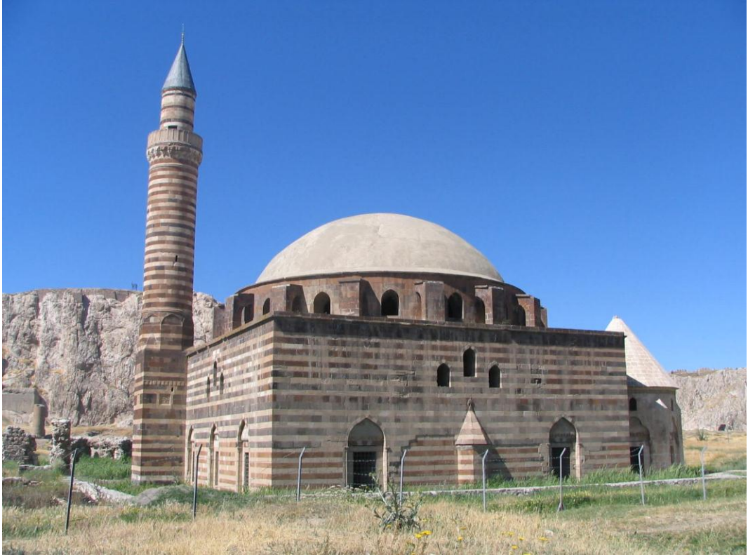
Fotoğraf 134: Cami kubbesinin şaplanmış hali (Ş. Öztürk)
