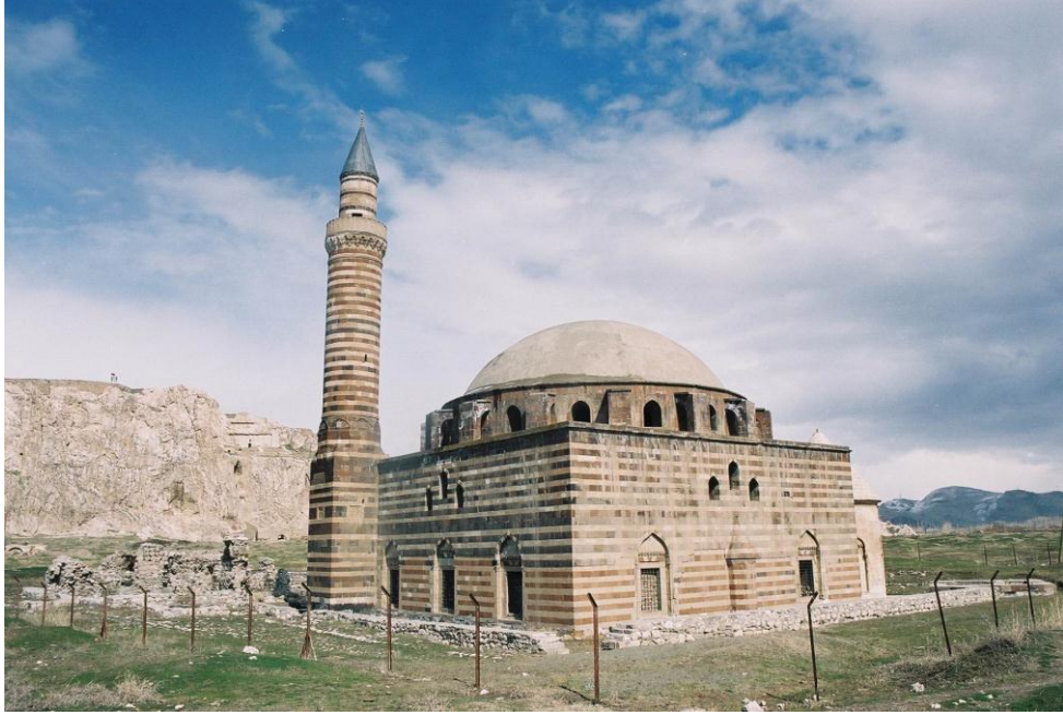
Fotoğraf 52: Güney ve batı cephesindeki pencereler
