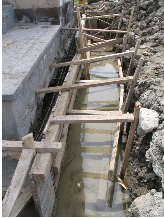
Fotoğraf 148: Açılan kanalda su tesviyesini sağlamak amacıyla eğimin oluşturulması (Ş. Öztürk)
