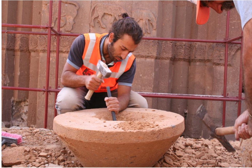
Fotoğraf 168: Taşın çekiç ve murç yardımıyla işlenmesi
