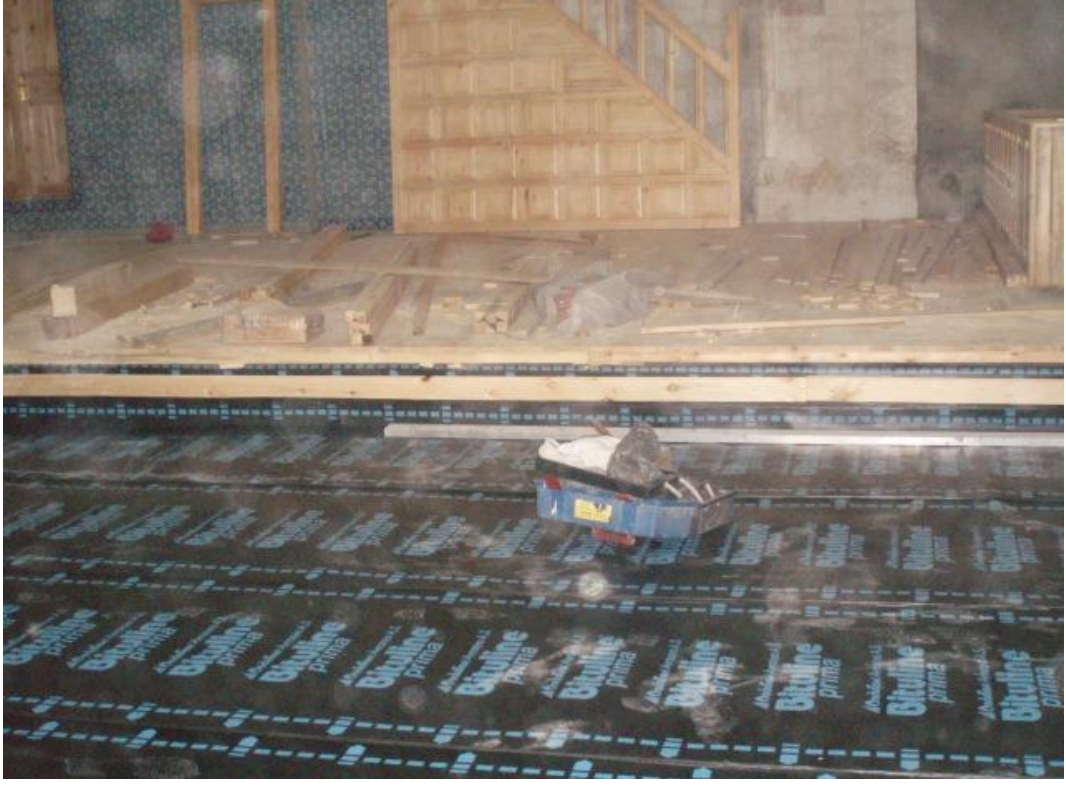
Fotoğraf 143: Yalıtım malzemesi üzerine ahşap döşemenin yapılması (Ş. Öztürk)
