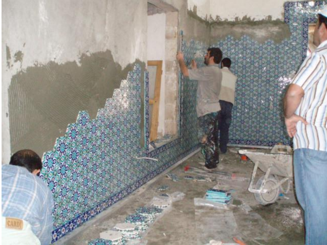
Fotoğraf 132: inilerin duvarlara yerleřtirilmesi (ř. ztürk)
