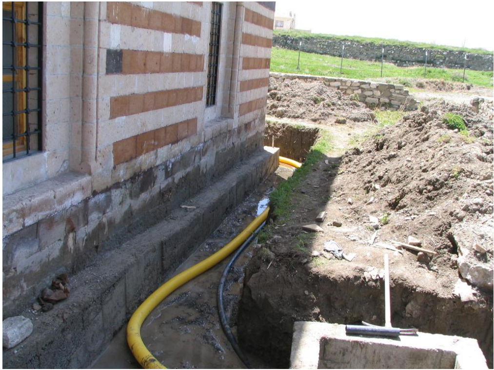
Fotoğraf 146: Cami etrafına açılan kanal (Ş. Öztürk)
