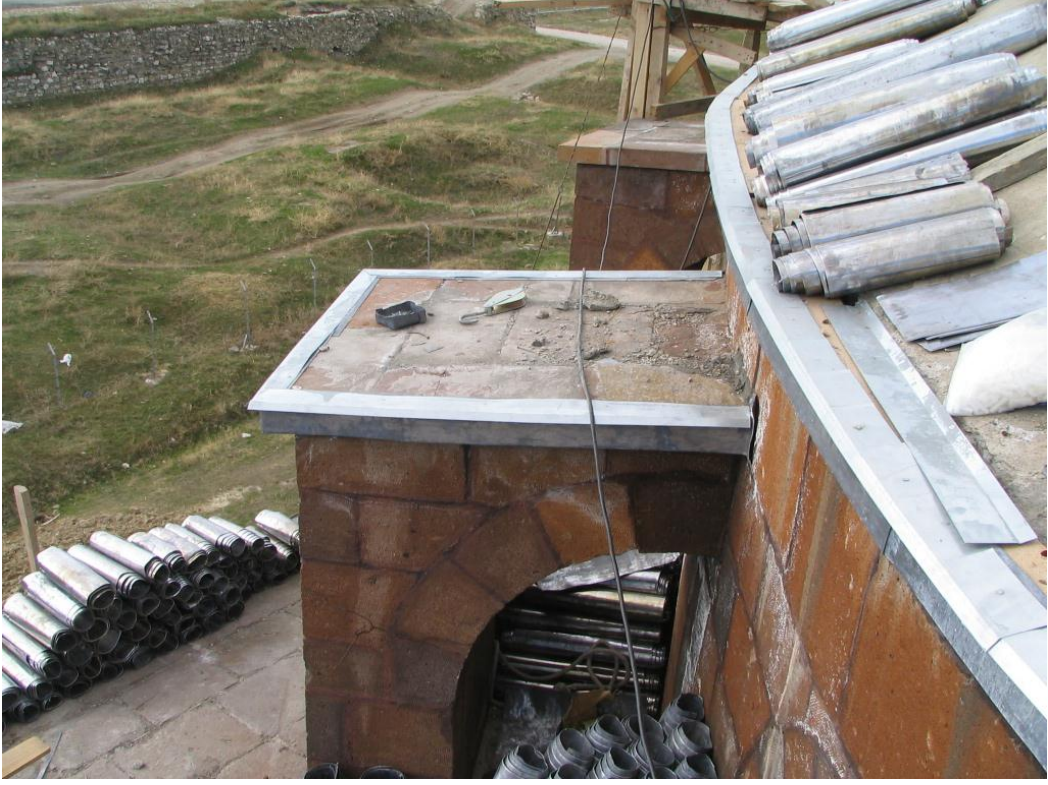
Fotoğraf 135: Kubbeye kurşun levhaların yerleştirilmesi (Ş. Öztürk)
