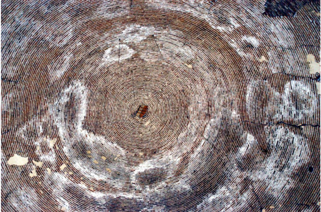
Fotoğraf 176: Kubbedeki tuzlanma (Ş. Öztürk)
