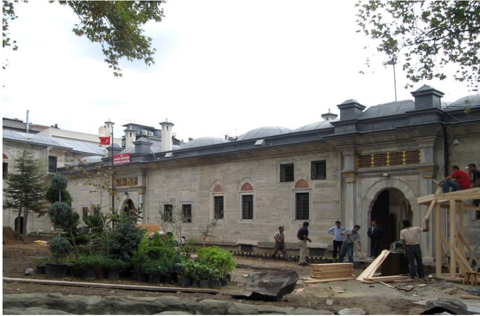
Fotoğraf 3.41. 2007’de medrese (solda) ve imaret (sağda) bahçesi olarak kullanılan alanda gerçekleştirilen bahçe düzenlemesi.
