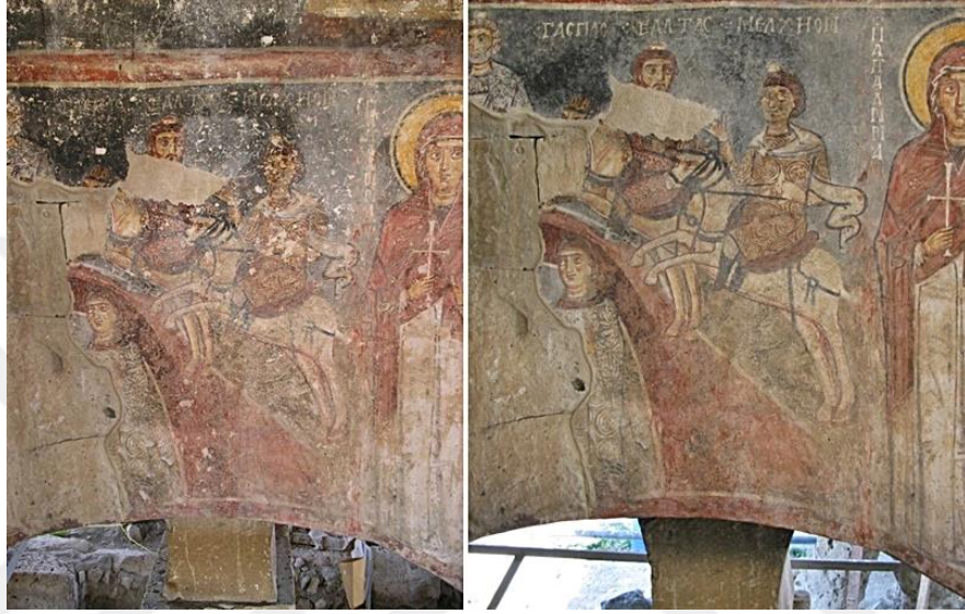
Şekil 5.36 2007-2011 Koruma-Onarım Çalışmaları Öncesi ve Sonrası
