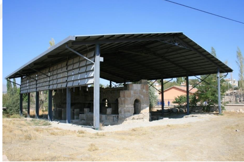
Şekil 5.31 Kilise Üzerine İnşa Edilen Koruma Çatısı
