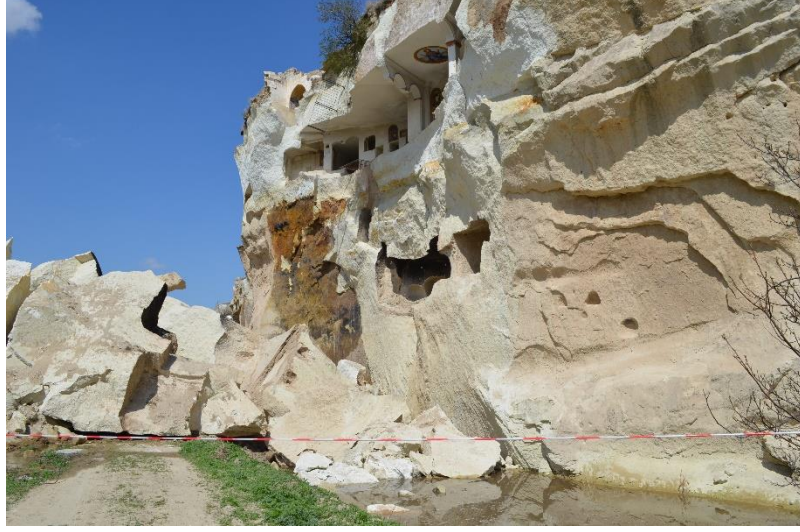
Şekil 2.4 2017 Nisan Ayında Doğal Nedenlerden Bir Kısım Yıkılan Ürgüp-Mustafapaşa Kasabası'ndaki Aziz Vasilios Kilise'si
