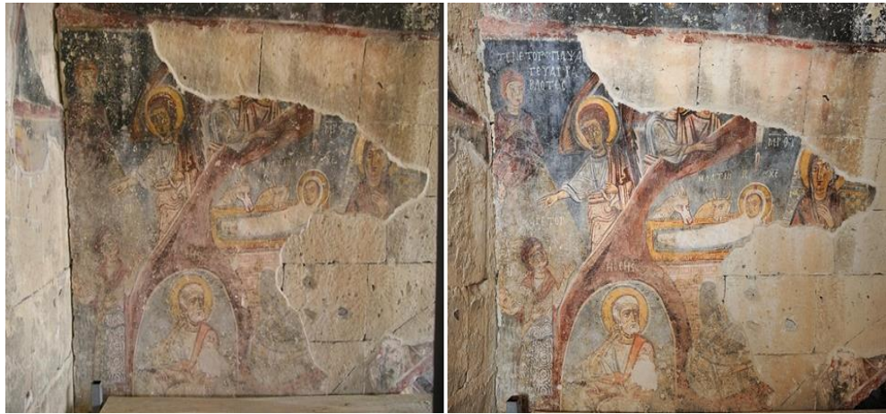
Şekil 5.35 2007-2011 Koruma-Onarım Çalışmaları Öncesi ve Sonrası
