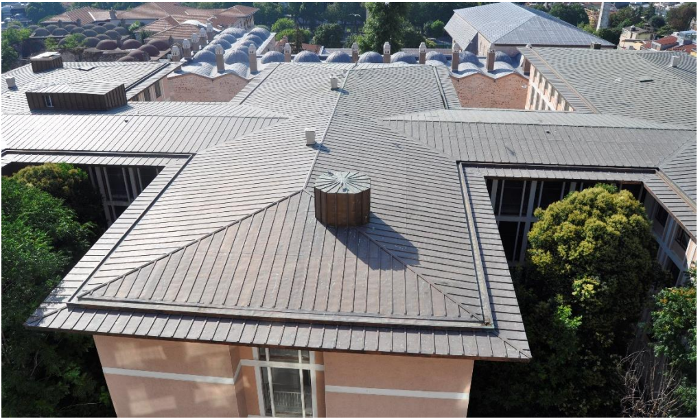
Resim 4-96 Yeniden yapılan Köstekli Bakır Çatı Kaplaması (İhale Dosyası, 2013)
