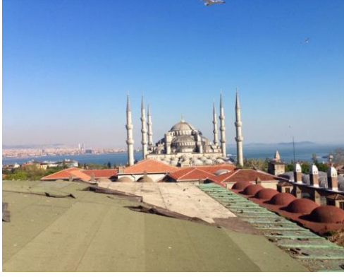
Resim 4-92 Söküm Öncesi Çatı ( Bakır Kaplamanın bir kısmı zamanla yok olduğundan benzer renkte yapılan kaplama)
