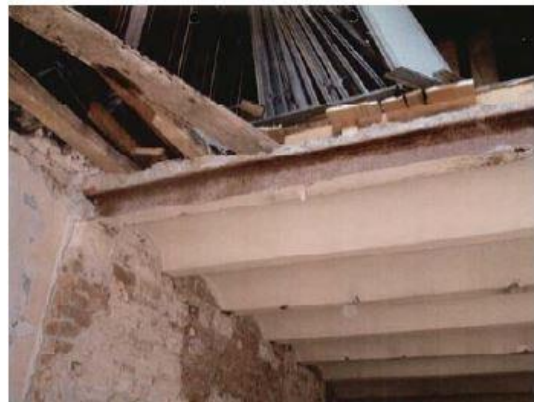
Resim 3-13 Mevcut Volta Döşeme (Researchgate, 2012)
