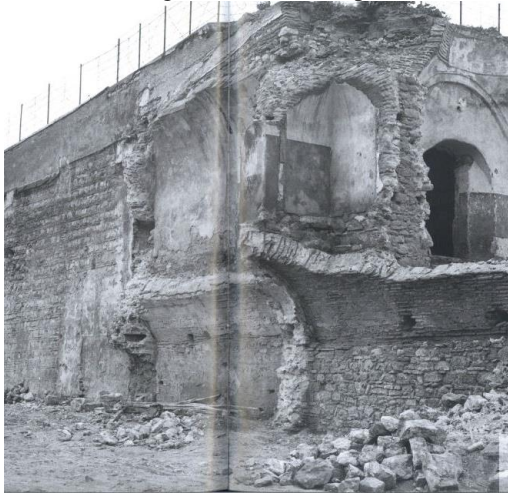
Resim 4-37 Yıkım Sonrası (Atasoy, 2012)
