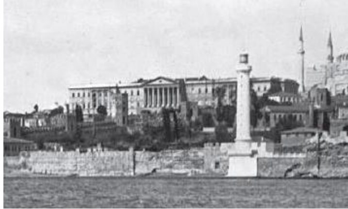
Resim 4-4 Yanan Darülfünun Binası (Sayıştay)
