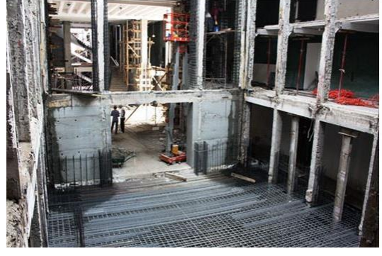
Resim 3-45 Yeni Eklenen Perdeler Ve Döşeme İmalatları (Sima İnşaat, 2012)
