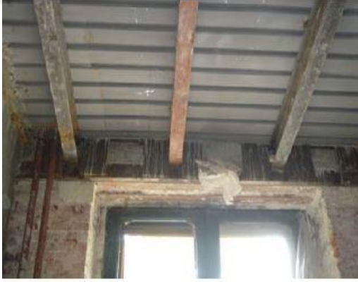
Resim 3-14 Mevcut Volta Kirişleri Üzerine Yapılan Betonarme Döşemeler (Researchgate, 2012)
