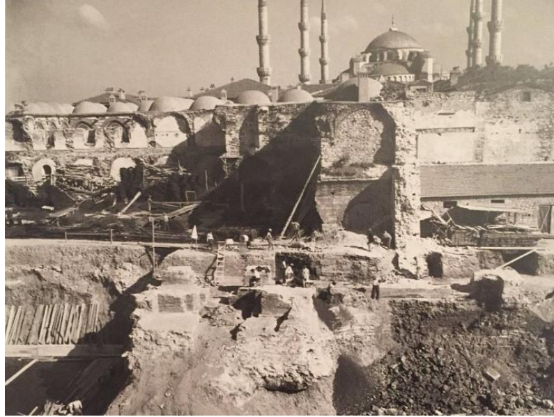
Resim 4-33 Damat İbrahim Paşa Sarayı Yıkım Sonrası (www.designarchitect.wordpress.com)
