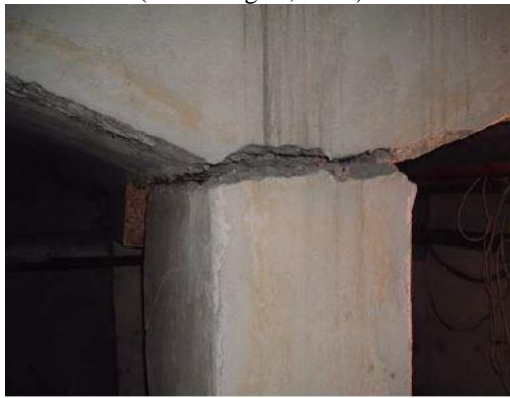
Resim 3-12 Hasar Görmüş B.A. Plaster (Researchgate, 2012)
