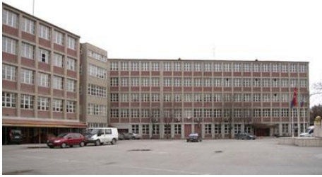
Resim 2-27 TED Ankara Koleji Restorasyon Öncesi (Güzer, 2013)
