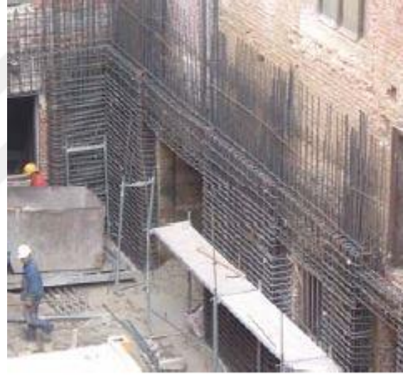
Resim 3-11 Avluda Yapılan Betonarme Duvarlar (Researchgate, 2012)
