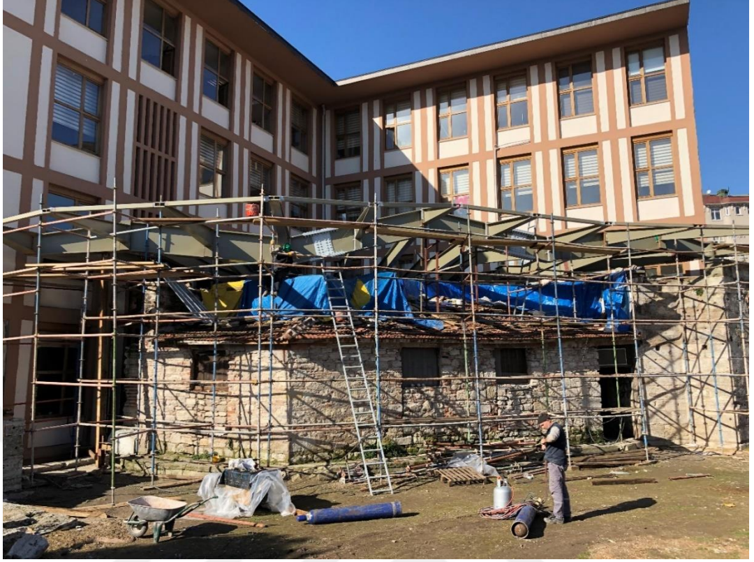
Resim 4-50 Azize Euphemia Kilisesi Çatı Örtü İnşaatı 2019 ( Aysen KAYA)
