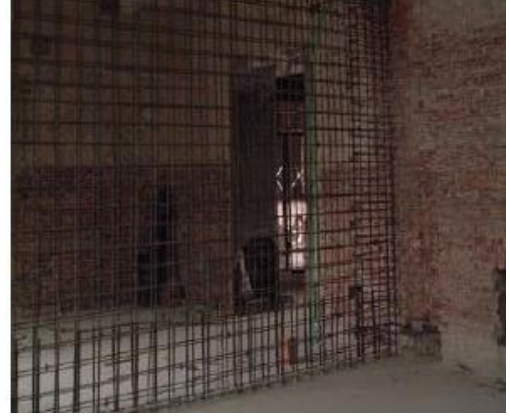
Resim 3-15 Tuğla Duvarlar Yerine Yapılan Betonarme Perdeler (Researchgate, 2012)
