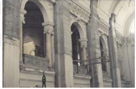
Resim 3-9 1977 Sonrası Plaster Güçlendirmesi (Researchgate, 2012)
