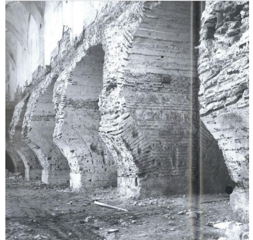
Resim 4-38 Yıkım Sonrası (Atasoy, 2012)
