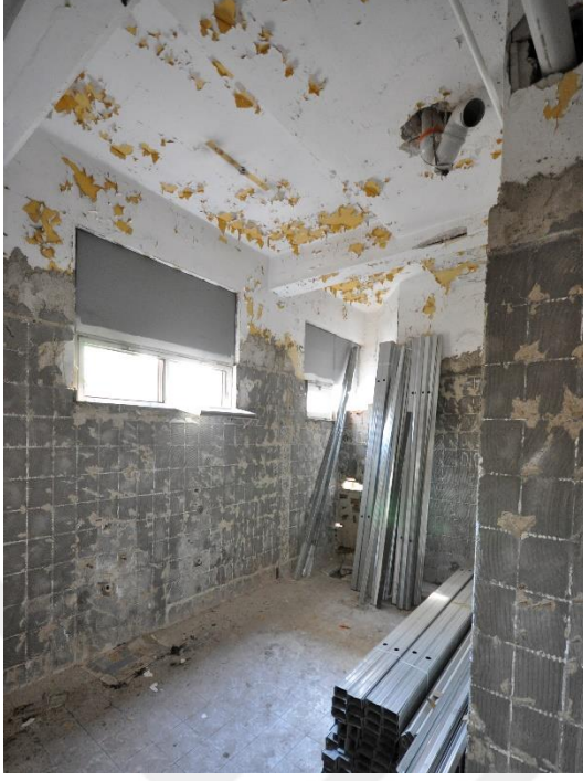
Resim 4-81 Islak Hacimlerde Seramik Sökümü sonrası (İhale Dosyası, 2013)
