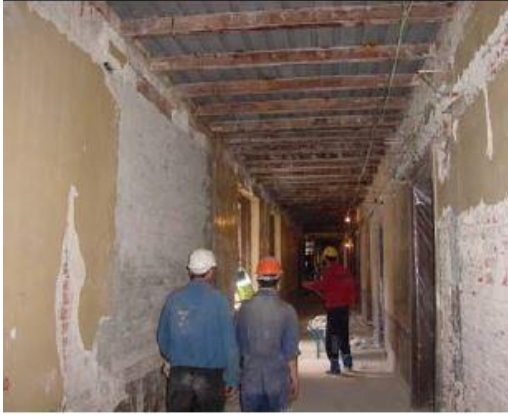
Resim 3-14 Mevcut Volta Kirişleri Üzerine Yapılan Betonarme Döşemeler (Researchgate, 2012)
