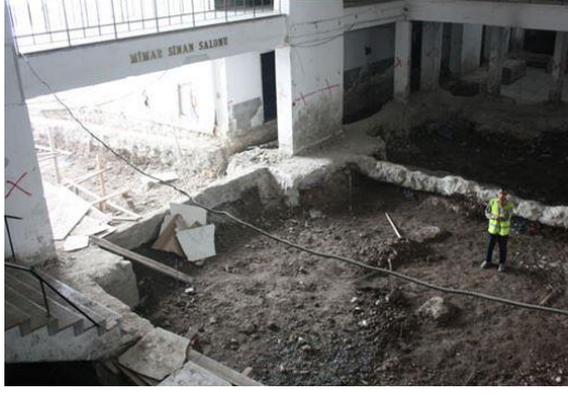
Resim 3-44 Güçlendirme öncesi hafriyat çalışmaları (Sima İnşaat, 2012)
