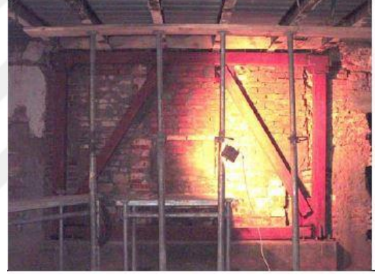
Resim 3-17 Tuğla Duvarlarda Çelik Çerçeve İmalatı (Researchgate, 2012)
