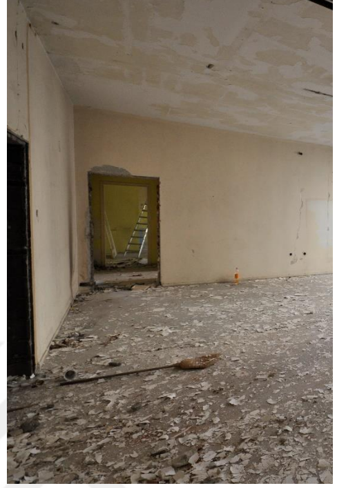
Resim 4-82 Odalarda Kaba Badana Raspası ve Kapı Sökümleri Sonrası (İhale Dosyası, 2013)
