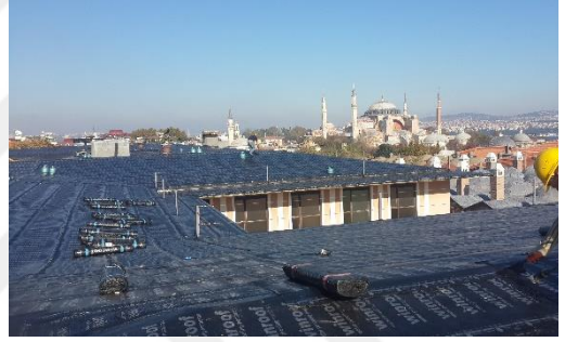
Resim 4-95 Bakır Çatı Altına Su Yalıtımı (İhale Dosyası, 2013)
