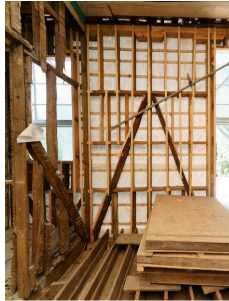
Şekil 5.72 : HÇY 1. Kat B06 Değişen Taşıyıcı Sistem Elemanları (Öztürk, 2019)
