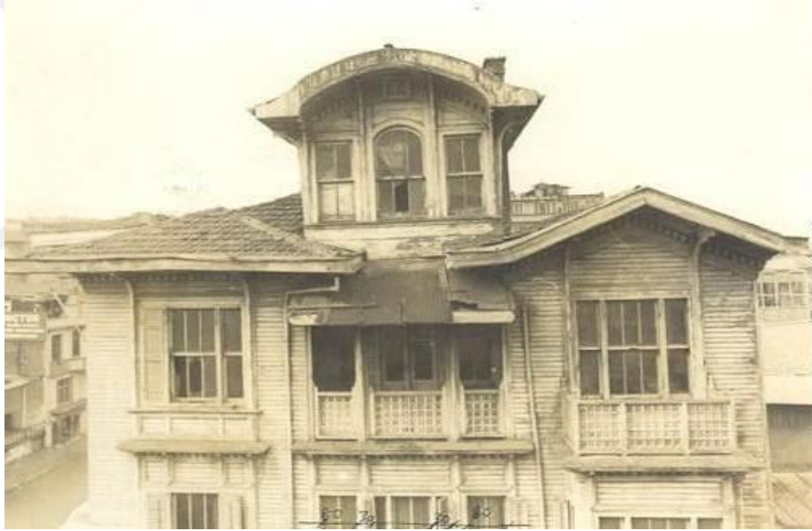
Şekil 5.45: TAMEK Güneydoğu Cephesi Cihannüma Görünüşü (KVKBK Arşivi)
