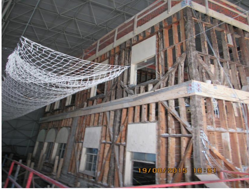
Şekil 5.31: HSY Güney Cephe 2015 Yılı Söküm Çalışmaları (Kahraman, 2015)
