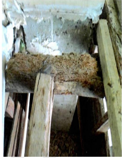
Şekil 5.23 : HSY Taşıyıcı Sistemdeki Mantarlaşmalar ve Böceklenmeler 5
