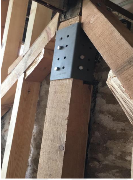
Şekil 5.73: HÇY Ahşap Karkas Bağlantı Detayı (Öztürk, 2019)
