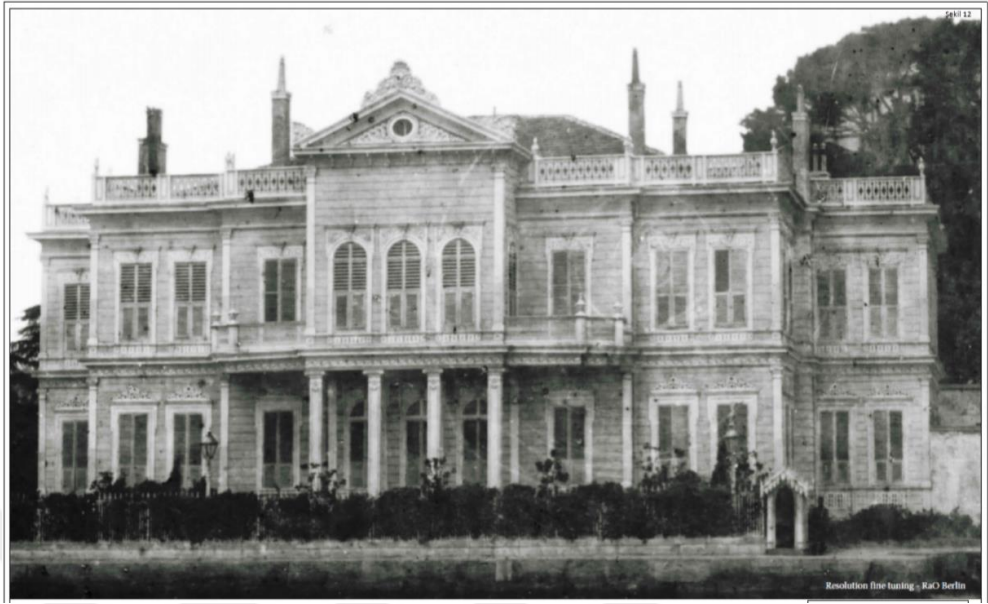
Şekil 5.5: HSY Güneydoğu Cephesi Fotoğrafı (KVKBK Arşivi)
