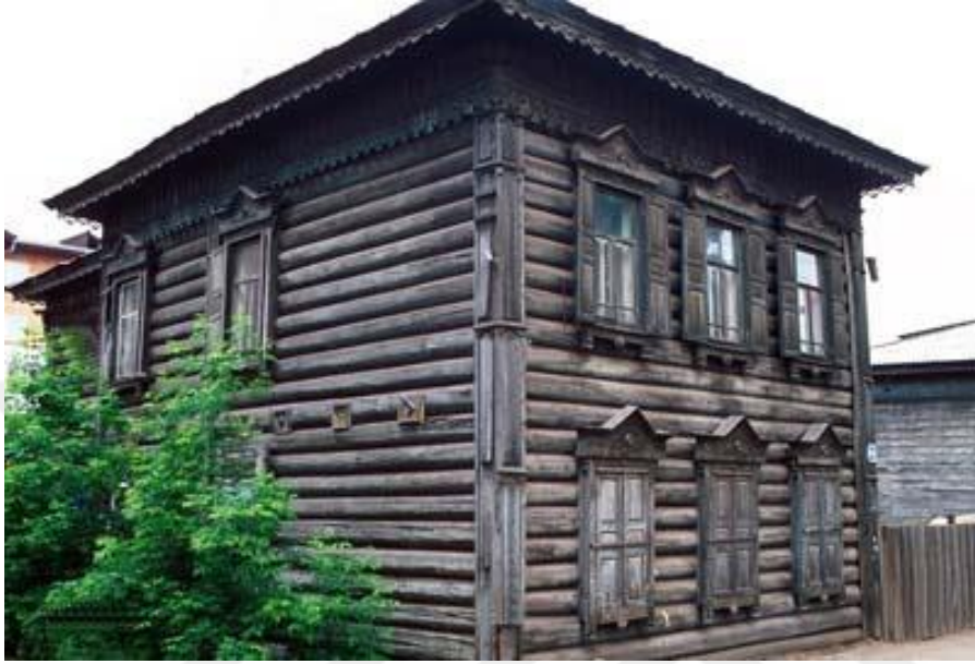
Şekil 3.1: Ahşap Yığma Yapı Örneği (URL 14, 14/04/2020)
