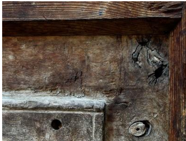
Şekil 2.8 : Ahşap Yapı Elemanında Budak Örneği (Uzun, 2013)
