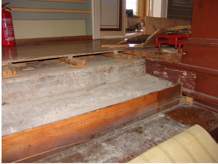
Şekil 5.17: HYS Betonarmeye Çevrilen Ana Merdiven (Kahraman, 2009)
