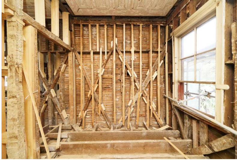
Şekil 3.9: HÇY 1.NK Çapraz (Payanda) Eleman Örnekleri (Kahraman, 2018)
