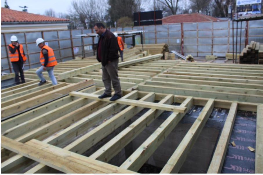
Şekil 3.6: TAMEK Rekonstrüksiyon Uyg. Döşeme Kirişleri (Kahraman, 2017)
