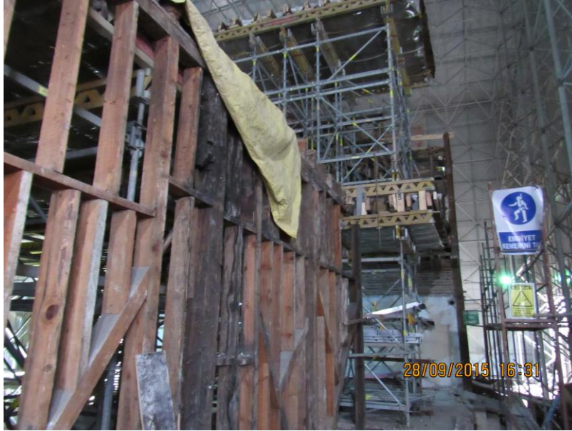
Şekil 5.32: HSY Doğu Cephe 2015 Yılı Söküm Çalışmaları (Kahraman, 2015)
