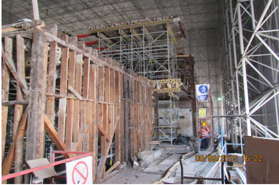
Şekil 3.4: HSY Doğu Cephesi Dikme Örnekleri (Kahraman, 2015)
