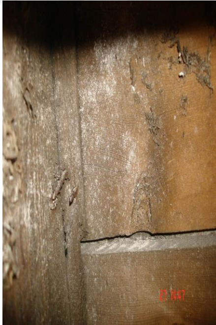
Şekil 5.20: HSY Taşıyıcı Sistemdeki Mantarlaşmalar (Kahraman, 2009)
