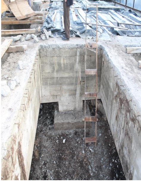
Şekil 5.48 : TAMEK Mevcut Temel Görünüşü (Kahraman, 2017)
