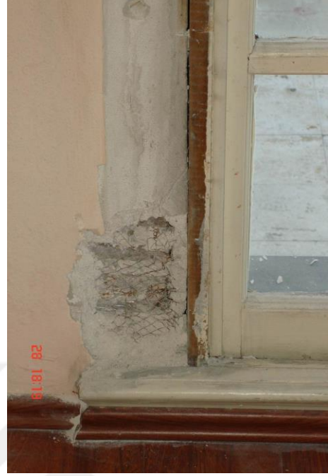
Şekil 5.19: HSY Muhdes Sıva Örneği (Kahraman, 2009)
