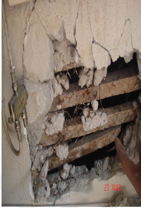
Şekil 5.18: HSY Muhdes Sıva Örneği (Kahraman, 2009)
