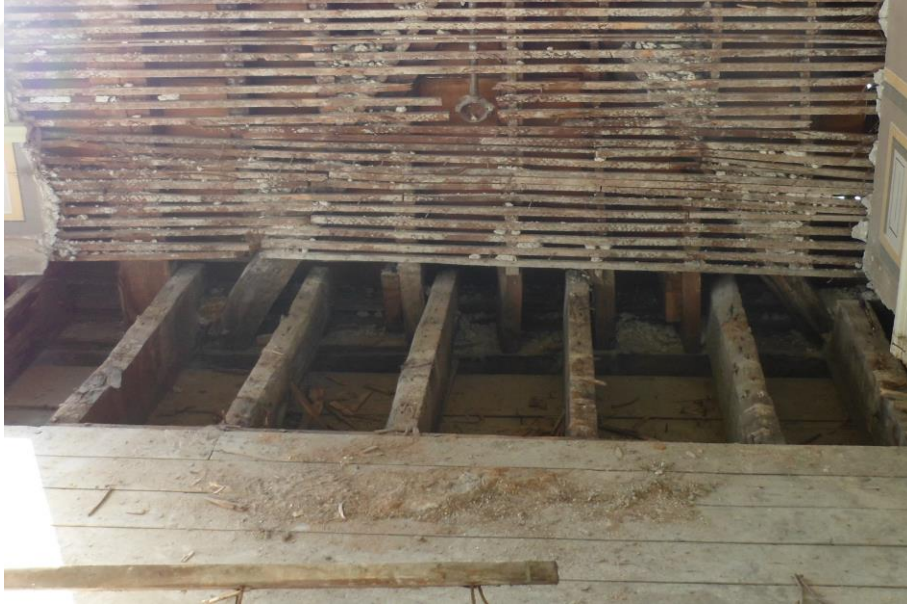
Şekil 3.7: HSY Yastık ve Döşeme Kirişleri (Kahraman, 2015)
