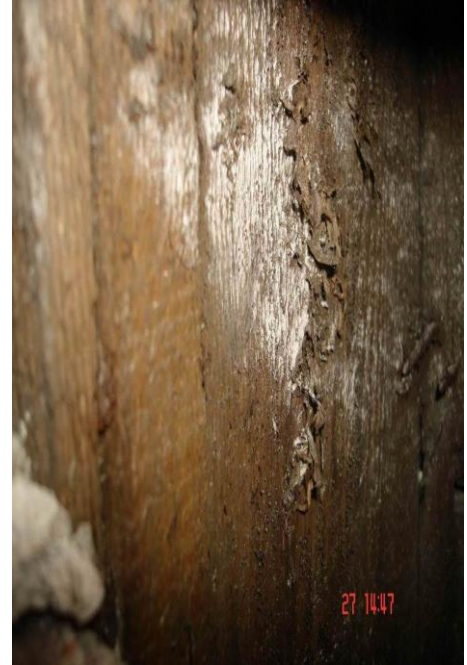
Şekil 5.21 : HSY Taşıyıcı Sistemdeki Mantarlaşmalar (Kahraman, 2009)
