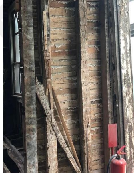
Şekil 3.16 : HÇY Yarma Bağdadi Çıta Örneği (Kahraman, 2019)
