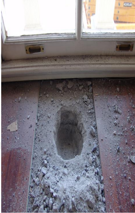
Şekil 5.15 : HSY Zemin Kat Döşeme Kaplamaları (Kahraman, 2009)
