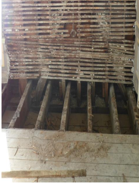
Şekil 3.15 : HSY Bağdadi Çıta Örneği (Kahraman, 2015)
