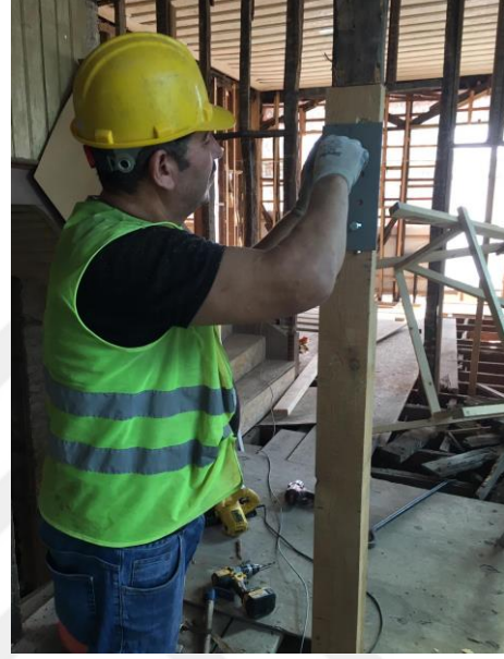
Şekil 5.74 : HÇY Ahşap Karkas Bağlantı Detayı (Öztürk, 2019)
