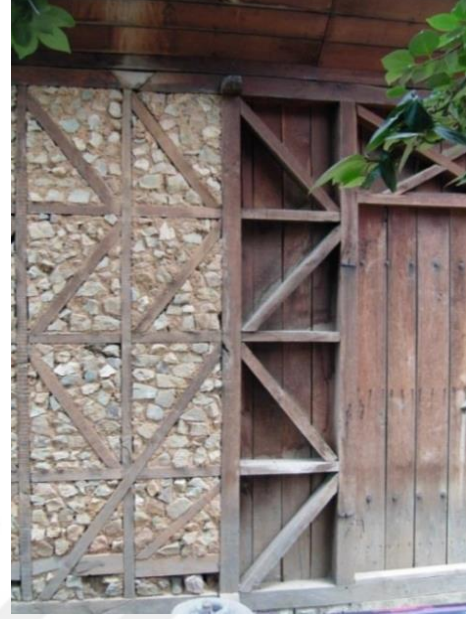
Şekil 3.18 : Muska Dolma Duvar Örneği (Arun, 2012)
