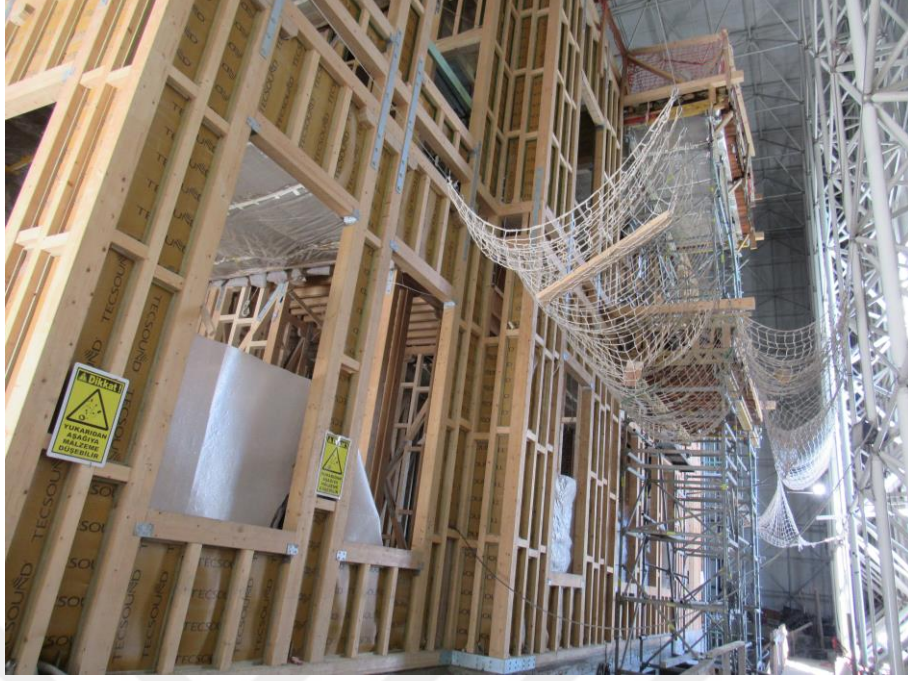
Şekil 5.35: HSY 2017 yılı Yapım çalışmaları (Kahraman, 2018)
