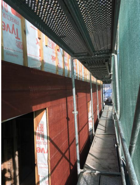
Şekil 5.75 :HÇY Yenilenen Cephe Kaplaması (Öztürk, 2020)
