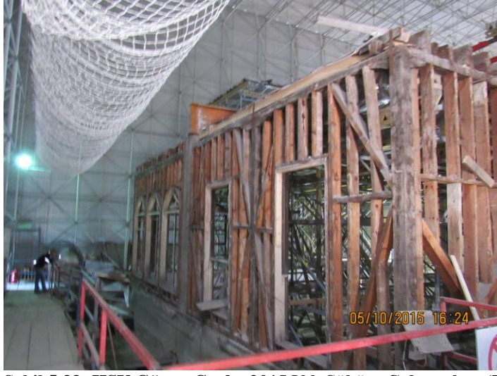
Şekil 5.33: HSY Güney Cephe 2015 Yılı Söküm Çalışmaları (Kahraman, 2015)
