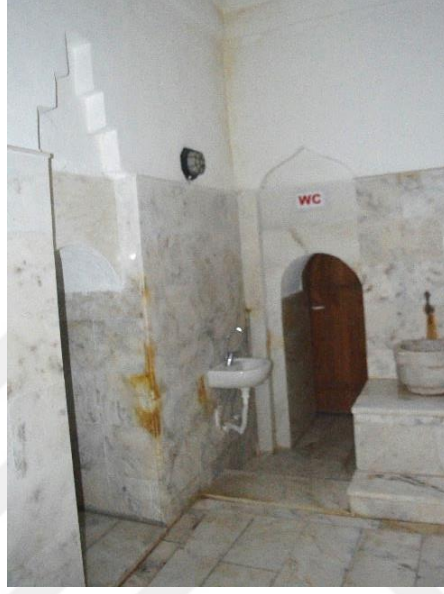
Şekil 3.35 Gedik Ahmed Paşa Hamamı, kadınlar hamamı ılık bölümü (Çatalbaş, 2018)
