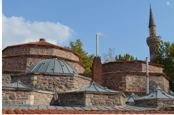
Şekil 4.14 Gedik Ahmed Paşa Hamamı, yenilenen sıcaklık ve ılıklik üst örtüsü (Çatalbaş, 2018)
