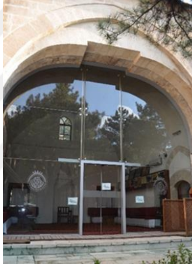
Şekil 4.9 Gedik Ahmed Paşa Medresesi 2010 senesindeki restorasyon sonra eyvandan görünüm (Çatalbaş, 2018)
