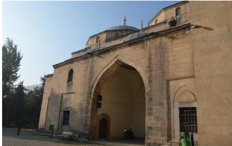
Şekil 3.10 Gedik Ahmed Paşa Cami doğu yönündeki tabhane mekanları ve eyvan (Çatalbaş, 2018)
