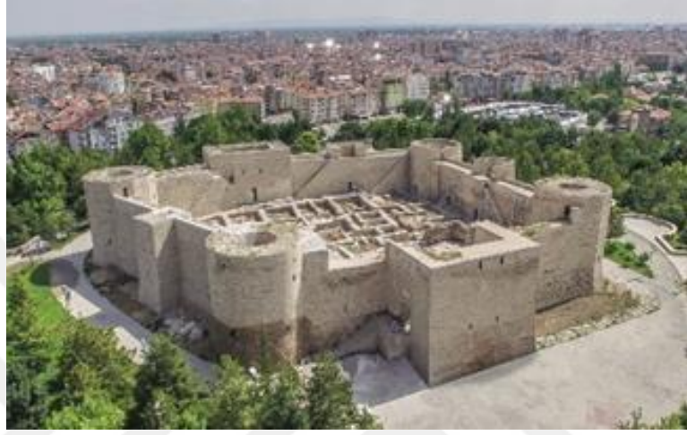
Şekil 3.60 Karaman Kalesi'nin kazı çalışmaları tamamlandıktan sonra günümüzdeki durumu. http://www.selcuklumirasi.com/architecture-detail/karaman-kalesi
