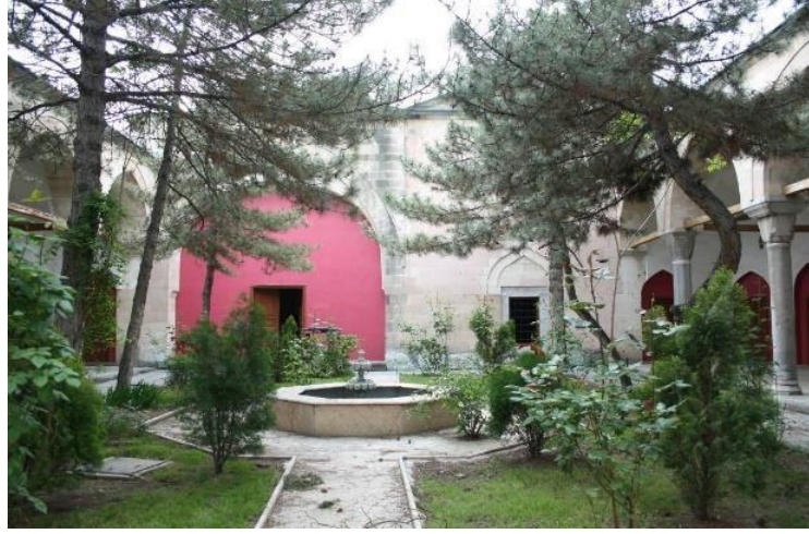
Şekil 4.8 Gedik Ahmed Paşa Medresesi, 2010 senesindeki restorasyondan önce medrese avlusu (Kütahya VGM Raporu, 2008)
