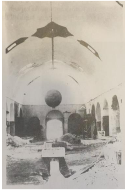
Şekil 4.32 Kütahya Büyük Bedesteninin 1930'lardaki onarımdan bir fotoğraf, Çemberciler Sokağı yönü (Kalyon, 2000)
