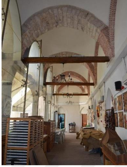
Şekil 3.16 Gedik Ahmed Paşa Medresesi, revaklar (Çatalbaş, 2018)
