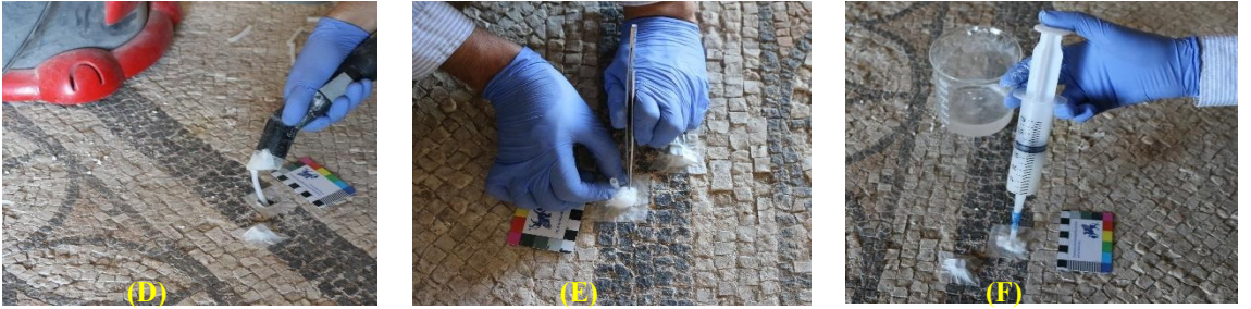
Şekil 6. 26 A.E. 36, Çıkarılan tessera'nın yarattığı yerden delik açılıp ve deliğin içi elektrikli süpürgeyle temizlenmiştir(D). Sıvı halde enjeksiyonun gönderilmesi için hortum yerleştirilmiş, harcı geri tepmemesi için etrafı pamukla sıkılaştırılmıştır(E). Boşlukları açması için 1:1 Oranda Alkol-su çözeltisi hortumdan enjektör ile gönderilmiştir(F). (2020) (P.K.A)
