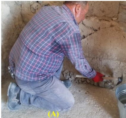
Şekil 6. 30 A.E. 36, Spiral motorlar kesilen betonların parçalanarak alınması(A), Kenar lakuna harcı üzerine estetik harç uygulaması(B), Estetik harç uygulaması sonrası görünüş(C), (2017) (P.K.A)
