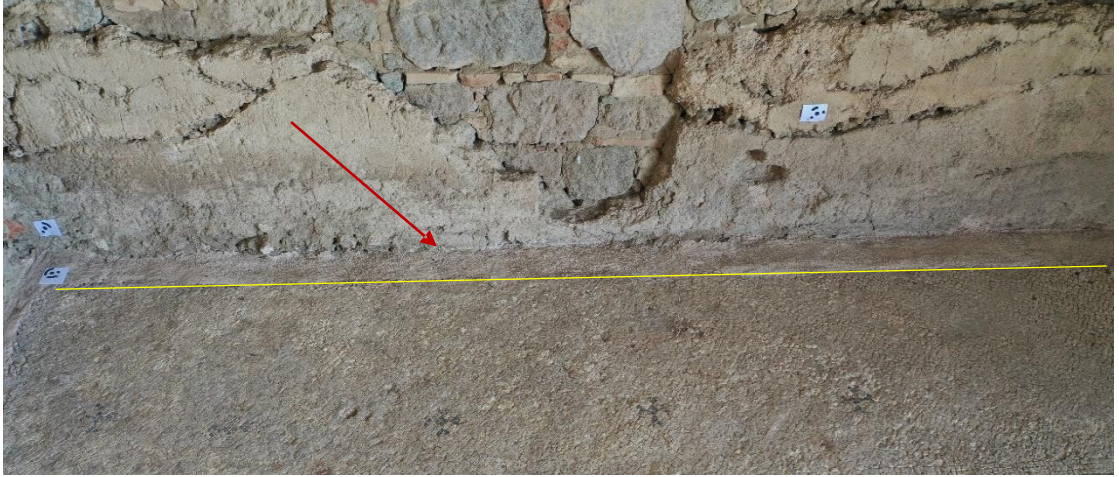
Şekil 6. 31 A.E. 36, Kireç Esaslı estetik harç yapımı ile kenar sağlamlaştırma/bordür uygulaması (2020) (P.K.A)
