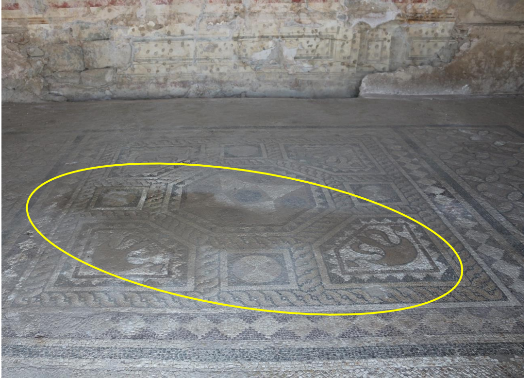
Şekil 5. 8 A.E. 36, Mozaik zemininden kaynaklı olarak yüzeye ulaşan tuz kristalizasyonu (2020) (P.K.A.)
