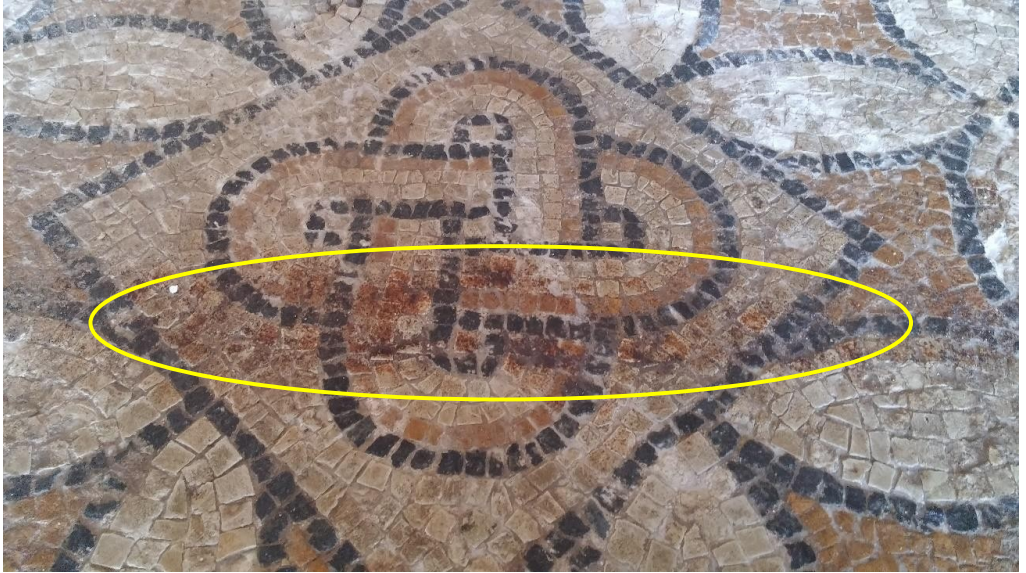
řekil 5. 11 A.E. 36, Metal atı Sisteminde Oluřan Oksidasyonun atıdan Sızan Yaęmur Damlasıyla Birleřerek Eser Yzeyine Dřtę Yerde Pas Lekesi Oluřturması (2017) (P.K.A)
