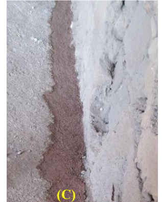
Şekil 6. 30 A.E. 36, Spiral motorlar kesilen betonların parçalanarak alınması(A), Kenar lakuna harcı üzerine estetik harç uygulaması(B), Estetik harç uygulaması sonrası görünüş(C), (2017) (P.K.A)
