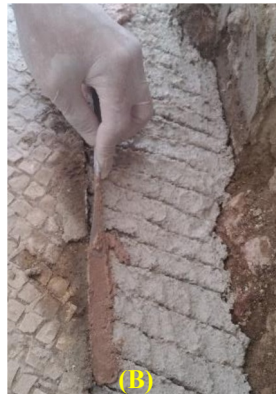
Şekil 6. 30 A.E. 36, Spiral motorlar kesilen betonların parçalanarak alınması(A), Kenar lakuna harcı üzerine estetik harç uygulaması(B), Estetik harç uygulaması sonrası görünüş(C), (2017) (P.K.A)
