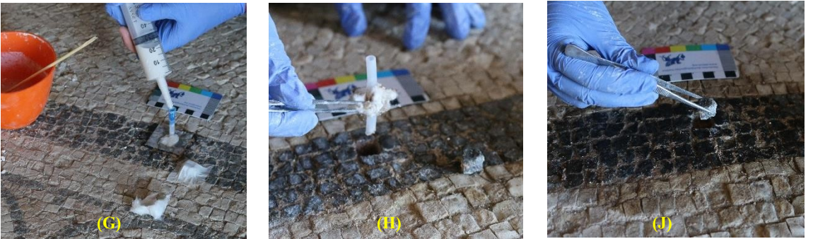
Şekil 6. 27 A.E. 36, Farklı yoğunlukta hazırlanan PLM harcı enjektörle gönderilmiştir(G). Sağlamlaştırma işlemi bittikten sonra hortum çıkartılmıştır(H). (2020) (P.K.A)
