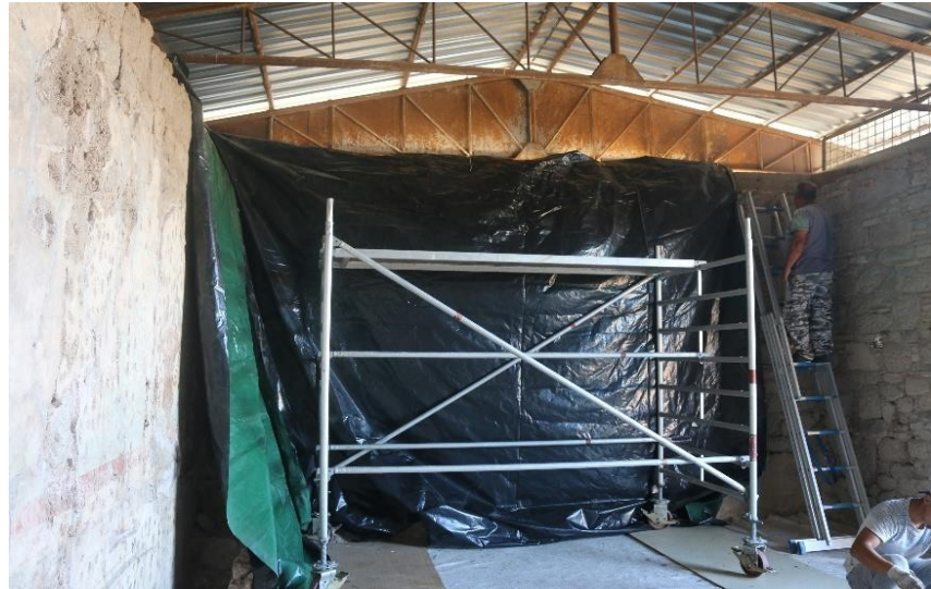
Şekil 4. 9 A.E. 36, Korozyona Uğrayan Demir Malzemenin Boyanması (2020) (P.K.A)
