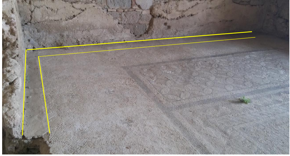
Şekil 6. 29 A.E. 36, Çimento kullanımı ile yapılan eski onarım kenar/bordür uygulaması (2017) (P.K.A)
