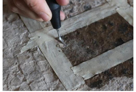
Şekil 6. 6 A.E. 36, Piezon Çalıřması Esnası (2019) (P.K.A)
