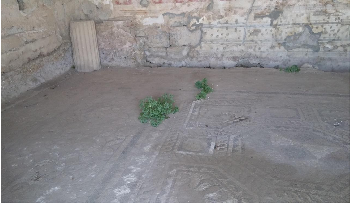
Şekil 5. 7 A.E. 36, Bitki kökleri gelişirken yarattığı boşlukların kumla/toprakla dolması sonucunda meydana gelen şişme ve buna bağlı olarak tessellatumun dağılması 2017 (P.K.A.)
