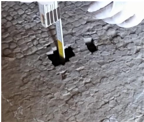
Şekil 5. 3 A.E. 36 Taban Mozağı, Rudus Seviyesine Kadar Derinleşmiş Lakuna Örneği. 2017 (P.K.A.)
