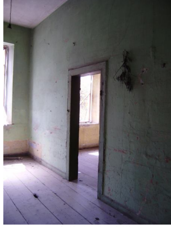
Fotoğraf 63 "A.1K.01" Batı Duvarı
