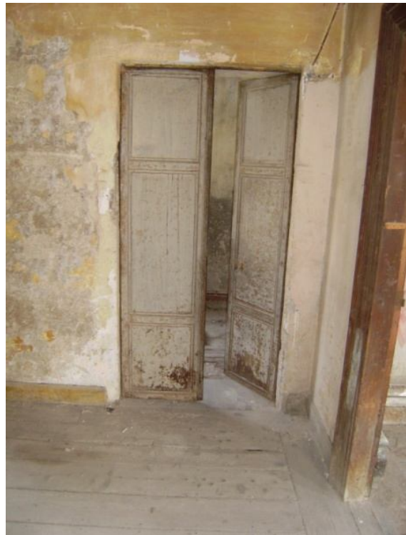
Fotoğraf 66 "A.1K.04" Demir Kapı
