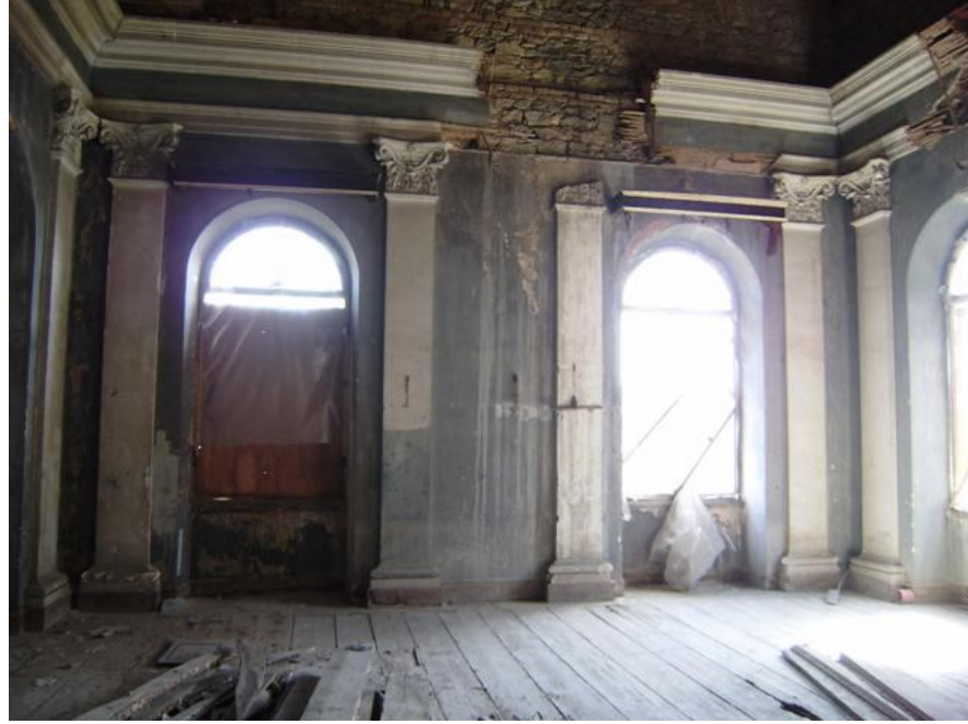
Fotoğraf 194 “A.1K.05” No.lu mekân doğu duvarı
