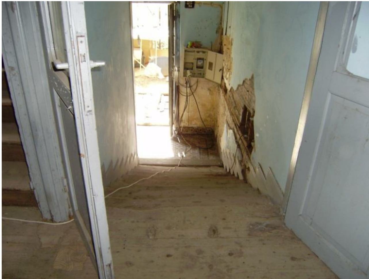
Fotoğraf 99 "M1" Merdiveni +000 Kotu
