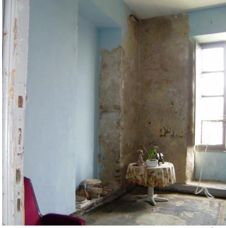
Fotoğraf 192 Giriş katında “A.GK.08” No.lu mekândaki niş
