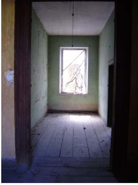
Fotoğraf 62 "A.1K.01" Güney Duvarı
