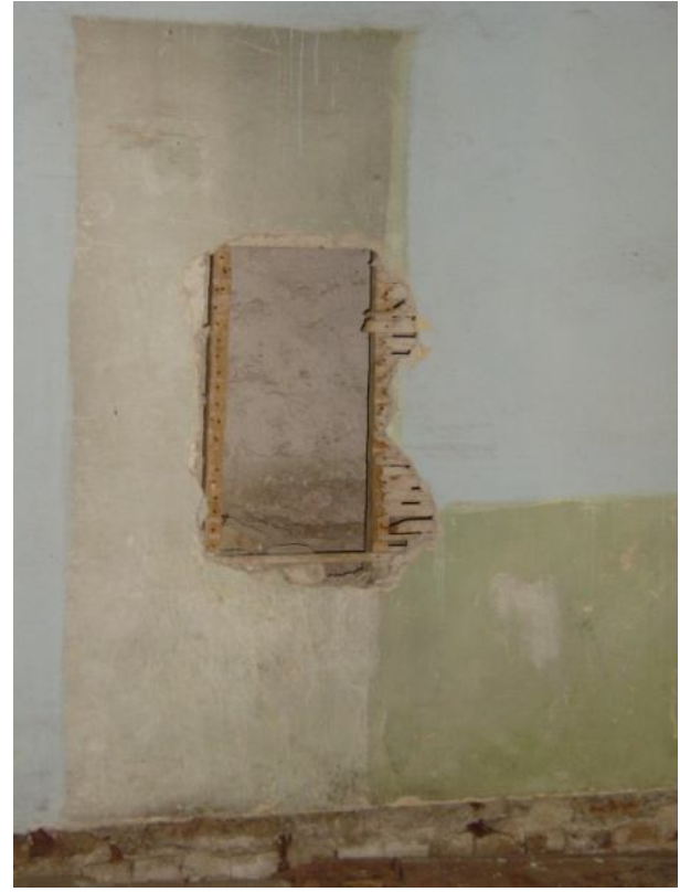
Fotoğraf 40 “A.BK.06” Kuzey Duvarındaki Kapatılmış Penceler
