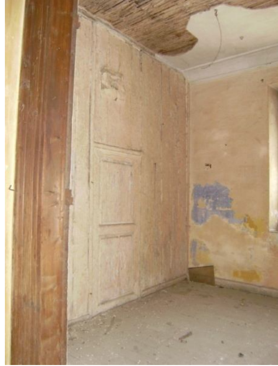
Fotoğraf 65 "A.1K.03" Güney Duvarı
