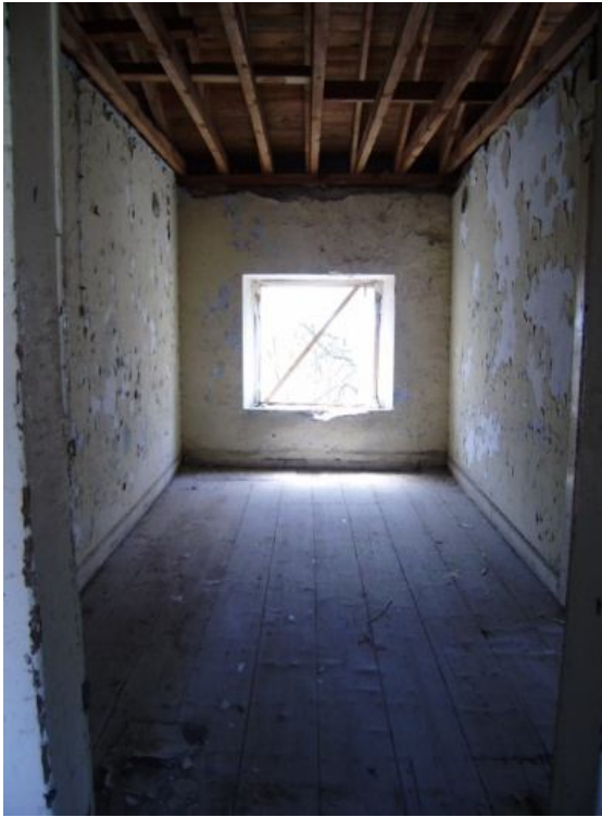
Fotoğraf 81 “A.2K.01” Güney Duvarı
