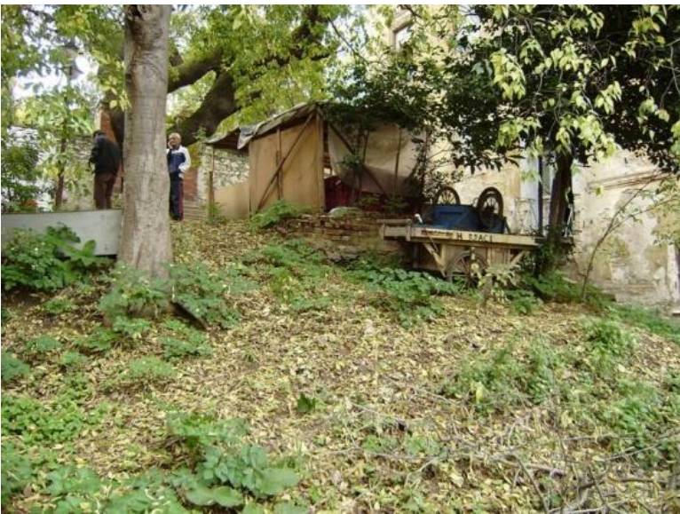
Fotoğraf 6 - İstinat duvarları
