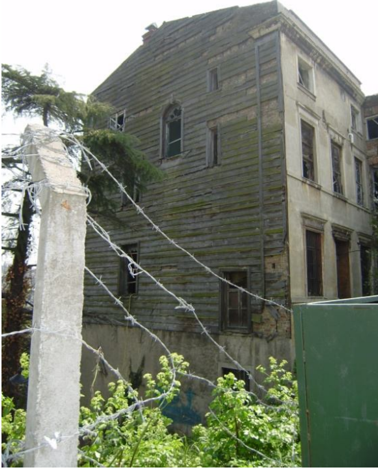
Fotoğraf 160- B Yapısı Kuzey cephesi
