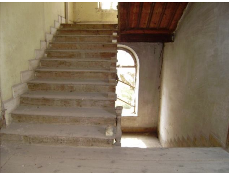
Fotoğraf 100 "M1" Merdiveni +410 kotu
