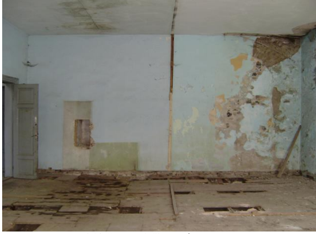
Fotoğraf 18 “B.BK.06” Mekanı kuzey duvarı
