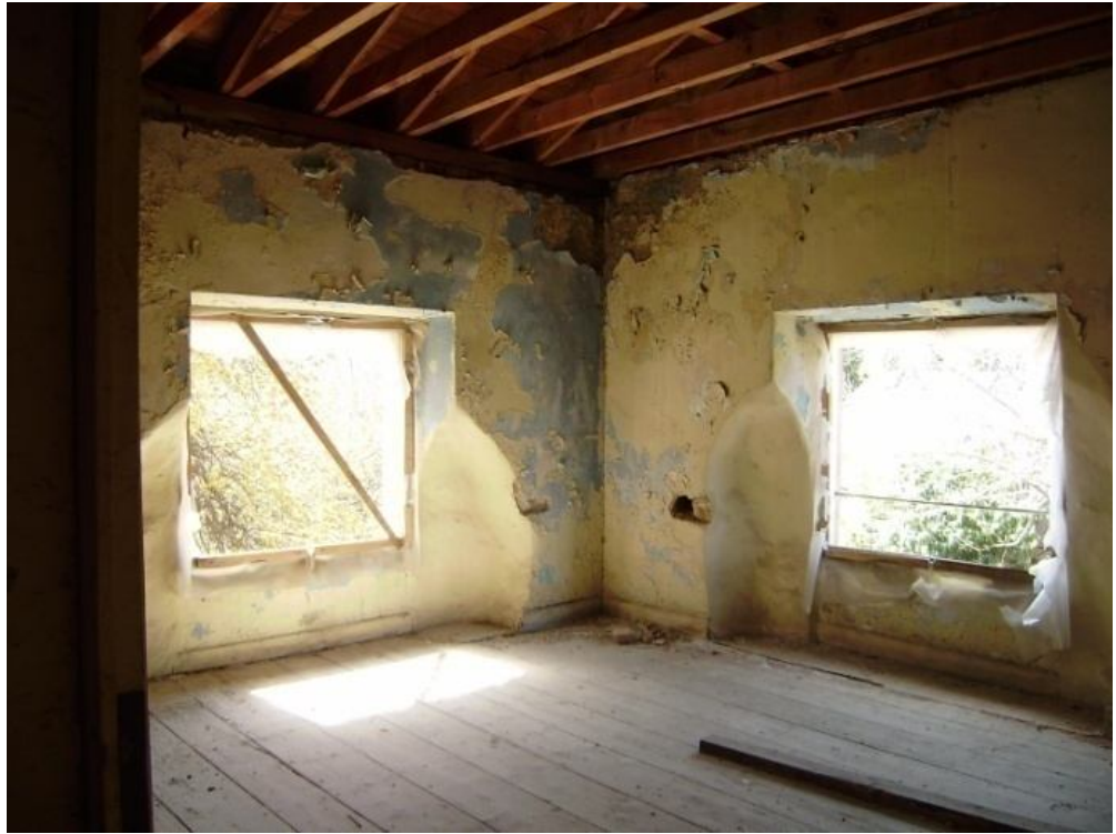
Fotoğraf 82 “A.2K.02” Güney ve Batı Duvarı
