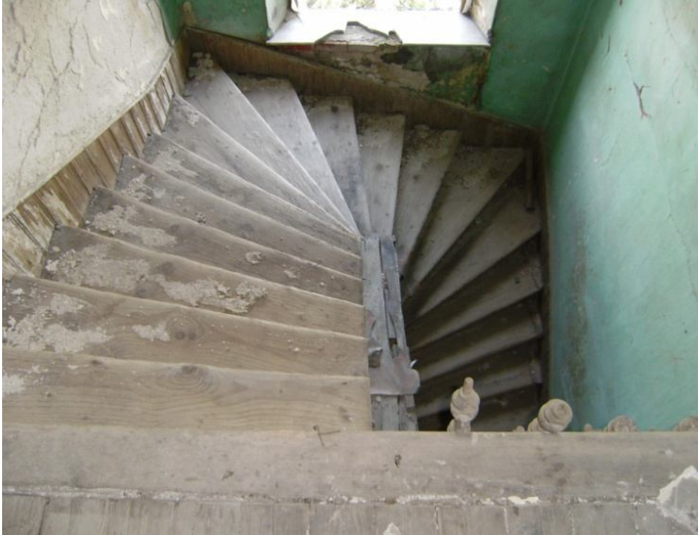
Fotoğraf 110 “M3” Merdiveni + 820’den aşağıya bakış
