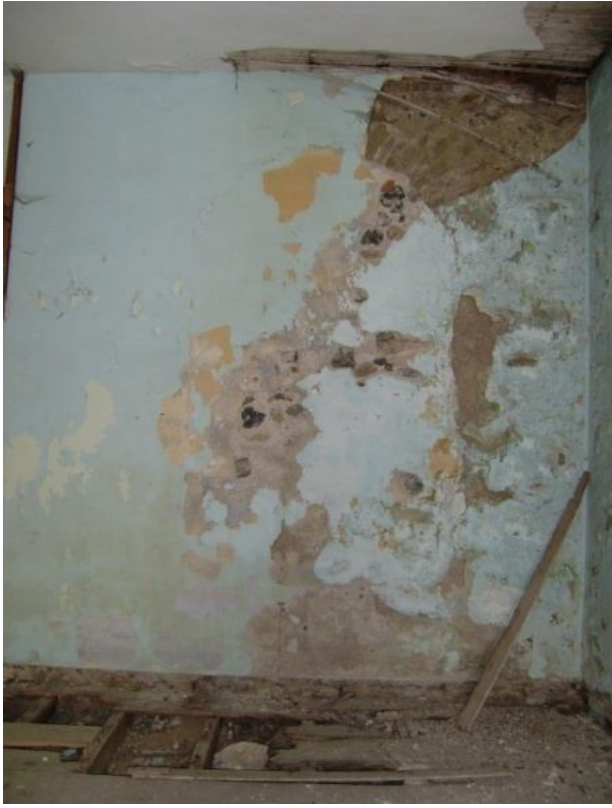
Fotoğraf 40 “A.BK.06” Kuzey Duvarındaki Kapatılmış Penceler
