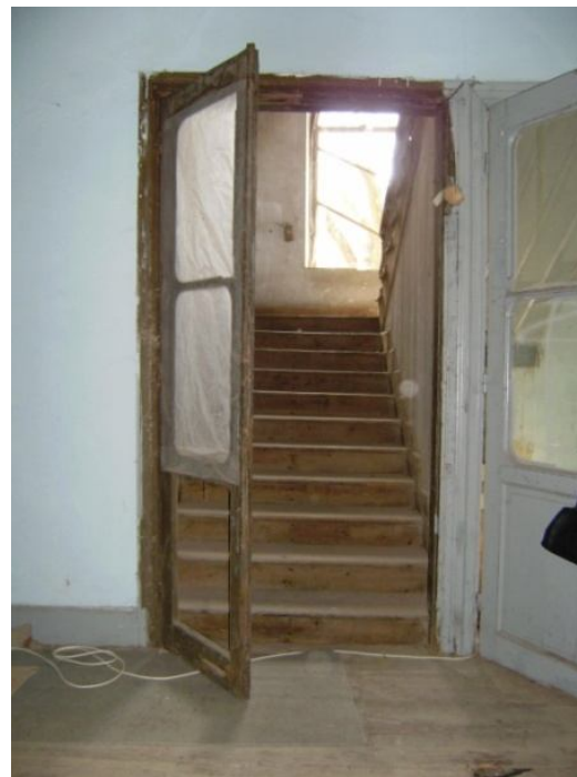
Fotoğraf 45 "M1" Merdiveni ±0,00 kotundan (A.GK.07) +2,05 kotuna bakış
