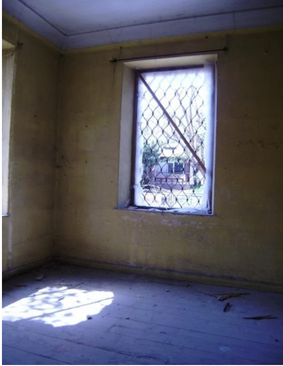
Fotoğraf 64 "A.1K.02" Batı Duvarı
