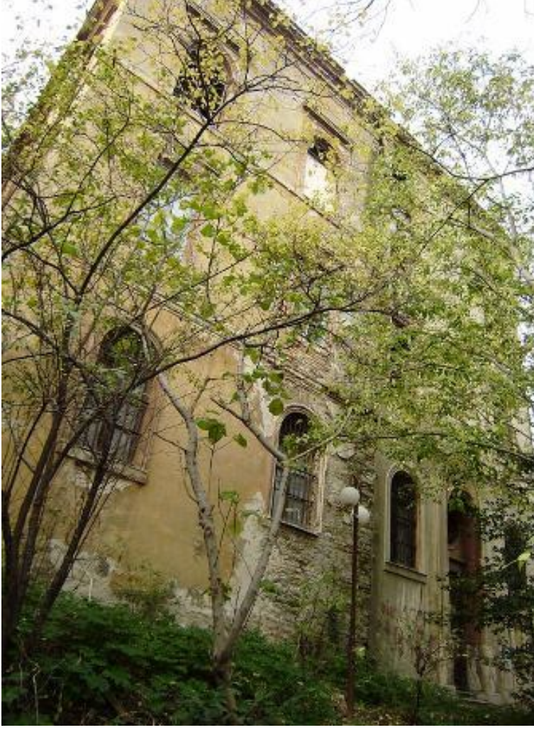
Fotoğraf 156 Doğu cephesi
