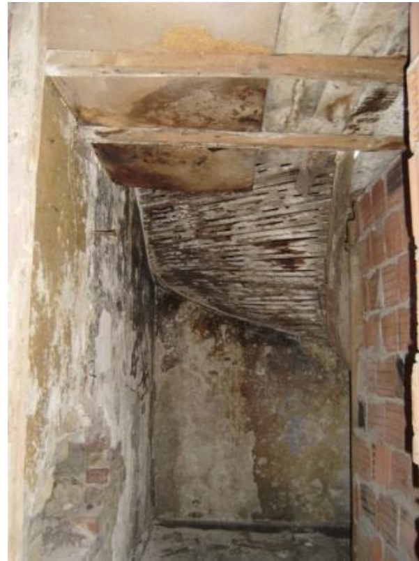
Fotoğraf 172 Eklenti delikli tuğla duvar
