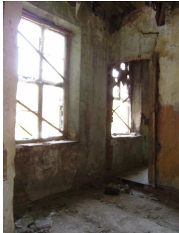
Fotoğraf 67 "B.1K.01" Batı Duvarı
