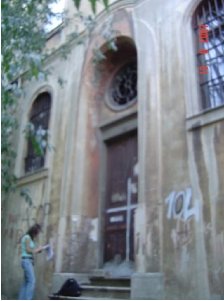
Fotoğraf 158 Doğu cephesi "G2" girişi
