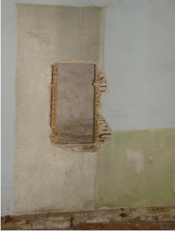
Fotoğraf 19 “B.BK.06” Mekanı kuzey duvarı
