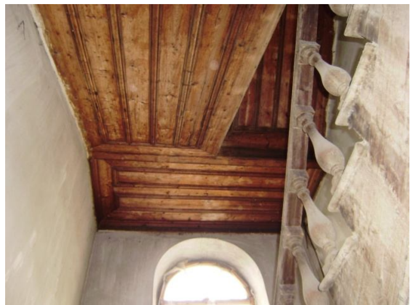
Fotoğraf 101 "M1" Merdiveni +205 Kotu Tavanı
