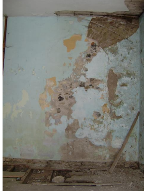
Fotoğraf 20 “B.BK.06” Mekanı kuzey duvarı
