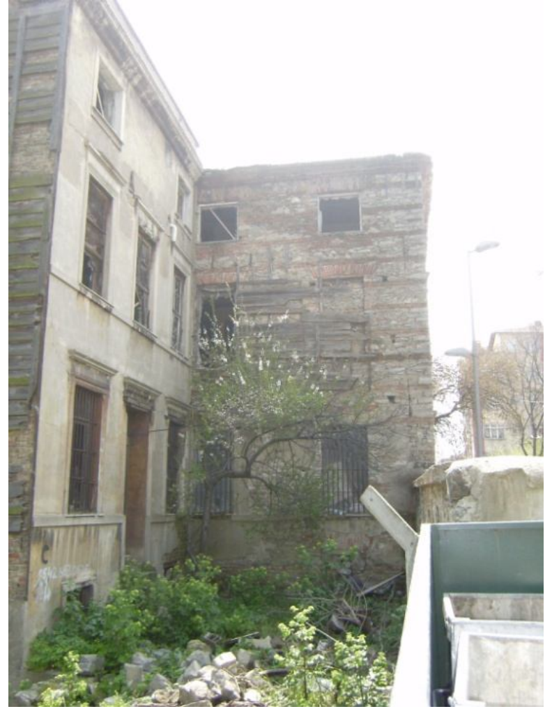
Fotoğraf 161- A Yapısı Kuzey cephesi
