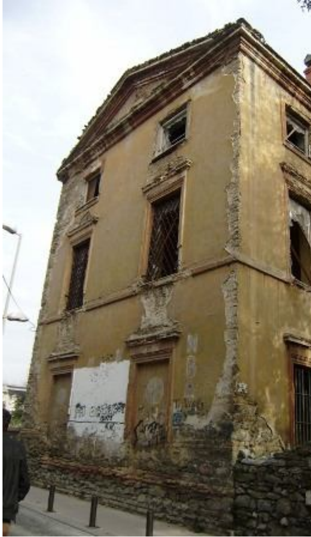
Fotoğraf 146-A yapısı batı cephesi
