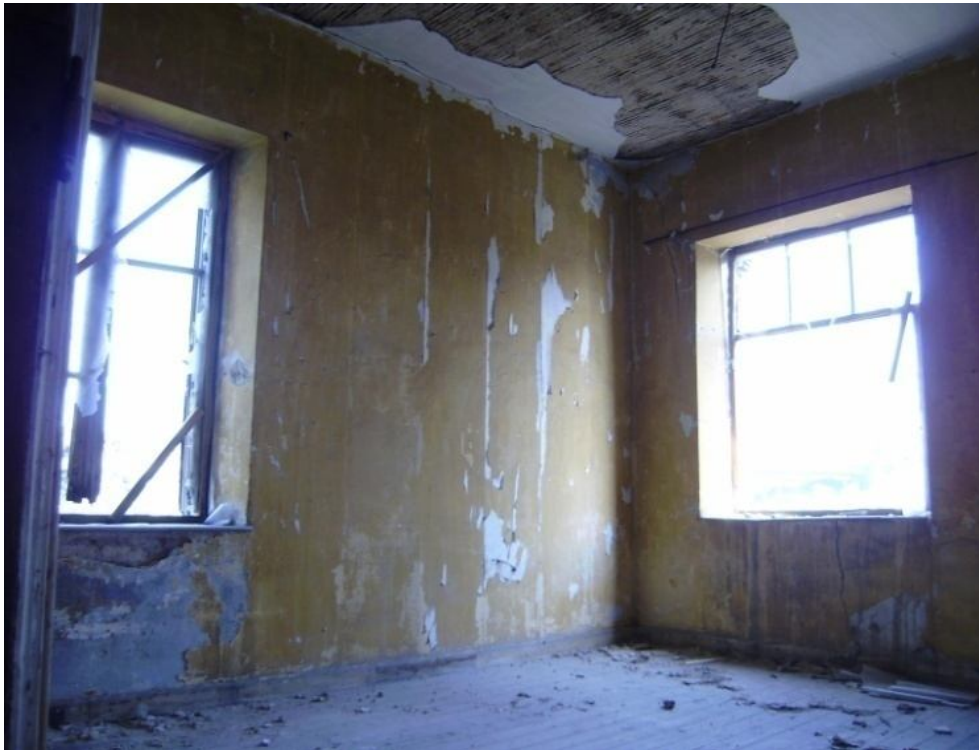
Fotoğraf 79 “B.1K.05” Kuzey ve Doğu Duvarı
