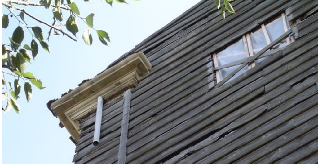
Fotoğraf 162- Kuzey cephesinden detay
