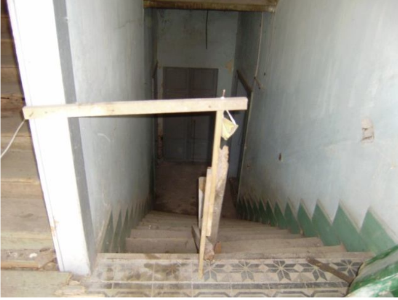
Fotoğraf 97 "M1" Merdiveni -166 Kotu
