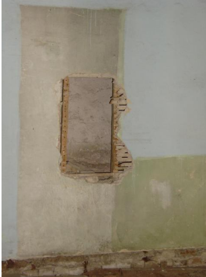
Fotoğraf 190 “A.BK.06” No.lu Mekân “Kuzey Duvarı”
