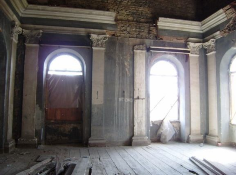
Fotoğraf 70 “A.1K.05” Doğu Duvarı
