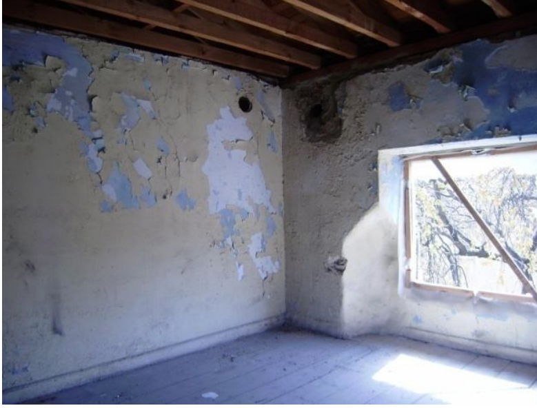
Fotoğraf 85 “A.2K.03” Batı Duvarı
