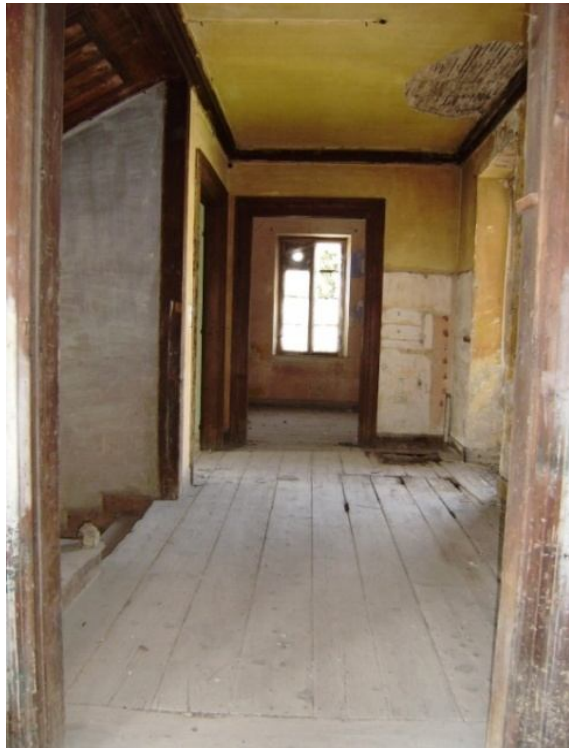
Fotograf 60 “A.1K.04” Batı Duvarı
