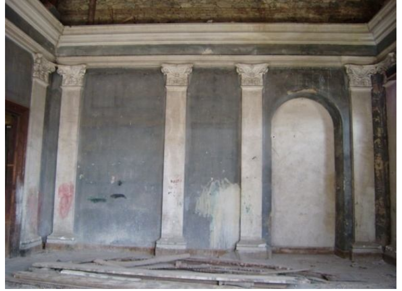
Fotoğraf 71 “A.1K.051” Kuzey Duvarı
