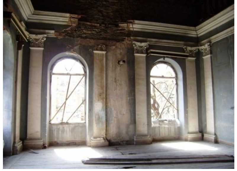
Fotoğraf 69 “A.1K.05” Güney Duvarı
