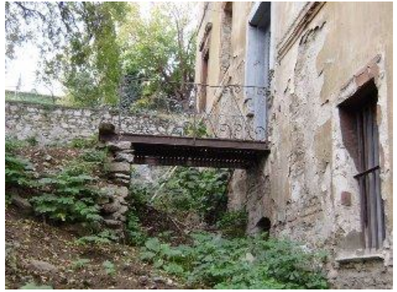
Güney cephesi “G1” girişindeki köprü (bkz. Ek 14. Pafta 18)
