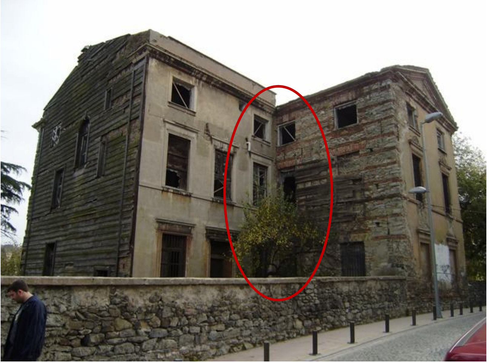
Fotoğraf 195 Kuzey cephe
