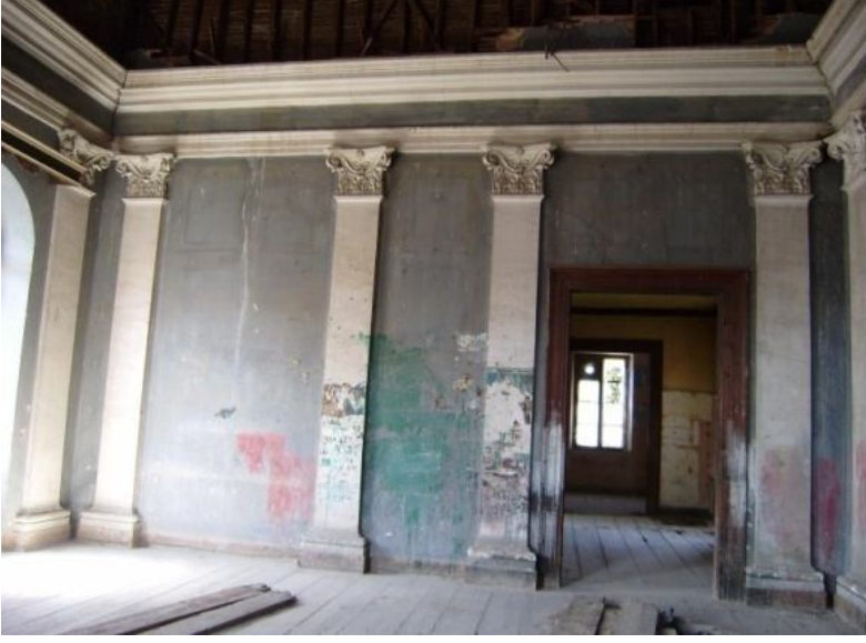
Fotoğraf 68 “A.1K.05” Batı Duvarı
