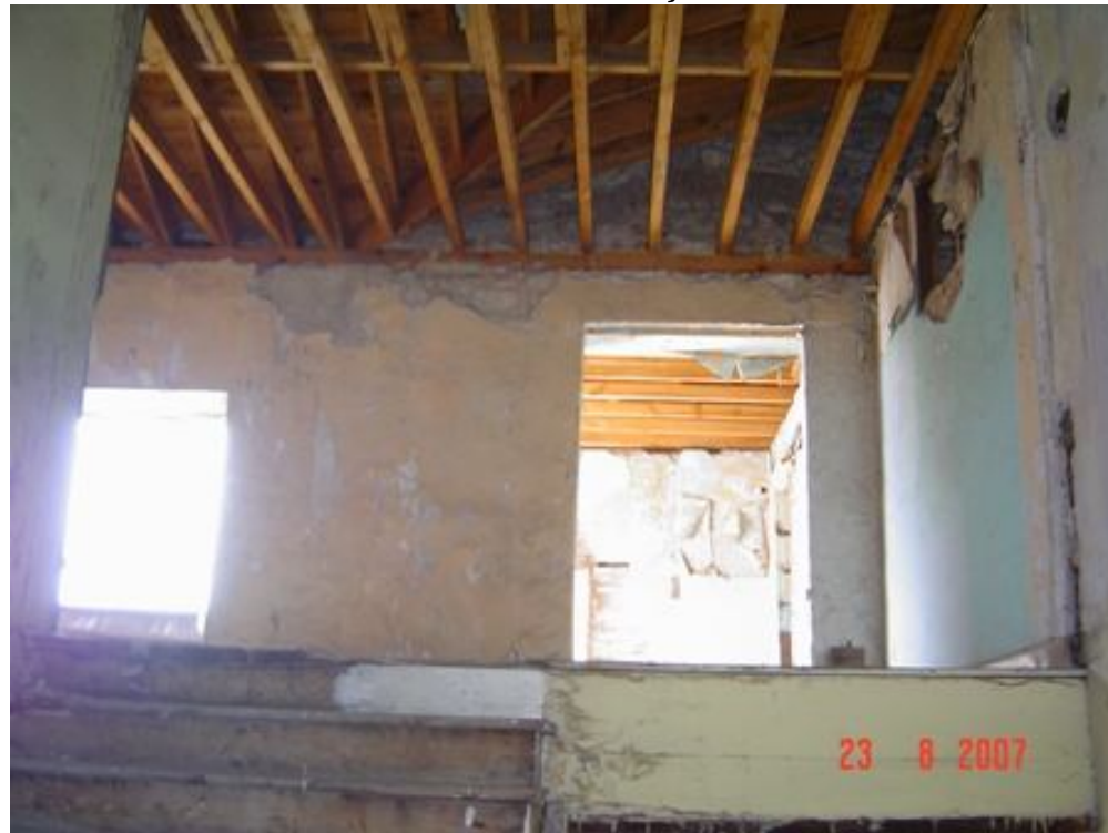
Fotoğraf 106 “M2” Merdiveni +820 Kotu
