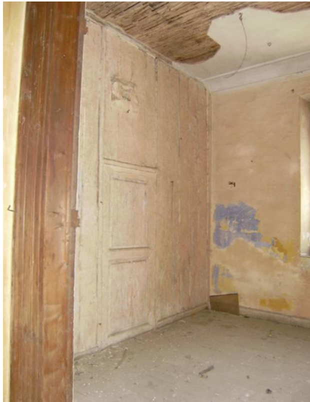
Fotoğraf 171 Ahşap eklenti bölme duvar
