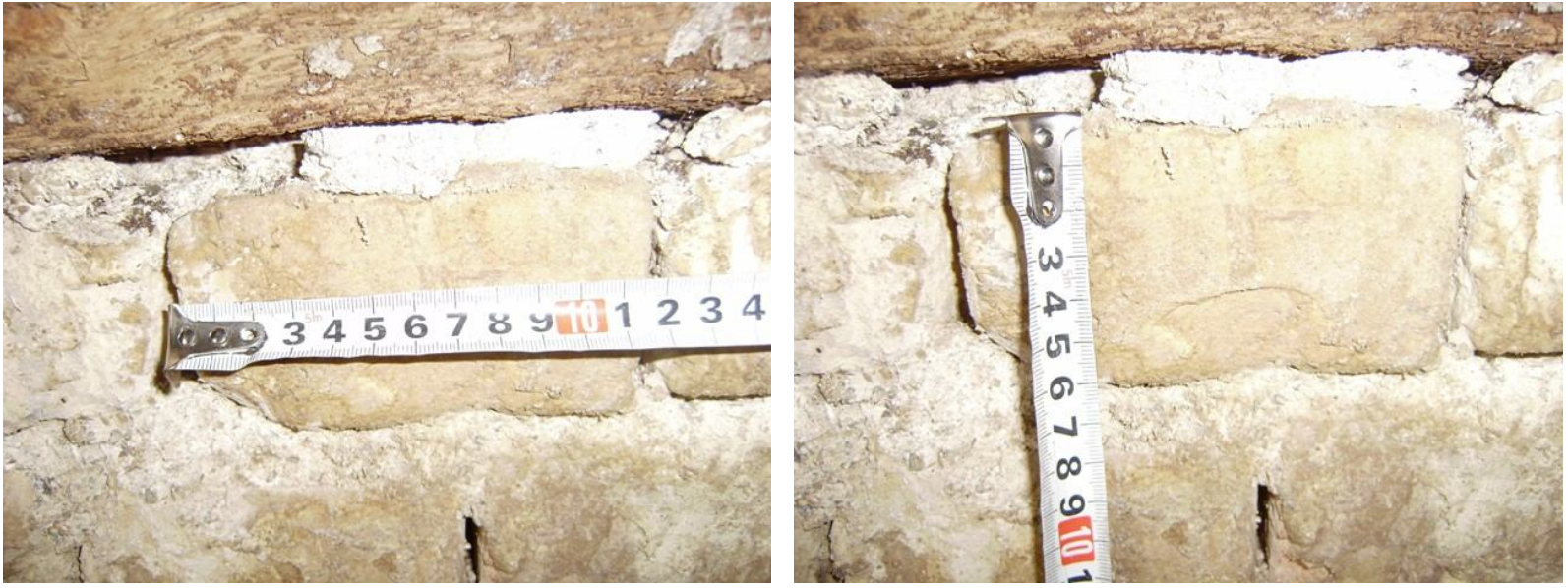
Fotoğraf 177 A yapısı iç duvarlarında kullanılan tuğlalar.
