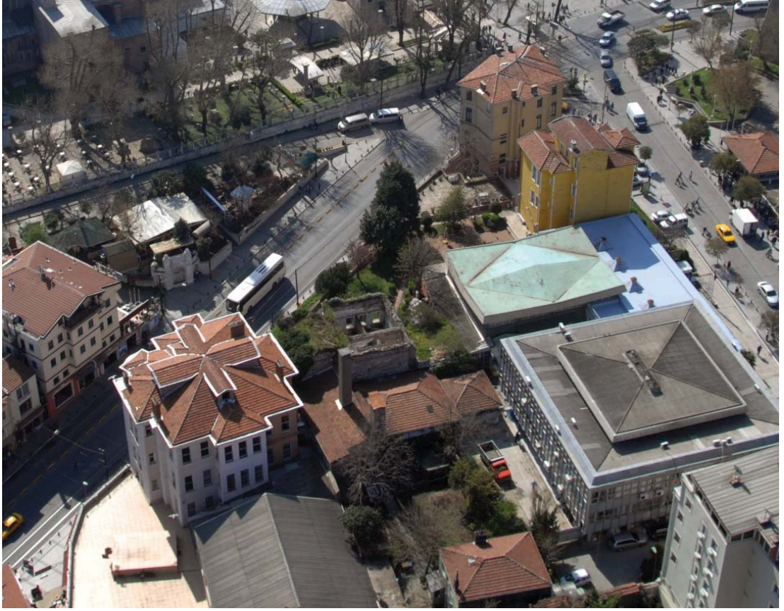
Fotoğraf 2.14. 2010 yılında çekilmiş olan fotoğrafta İl Özel İdare binaları henüz yıkılmamış olarak görülmekte, A. Turan Sepetçi, 2010
