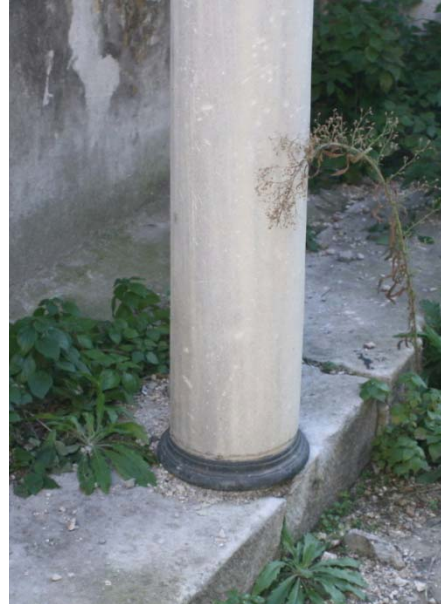
Fotoğraf 4.14. Korozyon etkisi ile fiziksel zarara uğramış olan sütun başlığı Fotoğraf 4.15. Korunmuşluk durumu iyi olan sütun bileziği (sağda)
