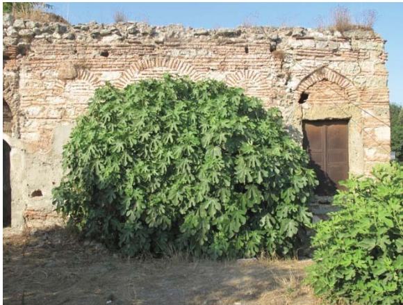
Fotoğraf 4.3. Yapının güneybatı cephesinde gelişmiş olan ağaç (solda) Fotoğraf 4.4. Yapı içerisinde gelişmiş olan ağaç (sağda)
