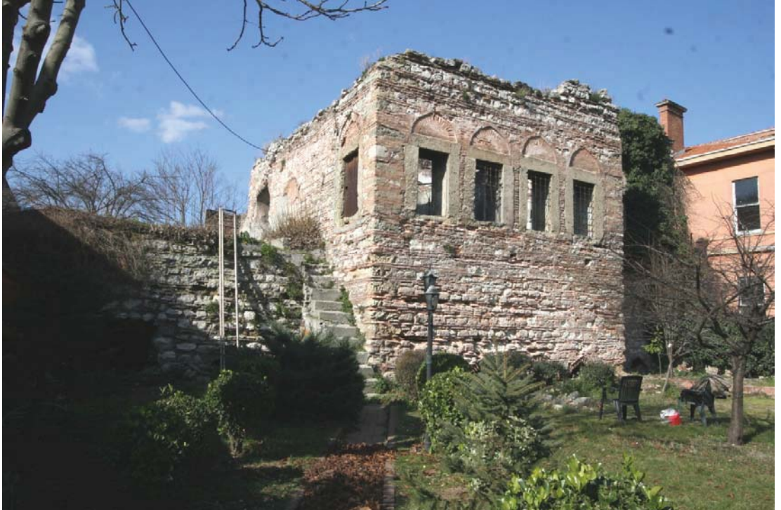
Fotoğraf 2.20. Yapının Güneydoğu cephesi
