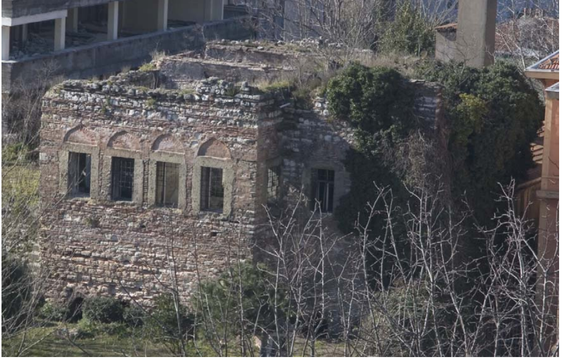
Fotoğraf 2.23.Yapının Güneydoğu ve Kuzeydoğu cepheleri
