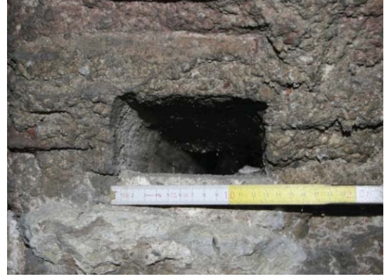
Fotoğraf 4.7. Yapının zemin katındaki boşalmış hatıl yuvası
