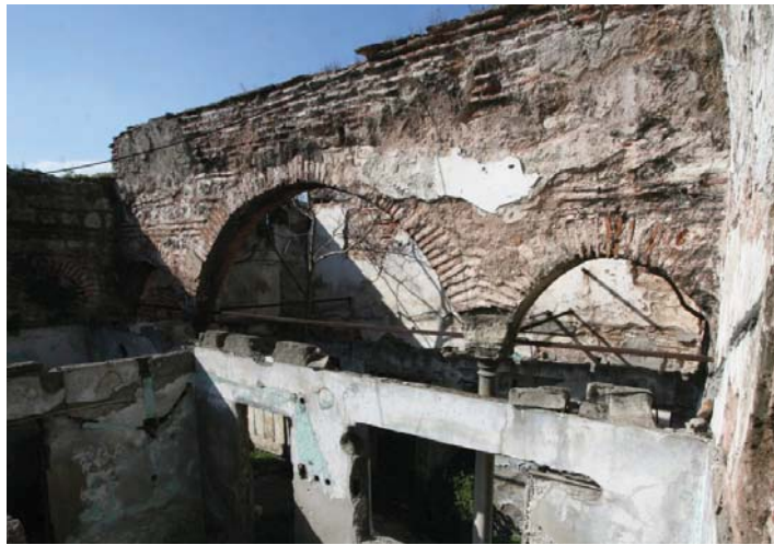
Fotoğraf 2.4. İki sütun ile oluşturulmuş ve ortadaki açıklığı yanlardaki açıklığa oranla daha büyük olan üç açıklıklı geçiş
