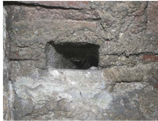
Fotoğraf 2.31. Yapının dış duvarlarında yer alan ahşap hatıl boşlukları Fotoğraf 2.32. Yapının iç duvarlarındaki yer alan ahşap hatıl boşlukları
