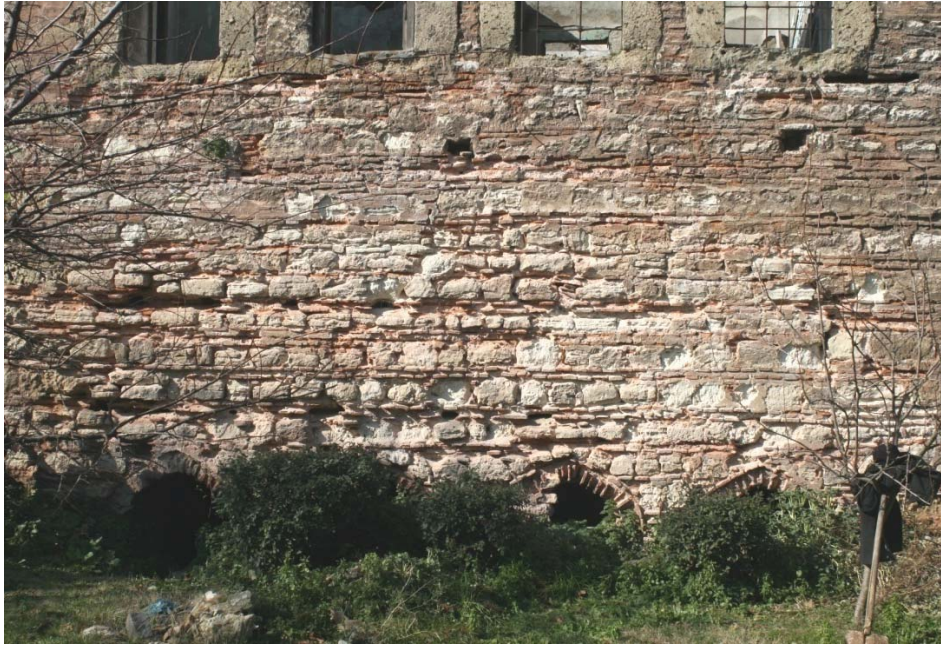
Fotoğraf 2.28. Dış taraftan kot yükselmesi sonucu gömülmüş zemin kat pencereleri
