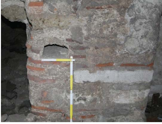
Fotoğraf 4.7. Yapının zemin katındaki boşalmış hatıl yuvası
