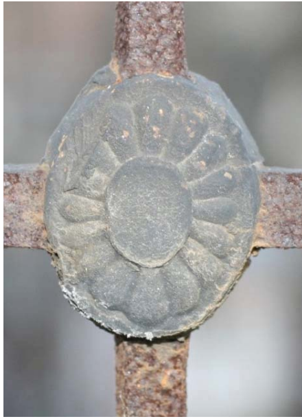
Fotoğraf 4.10. Korozyona uğramış olan parmaklıklar ve kurşun lokma detayı Fotoğraf 4.11. Korozyona uğramış olan parmaklıklar ve kurşun lokma detayı
