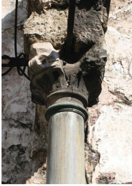
Fotoğraf 4.14. Korozyon etkisi ile fiziksel zarara uğramış olan sütun başlığı Fotoğraf 4.15. Korunmuşluk durumu iyi olan sütun bileziği (sağda)
