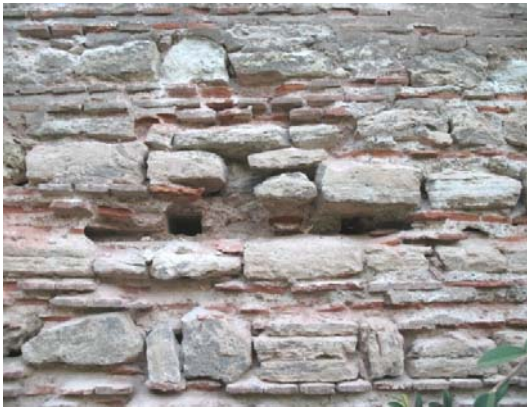
Fotoğraf 2.31. Yapının dış duvarlarında yer alan ahşap hatıl boşlukları Fotoğraf 2.32. Yapının iç duvarlarındaki yer alan ahşap hatıl boşlukları
