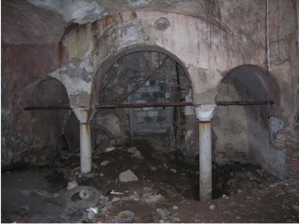
Fotoğraf 2.7. Yapının zemin kat kuzeybatı duvarında iki yanı nişli ve zemin kat girişi olup olmadığı araştırılması gereken alan ve iki mermer sütun ile oluşturulmuş üçlü açıklık
