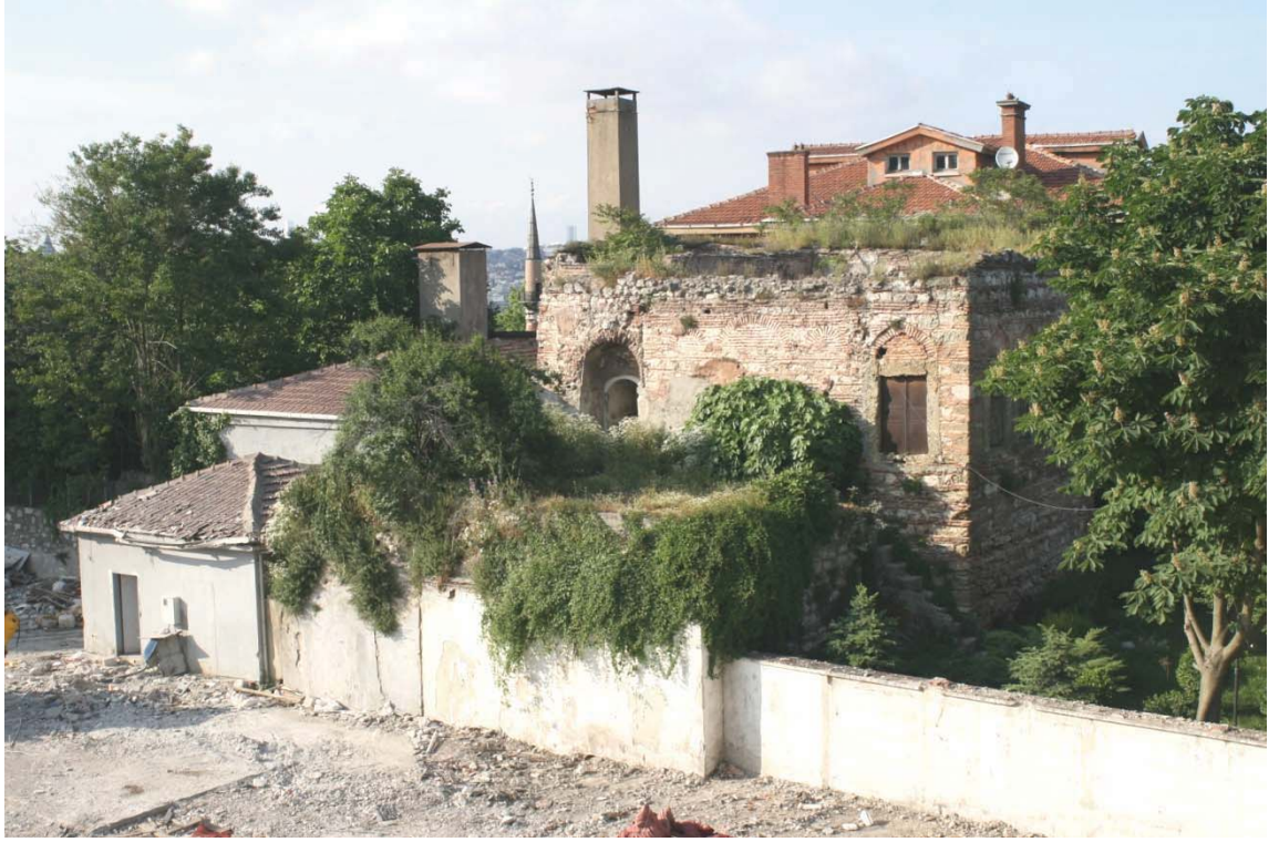
Fotoğraf 2.21. Yapının Güneybatı cephesi
