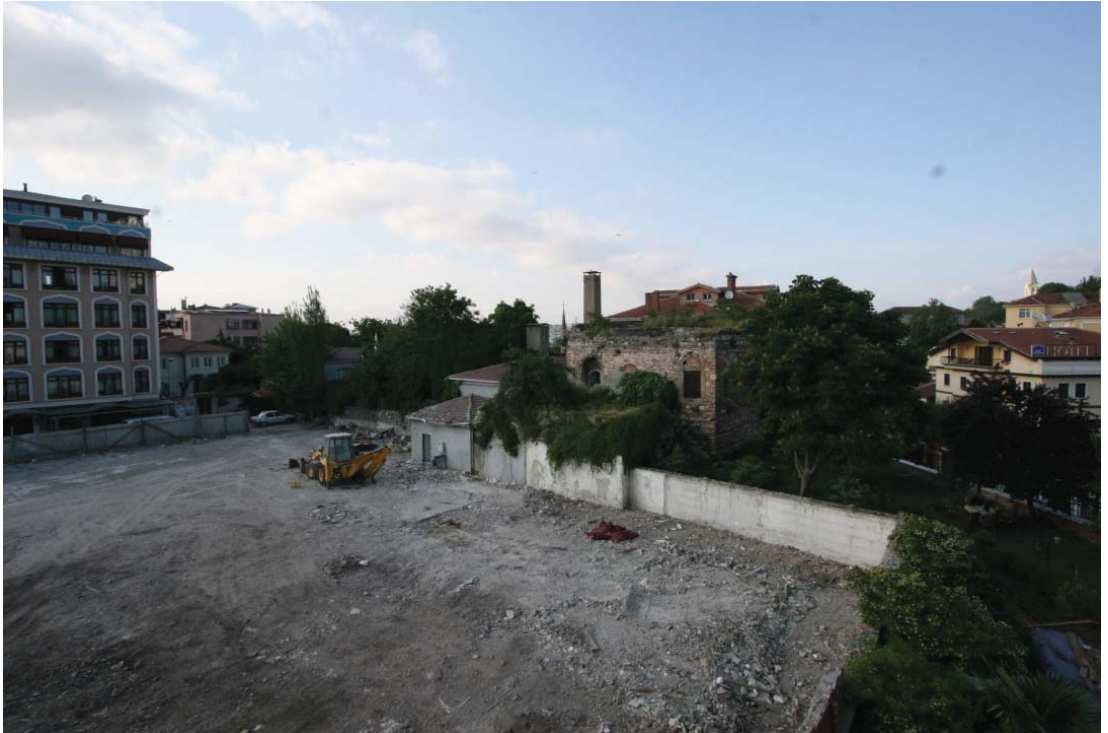
Fotoğraf 2.15. 2011 yılında çekilmiş olan fotoğrafta İl Özel İdare binalarına ait hafriyat kaldırma işlemleri devam etmekte
