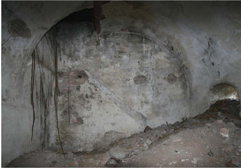
Fotoğraf 2.8. Kuzeydoğu iç cephe duvarında görülen merdiven izi
