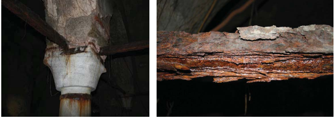
Fotoğraf 4.12. Zemin katta yer alan gergi ve sütun bilezik metallерinin mevcut durumu Fotoğraf 4.13. Zemin katta yer alan gergi metalinin detayı
