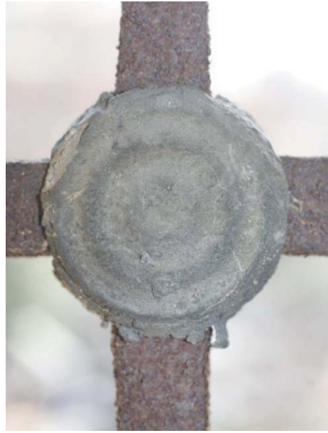
Fotoğraf 4.10. Korozyona uğramış olan parmaklıklar ve kurşun lokma detayı Fotoğraf 4.11. Korozyona uğramış olan parmaklıklar ve kurşun lokma detayı
