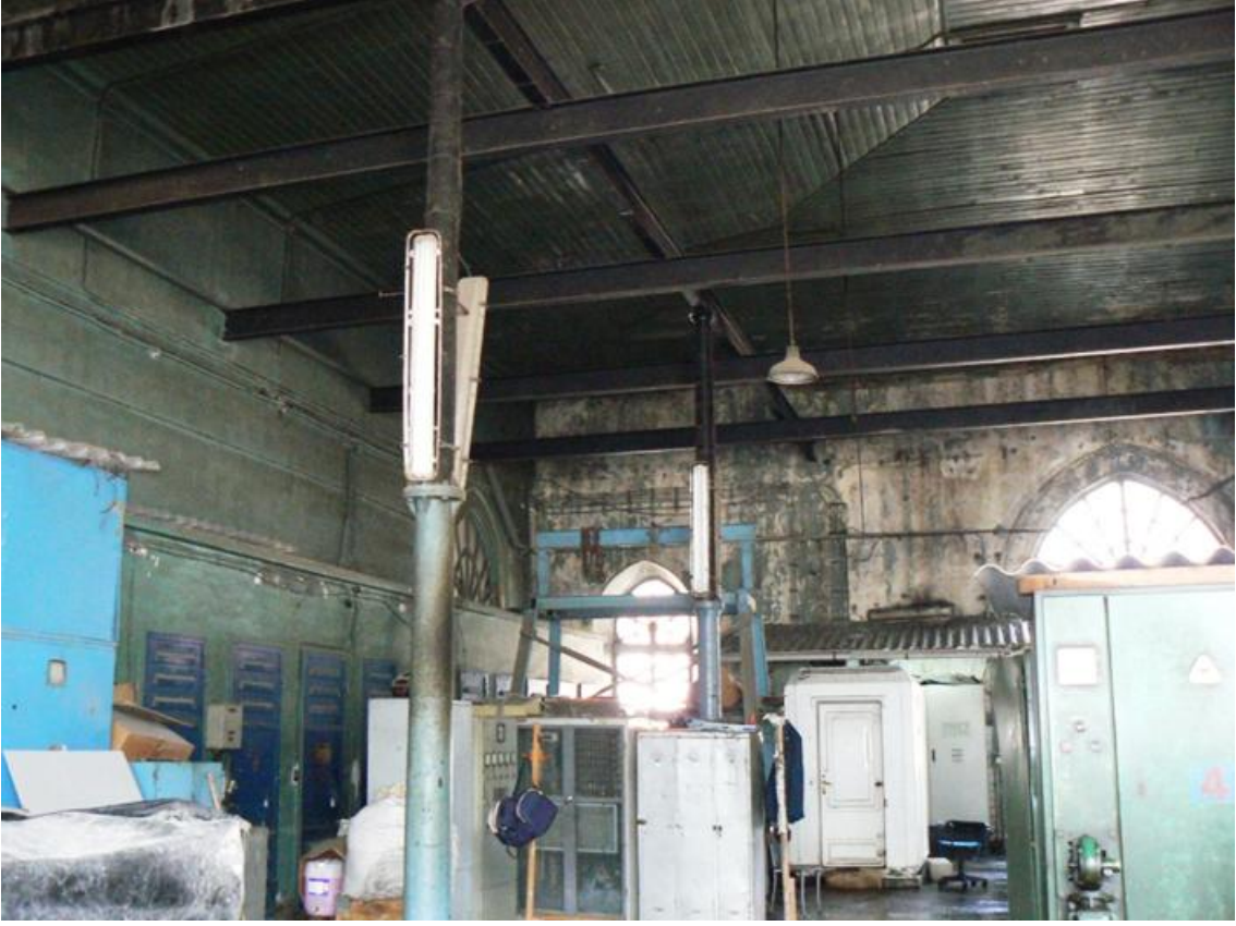
Resim 77: Duvarlarda görülen küf izleri. (Eda Kavakdipli)
