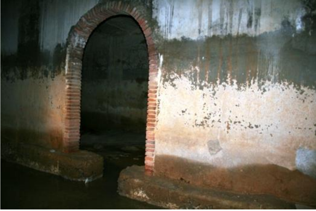
Resim 85: Erken dönem son çökeltme haznesinin sıvalı ve badana kalıntılı duvarları. (Boygaz Özlen)
