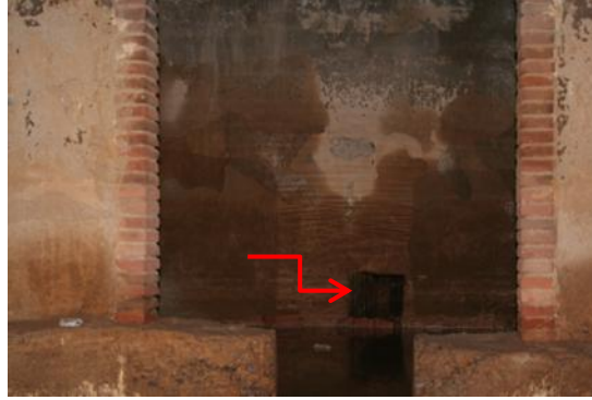
Resim 55: Dörtgen havuzları arka duvarlarında bulunan menhollere örnek. (Boygaz Özlen)
