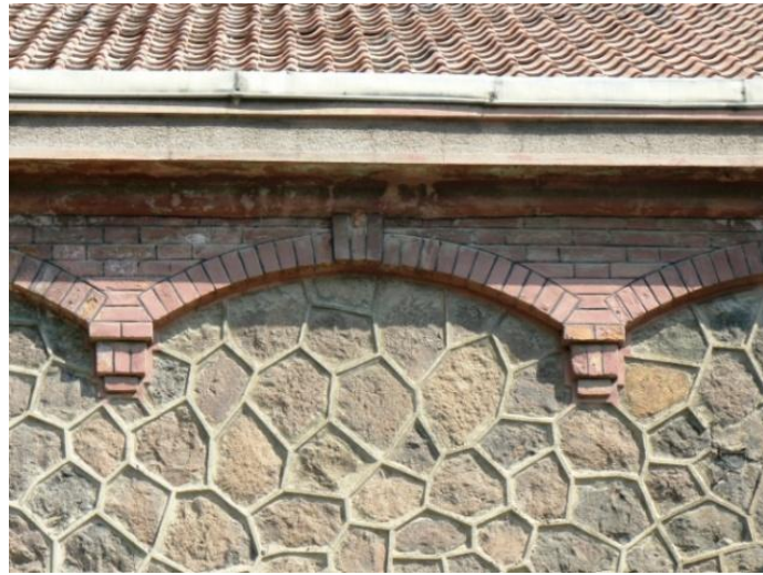
Resim 30: Sadece güney cephesinde bulunan, saçak altı kemer süslemeleri. (Eda Kavakdipli)
