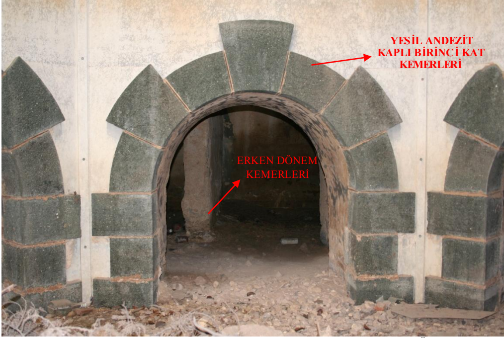
Resim 57: Birinci kat kemerleri ve boyutsal uyumsuzlukları. (Boygaz Özlen)
