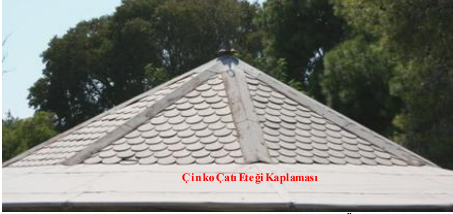
Resim 72: Çinko çatı etekleri kaplaması. (Boygaz Özlen)
