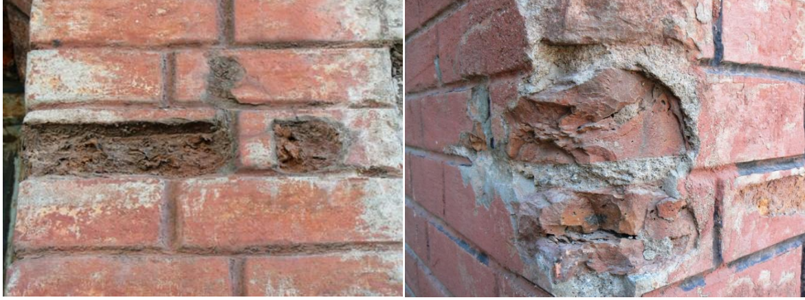
Resim 80:Yüzeysel aşınmaya uğramış tuğlalara örnek. (Eda Kavakdipli)
