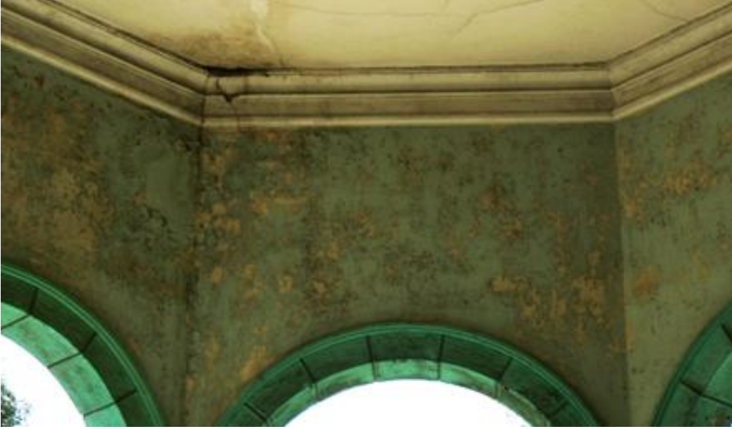
Resim 86: Badanası kabarmış kemer duvarlarının iç yüzleri. (Eda Kavakdipli)
