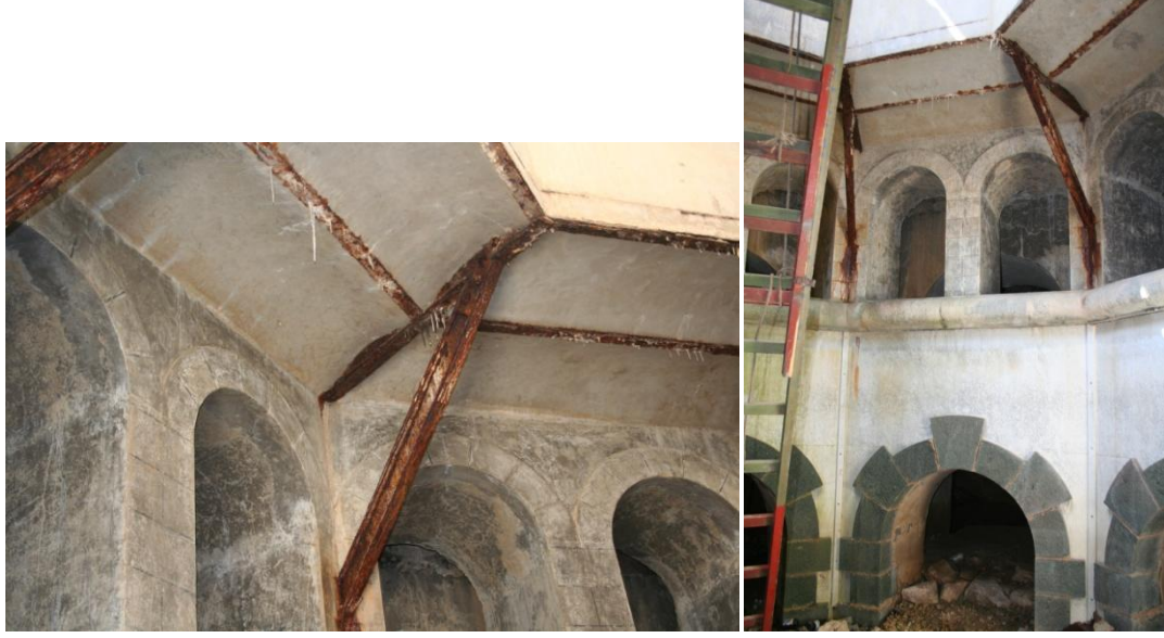
Resim 60: İkinci kat kemerlerinin orta duvarlarından çıkan çelik payandalar ve taşıdığı volta döşeme ve bir ve ikinci kat kemerlerinin birlikte görünümü. (Boygaz Özlen)
