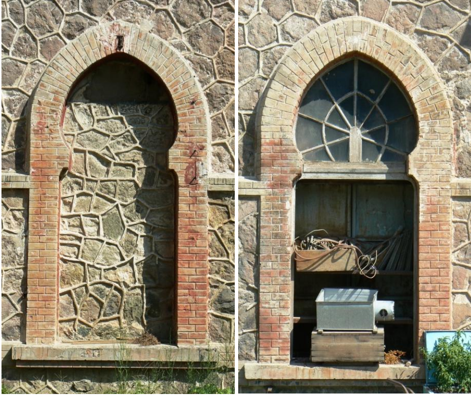
Resim 38: Duvar örülerek kapatılmış P10 ve raf eklenerek kullanılan P12 nolu pencereler. (Eda Kavakdıplı)
