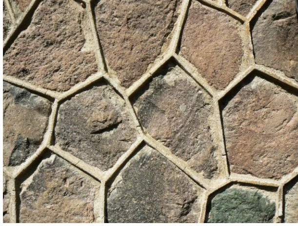
Resim 26: Mozaik taş duvar ve kabartma derz uygulaması. (Eda Kavakdıplı)
