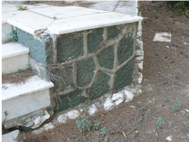
Resim 63: Yeşil andezit moloz taştan subasman, mermer kaplama merdiven ve zemin. (Eda Kavakdipli)
