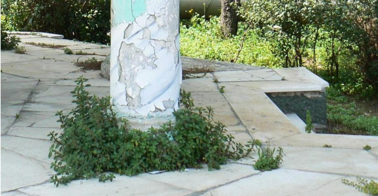
Resim 76: Sütun altlıklarından ve mermer kaplamaların arasından çıkan bitkiler. (Eda Kavakdipli)
