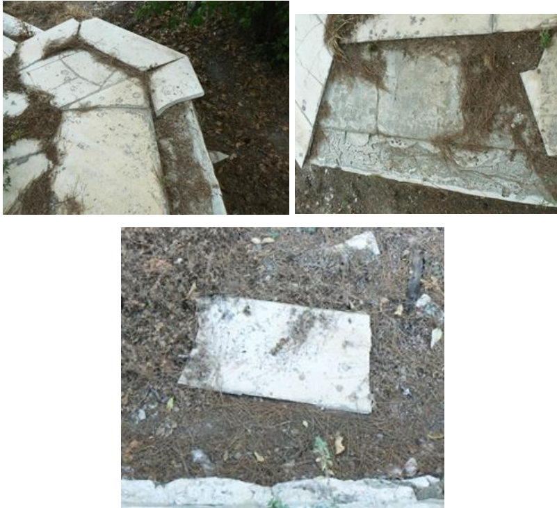
Resim 81: Mermer zemin döşeme ve zeminden ayrılan parçalar. (Eda Kavakdipli)
