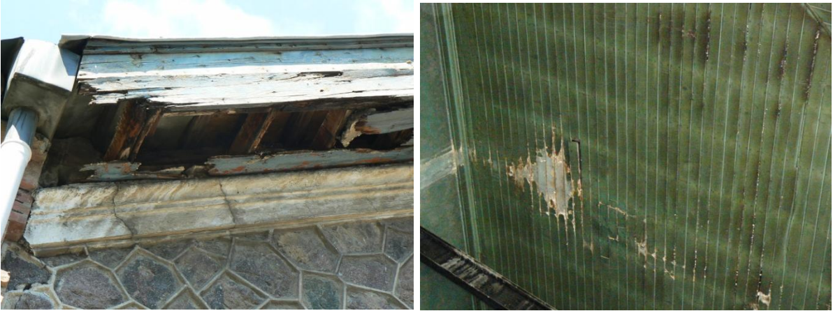
Resim 78: Çürümekte olan çatı ve tavanın durumu. (Eda Kavakdipli)
