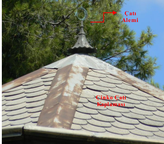
Resim 71: Çinko çatı kaplaması ve çatı alemi. (Eda Kavakdipli)
