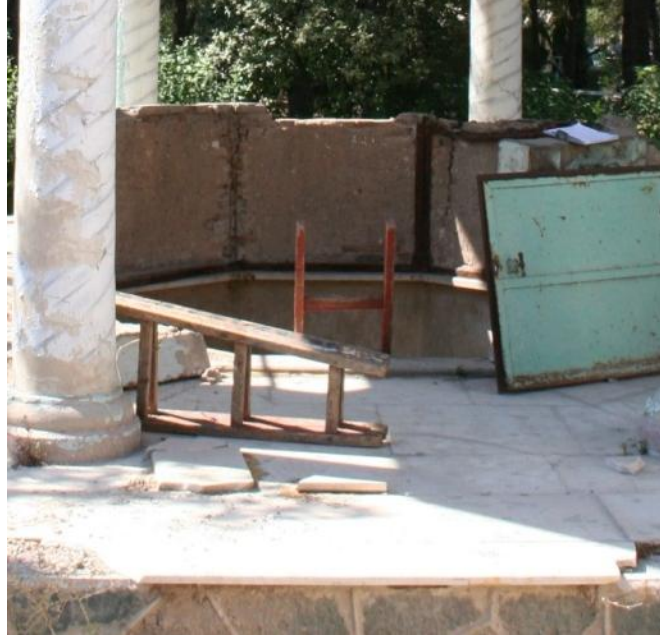
Resim 64: Sonradan yapılmış korkuluk duvarının 2005 yılındaki durumu. (Boygar Özlen)
