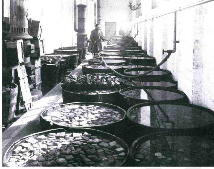
Fotoğraf 4.13. İřtar Kapısı ve Tören Yolu sırlı tuęla parçalarının tuzdan arındırma işlemleri 1928 yılı fotoğrafı.
