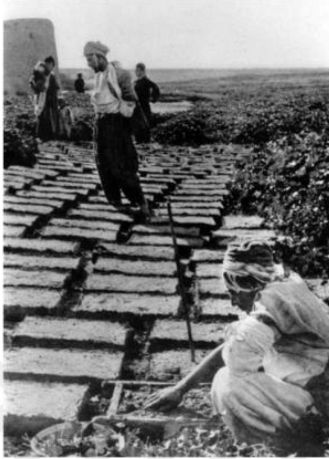
Fotoğraf 5.1 1915 yılı Dicle Nehri kıyısında güneşte kurutulan kerpiç (Kaynak: Bertman, 2003, s.187)
