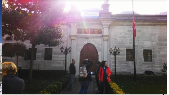
Şekil 138 Nuruosmaniye İmareti kuzey cephesi (A. GELİR ÇELEBİ)
