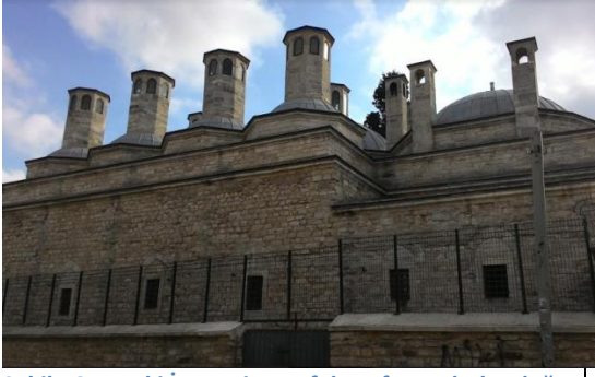
Şekil 56 Haseki İmareti- Mutfak ve fırının bulunduğu kuzey cephesi (A. GELİR ÇELEBİ)
