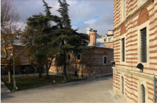
Şekil 146 Laleli İmaret-Güneybatı cephesi (A. GELİR ÇELEBİ)
