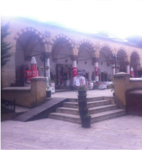
Şekil 67 Güney cephesi (A. GELİR ÇELEBİ)
