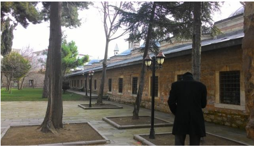
Şekil 44 İmaretin doğu cephesi (A. GELİR ÇELEBİ)
