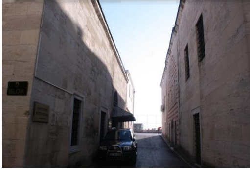
Şekil 118 Solda mutfağın batı cephesi- Sağda mekelin doğu cephesi (A. GELİR ÇELEBİ)
