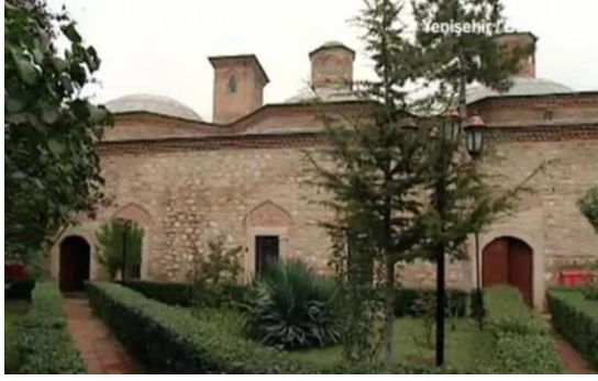
Şekil 87 İmaretin Güney Cephesi ( http://www.kulturportali.gov.tr/turkiye/bursa/kulturenvanteri/sinan-pasa-mareti )
