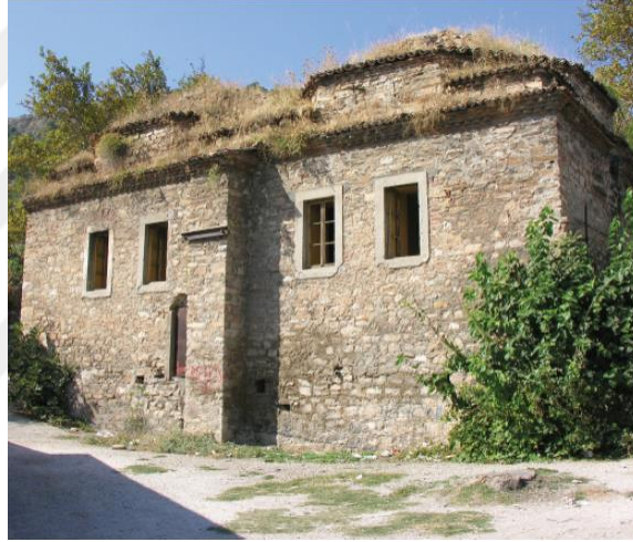
Şekil 111 İmaretin güney cephesinden görünüm (Ş. Çakmak, "Gölmarmara...", s. 41.)
