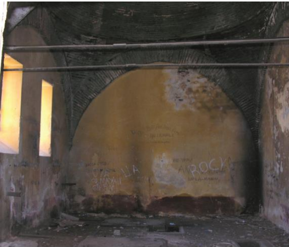
Şekil 112 İç mekandan (Ş. Çakmak, "Gölmarmara...", s. 46.)
