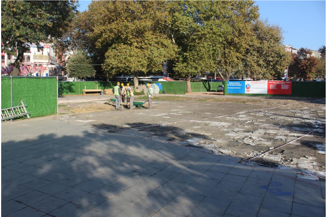
Fotoğraf C.4: Beşiktaş Metro İstasyonu alanı (03.10.2016)
