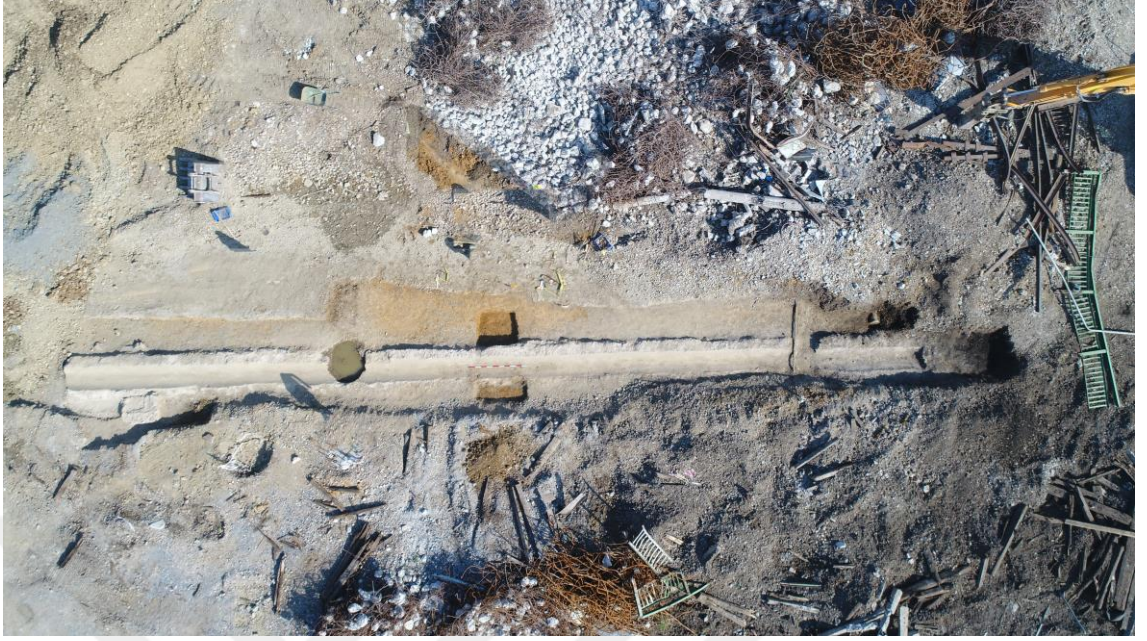
Fotoğraf D.5: Tıbbiye Köprüsü G2 ayağı kazısında açığa çıkarılan ve Bölge Koruma Kurulu kararıyla taşınan Osmanlı Dönemi su kanalı (04.07.2018)
