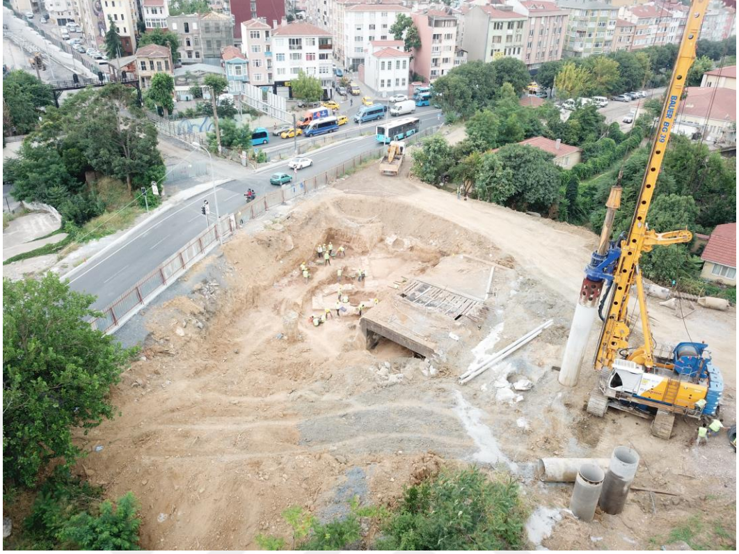
Fotoğraf D.21: Seyit Ahmed Köprüsü inşa çalışmaları ve kazı alanı (18.07.2018)
