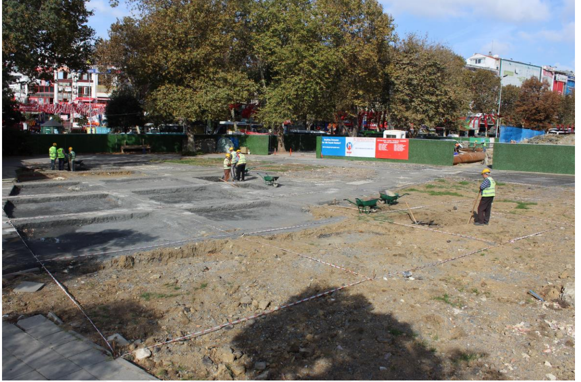
Fotoğraf C.7: Beşiktaş Metro İstasyonu alanı (21.10.2016)
