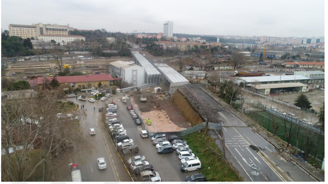
Fotoğraf D.11: Tıbbiye Köprüsü inşa çalışmaları ve G8 ayağı kazı alanının kapatılması (02.01.2019)
