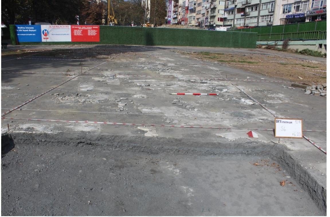
Fotoğraf C.5: Beşiktaş Metro İstasyonu alanı (12.10.2016)
