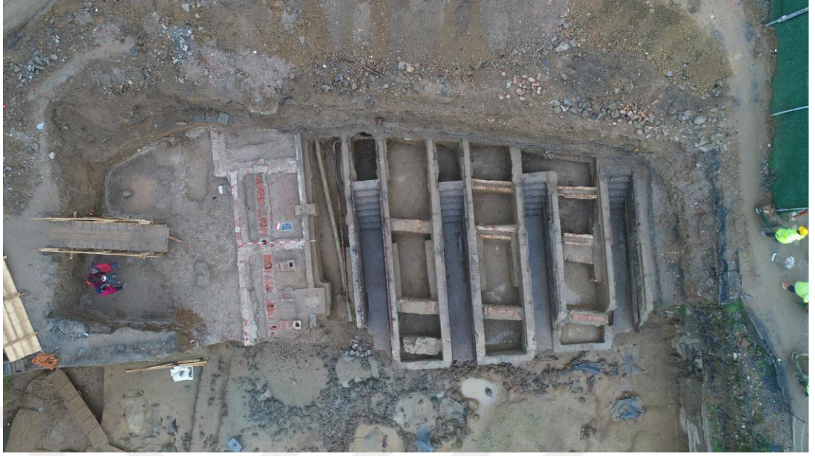
Fotoğraf C.29: Beşiktaş Metro İstasyonu alanı (22.01.2018)
