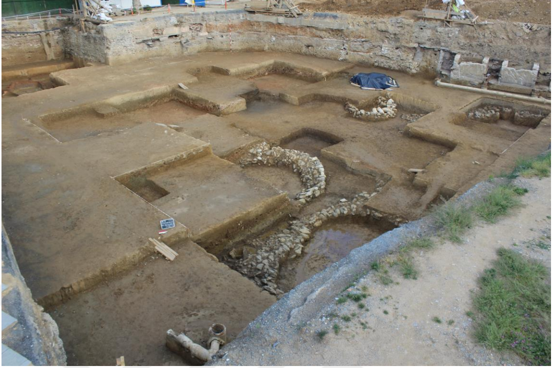
Fotoğraf C.21: Beşiktaş Metro İstasyonu alanı (23.05.2017)
