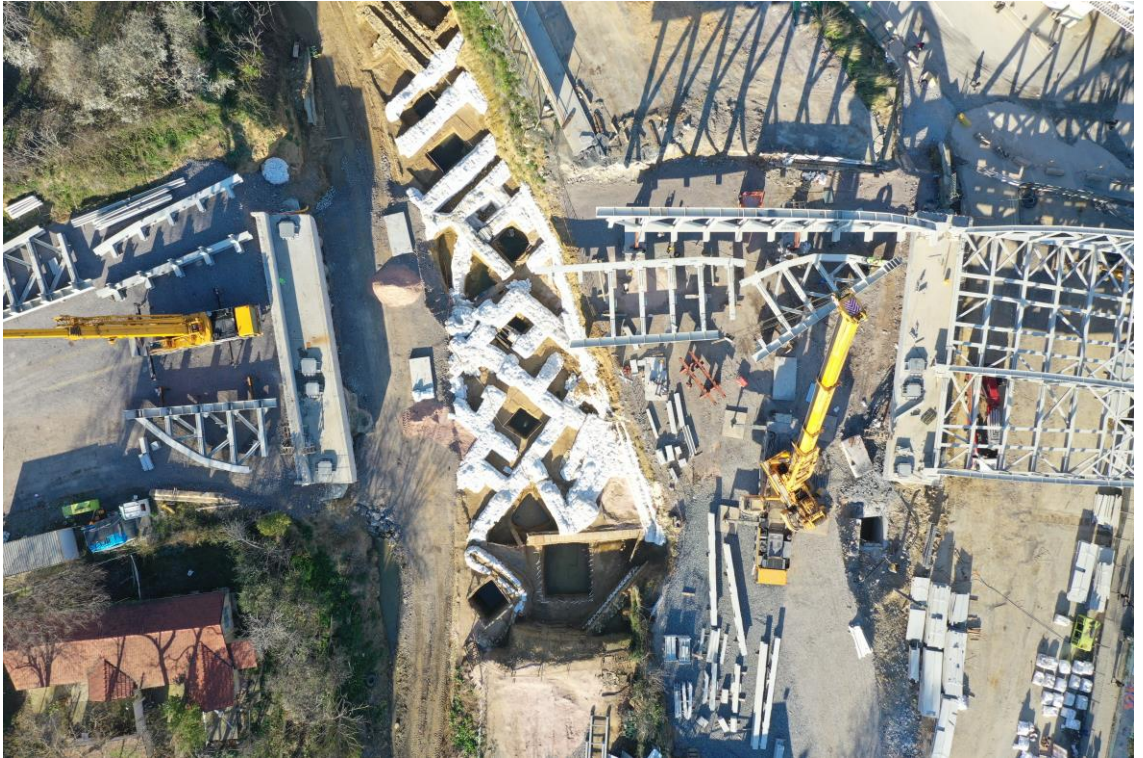
Fotoğraf D.30: Seyit Ahmed Köprüsü inşa çalışmaları ve kazı alanı (12.03.2020)
