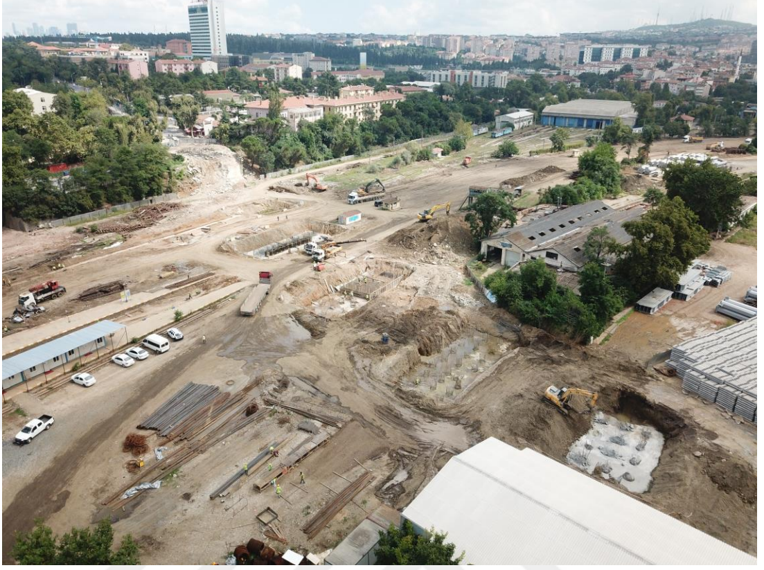
Fotoğraf D.3: Tıbbiye Köprüsü inşa çalışmaları (30.07.2018)
