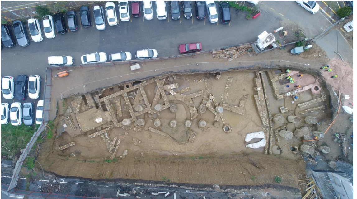
Fotoğraf D.8: Tıbbiye Köprüsü G8 ayağı kazı çalışmaları (10.12.2018)
