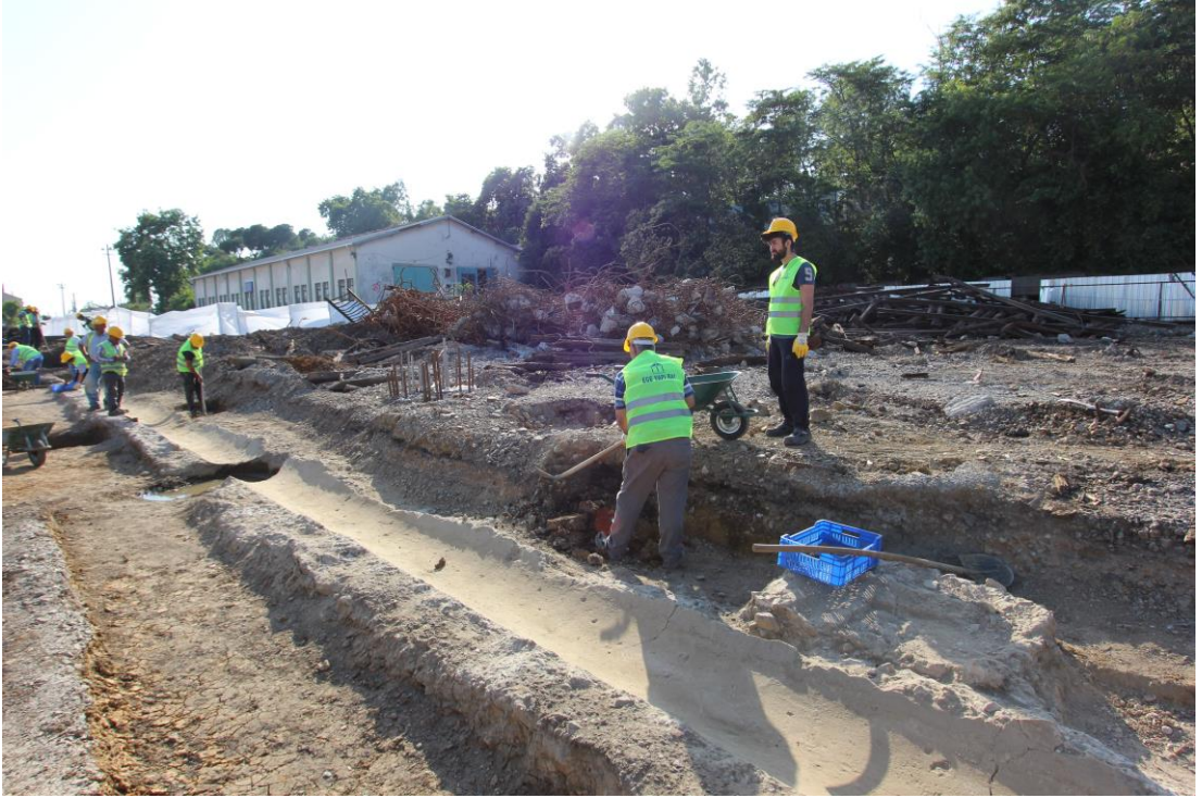
Fotoğraf D.4: Tıbbiye Köprüsü G2 ayağı kazısında açığa çıkarılan ve Bölge Koruma Kurulu kararıyla taşınan Osmanlı Dönemi su kanalı (04.07.2018)
