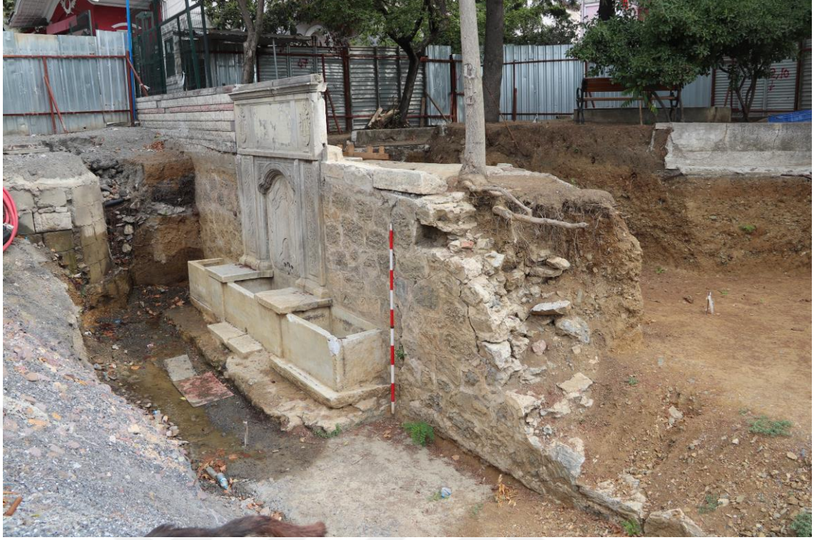
Fotoğraf D.13: Tıbbiye Köprüsü G1 ayağında açığa çıkarılan Abdülmecid Han Çeşmesi (10.08.2019)
