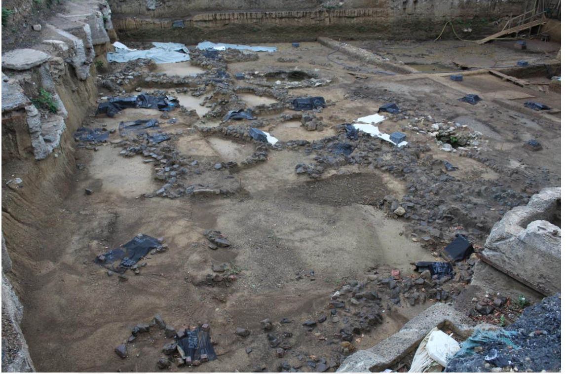
Fotoğraf C.25: Beşiktaş Metro İstasyonu alanı (30.09.2017)
