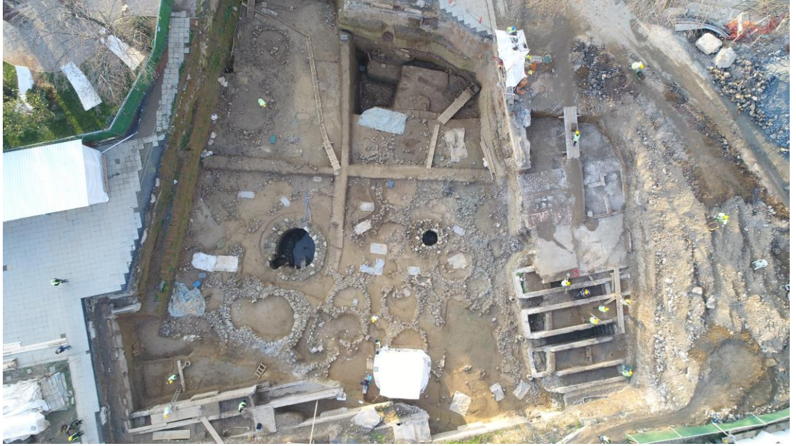
Fotoğraf C.28: Beşiktaş Metro İstasyonu alanı (08.01.2018)
