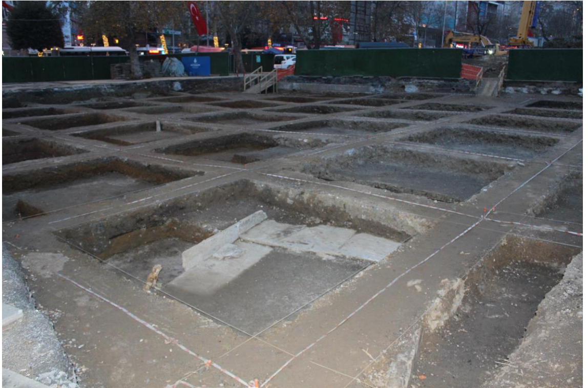
Fotoğraf C.10: Beşiktaş Metro İstasyonu alanı (12.12.2016)
