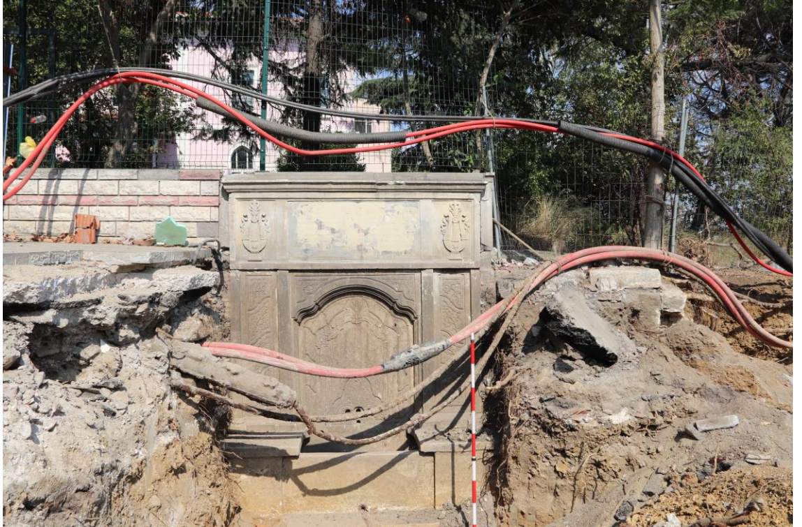
Fotoğraf D.12: Tıbbiye Köprüsü G1 ayağında açığa çıkarılan Abdülmecid Han Çeşmesi (29.08.2018)
