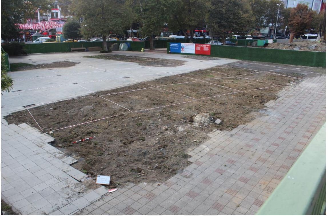
Fotoğraf C.3: Beşiktaş Metro İstasyonu alanı (27.09.2016)
