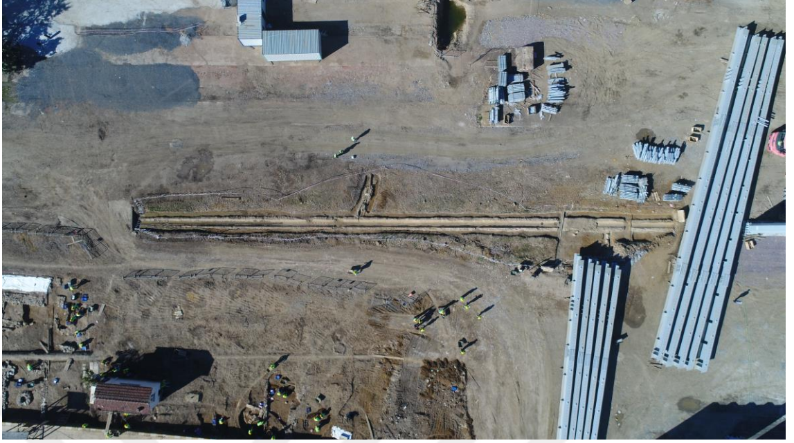
Fotoğraf D.7: Tıbbiye Köprüsü G2 ayağı kazısında açığa çıkarılan ve Bölge Koruma Kurulu kararıyla taşınan Osmanlı Dönemi su kanalı (06.10.2018)
