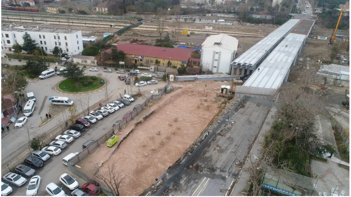
Fotoğraf D.10: Tıbbiye Köprüsü inşa çalışmaları ve G8 ayağı kazı alanının kapatılması (02.01.2019)
