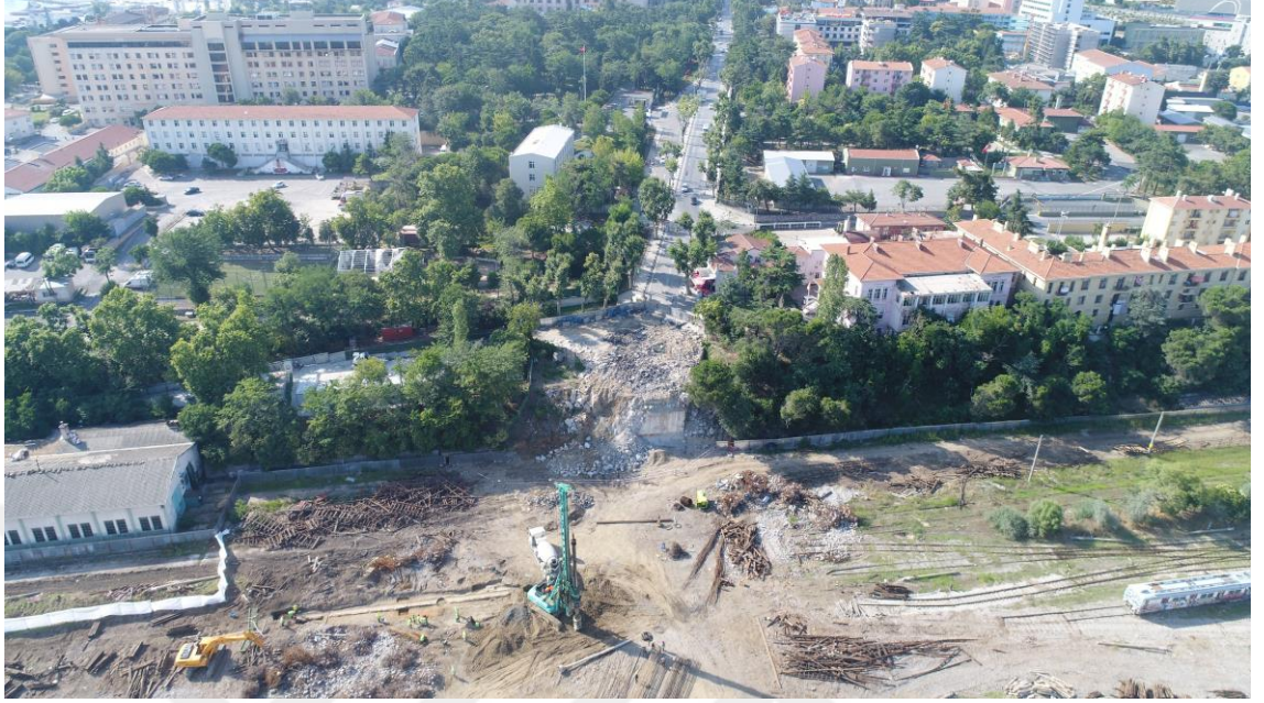
Fotoğraf D.1: Tıbbiye Köprüsü inşa çalışmaları (04.07.2018)
