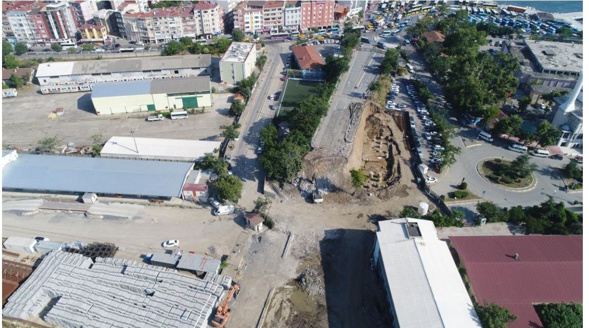
Fotoğraf D.2: Tıbbiye Köprüsü G8 ayağı kazı çalışmaları (04.07.2018)
