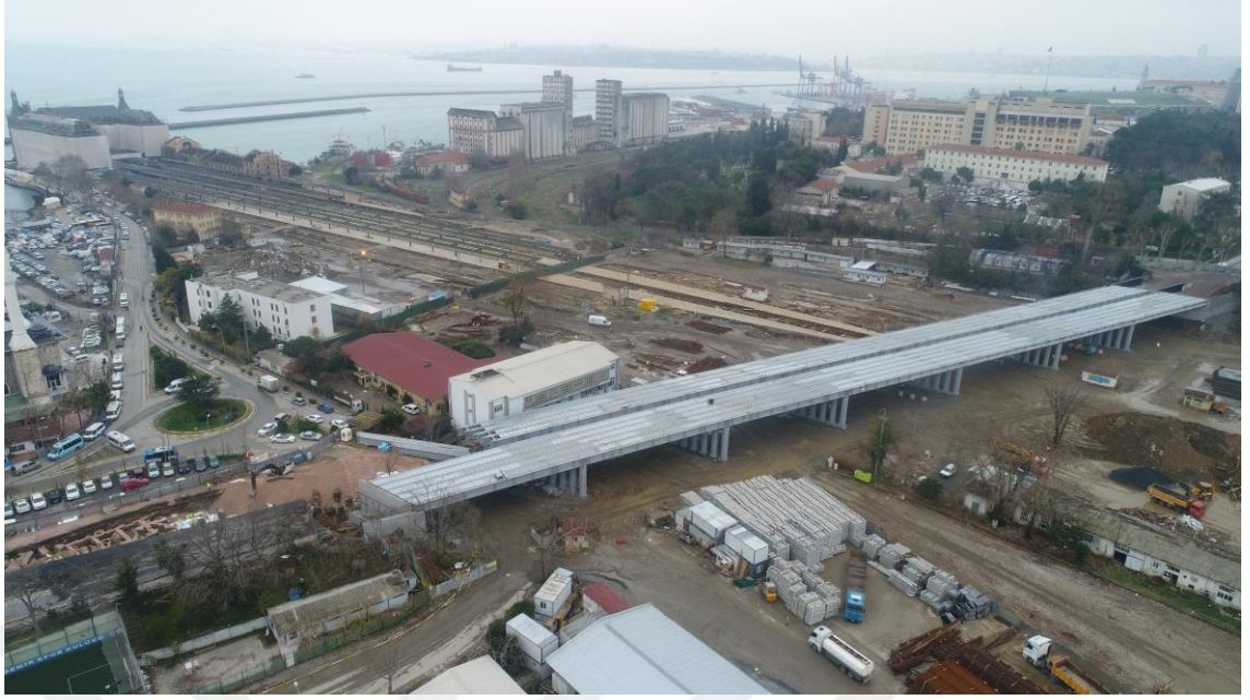
Fotoğraf D.9: Tıbbiye Köprüsü inşa çalışmaları ve G8 ayağı kazı alanı (solda) (20.12.2018)
