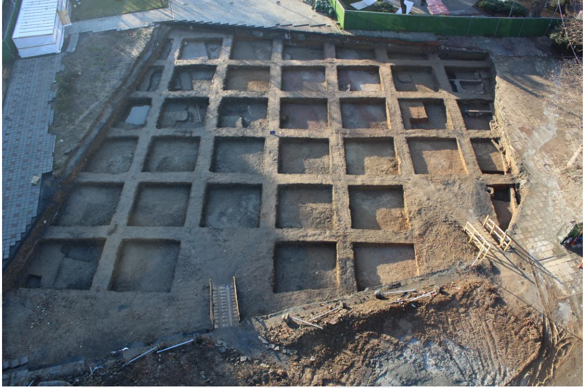
Fotoğraf C.11: Beşiktaş Metro İstasyonu alanı (27.12.2016)
