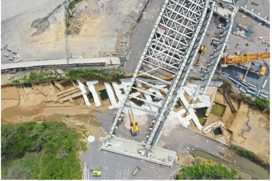
Fotoğraf D.31: Seyit Ahmed Köprüsü inşa çalışmaları ve kazı alanı (22.04.2020)
