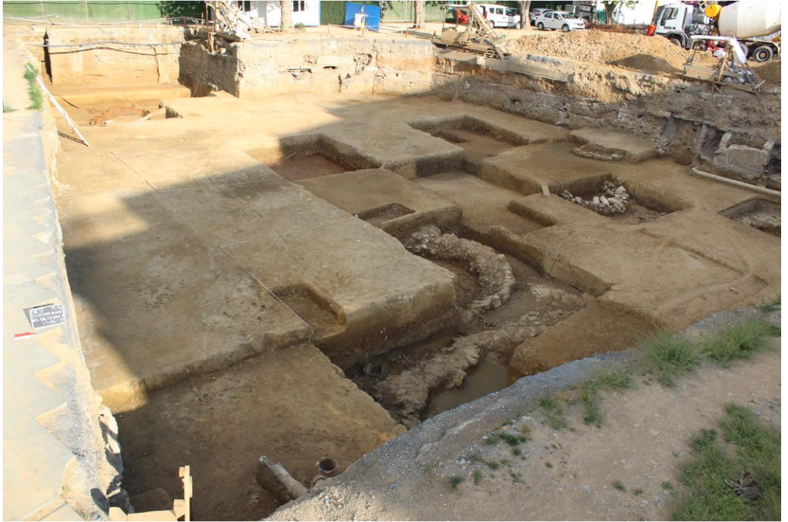
Fotoğraf C.20: Beşiktaş Metro İstasyonu alanı (15.05.2017)
