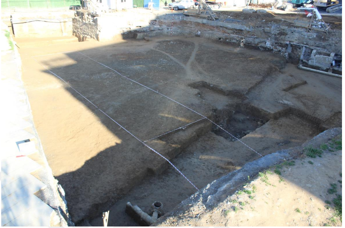
Fotoğraf C.19: Beşiktaş Metro İstasyonu alanı (25.04.2017)
