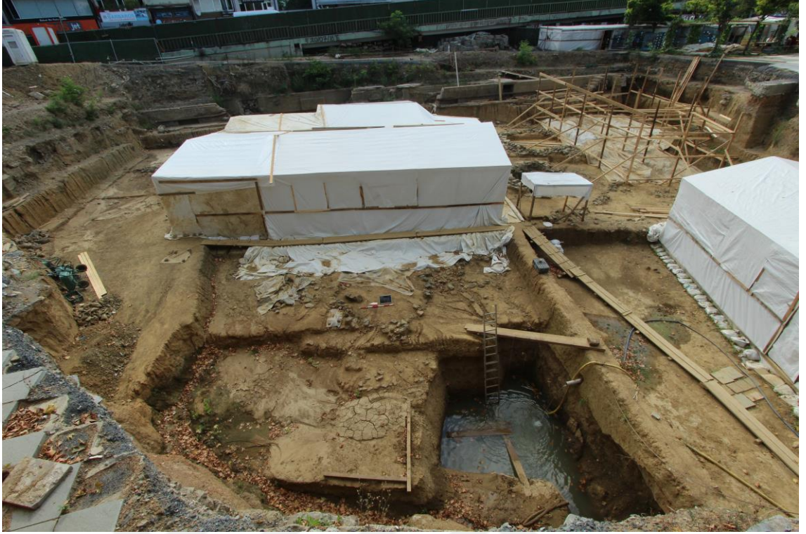
Fotoğraf C.36: Beşiktaş Metro İstasyonu alanı (14.07.2018)
