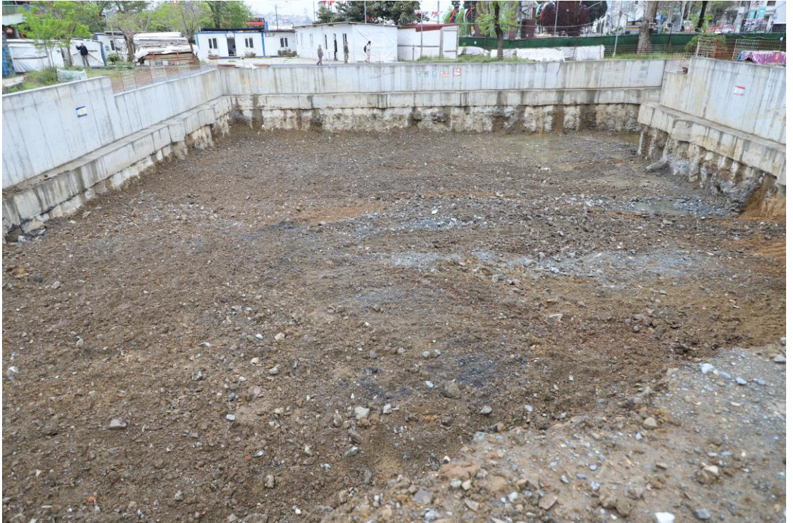
Fotoğraf C.41: Beşiktaş Metro İstasyonu alanı (04.05.2020)
