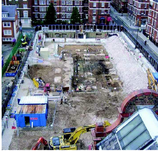
Şekil 4.6: Crossrail hattı Bond Street istasyonu kazısı (Crossrail Ltd., 2016)
