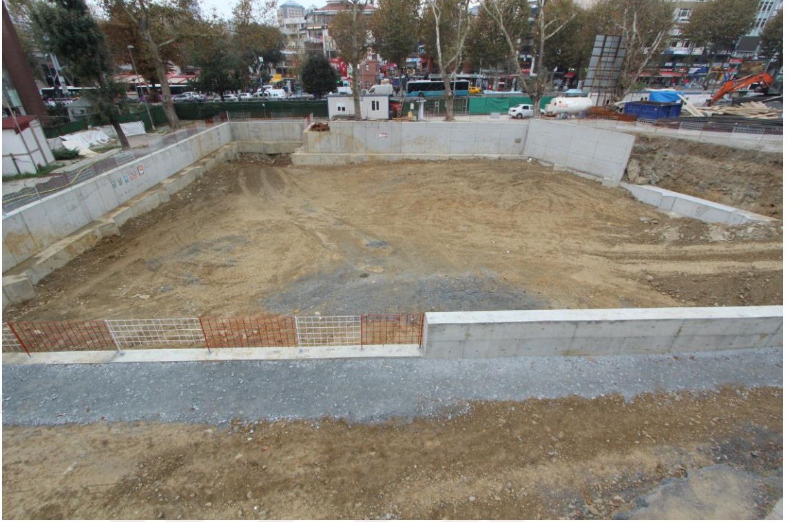
Fotoğraf C.40: Beşiktaş Metro İstasyonu alanı (15.11.2019)
