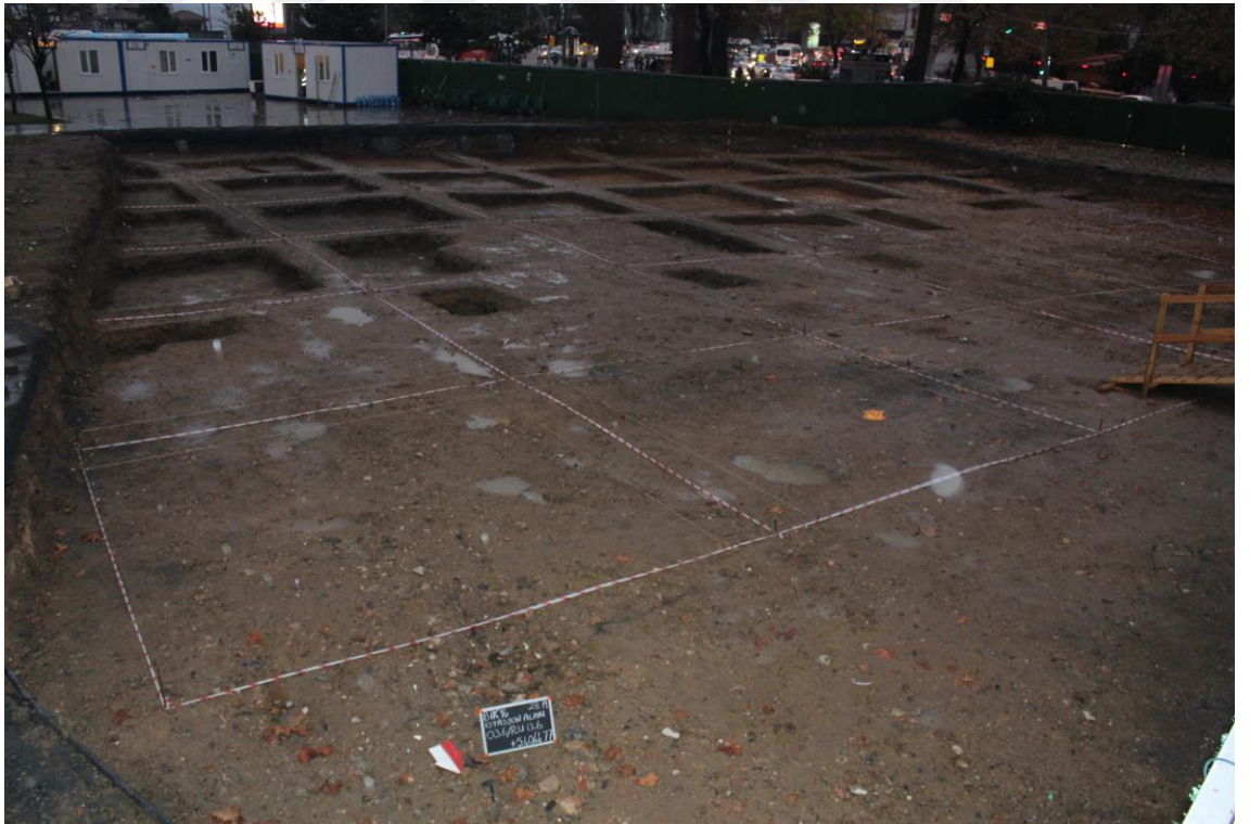
Fotoğraf C.8: Beşiktaş Metro İstasyonu alanı (28.11.2016)
