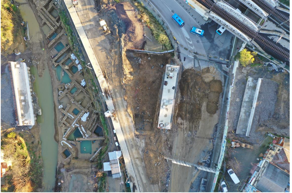
Fotoğraf D.29: Seyit Ahmed Köprüsü inşa çalışmaları ve kazı alanı (11.01.2020)
