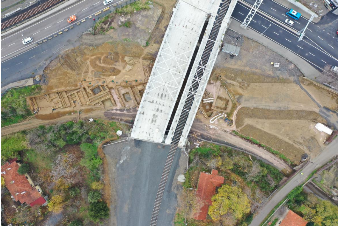
Fotoğraf D.32: Seyit Ahmed Köprüsü inşa çalışmaları ve kazı alanı (17.12.2020)
