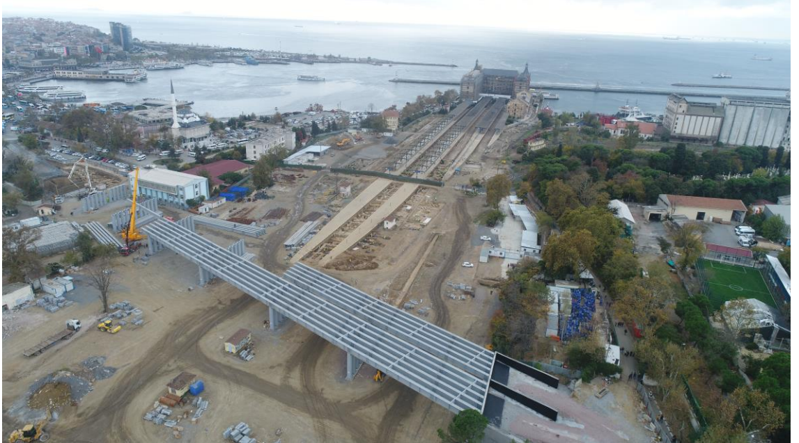
Fotoğraf D.6: Tıbbiye Köprüsü inşa çalışmaları ve kazı alanı (06.10.2018)
