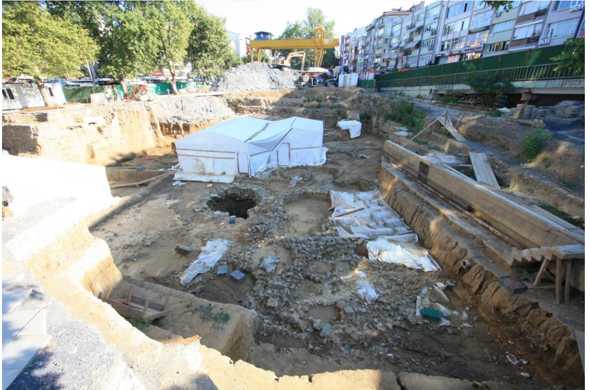
Fotoğraf C.35: Beşiktaş Metro İstasyonu alanı (02.07.2018)
