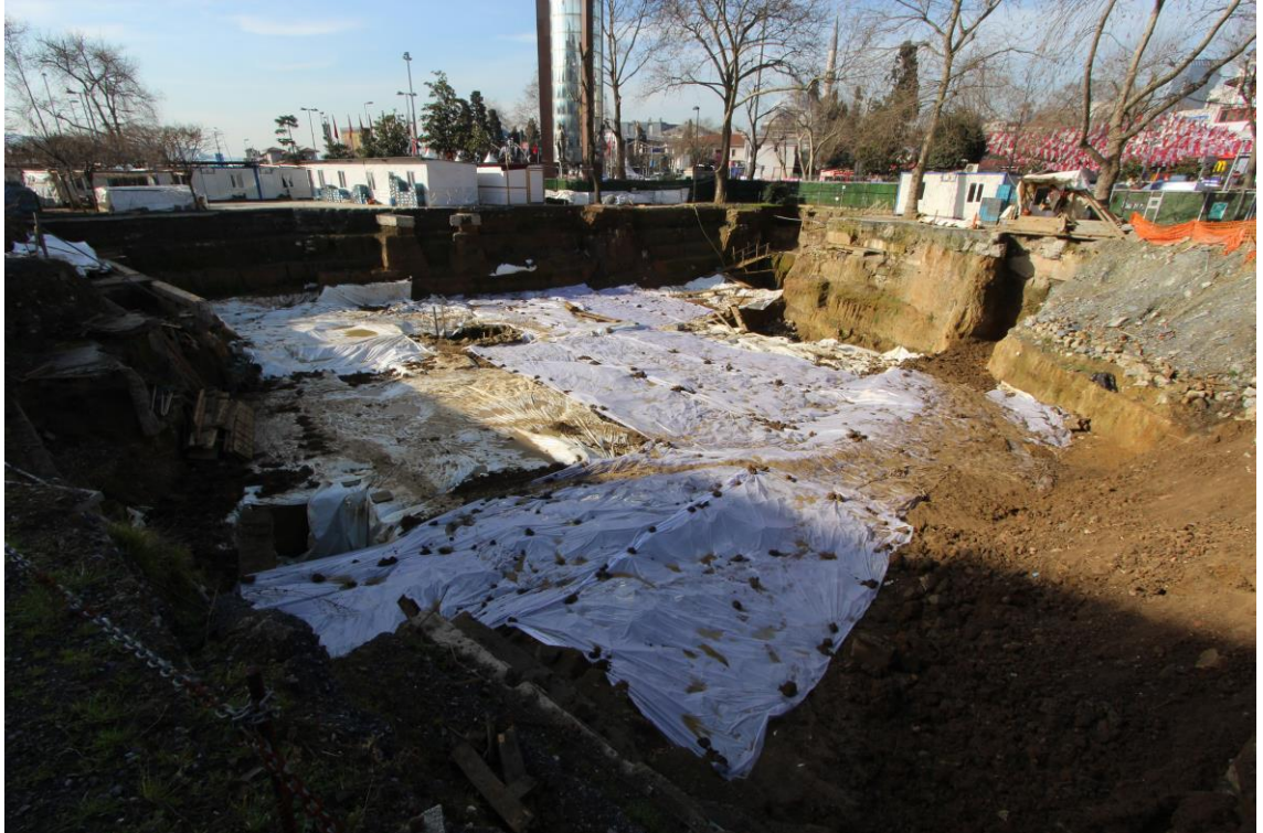
Fotoğraf C.39: Beşiktaş Metro İstasyonu alanı (07.03.2019)
