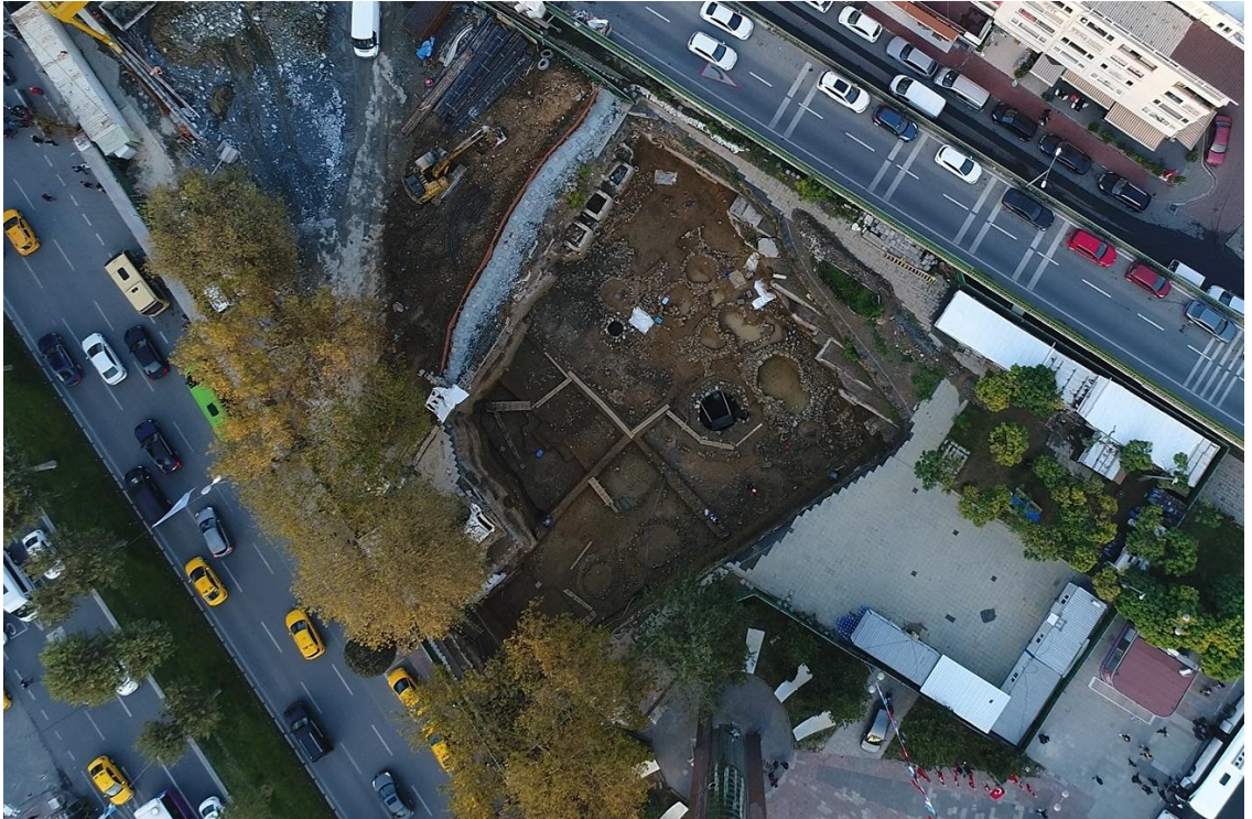
Fotoğraf C.26: Beşiktaş Metro İstasyonu alanı (27.10.2017)
