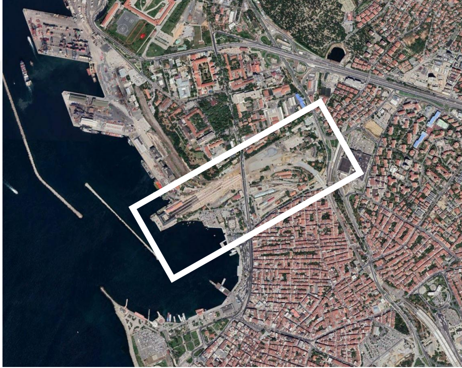
Şekil 5.12: Haydarpaşa Gar Sahası kazı alanının kent içerisindeki konumu (Google Earth, 2021)
