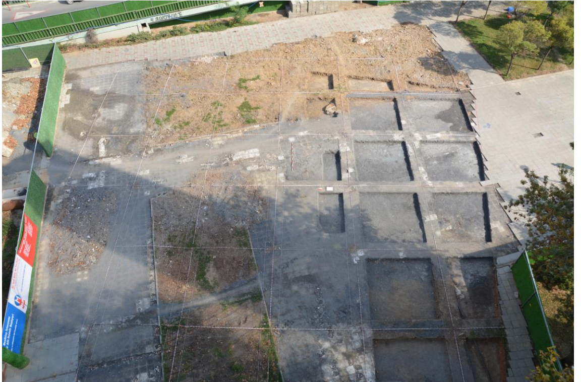
Fotoğraf C.6: Beşiktaş Metro İstasyonu alanı (21.10.2016)
