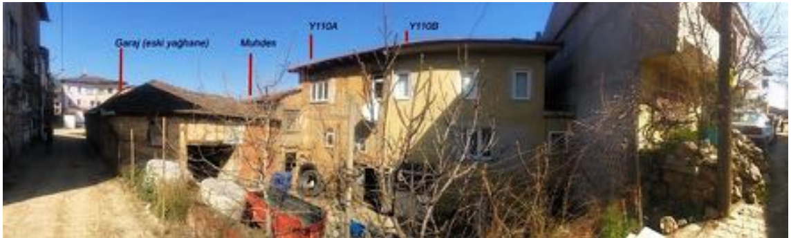
Şekil 4.10. Y110A-B no.lu Yapılara Sokaktan Bakış
