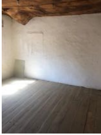
Şekil 4.26. Y110A no.lu Yapı Oda 2'nin Batı Cephesinde Kapatılmış Pencere Boşluğu
