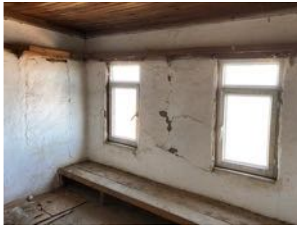
Şekil 4.27. Y110A no.lu Yapı Oda 3'te Kuzeybatı Yönüne Bakış (Batı duvarında kapatılmış pencere boşluğu ve kuzeyde yer alan seki)
