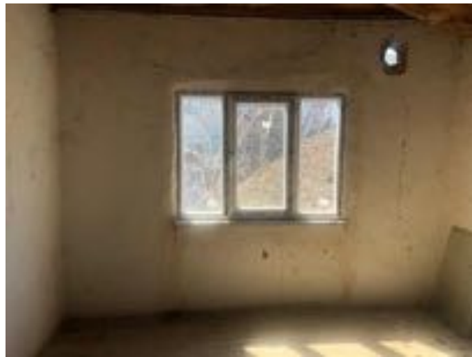
Şekil 4.25. Y110A no.lu Yapı Oda 2 Güney Cephesi
