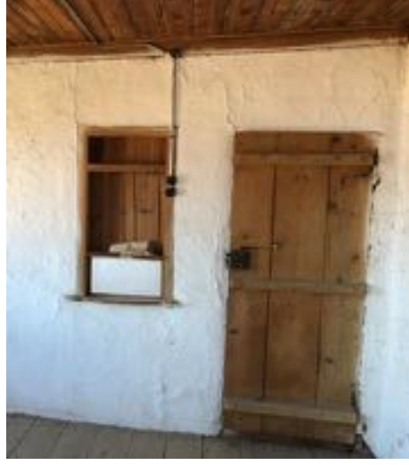
Şekil 4.28. Y110A no.lu Yapı Oda 3 Kapı ve Niş
