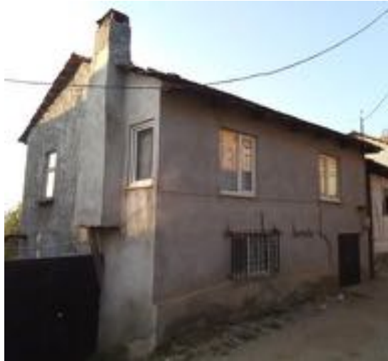
Şekil 4.4. Çimento Sıva ve PVC Doğrama Uygulaması (Y016).
