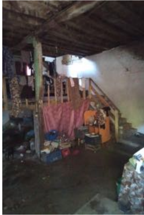
Şekil 3.55. Giriş Kattan Ara Kata Bakış (Y070)
