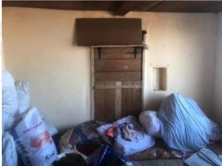
Şekil 4.22. Y110A no.lu Yapı Oda 1 Kuzeybatı Cephesinde Ocak ve Niş
