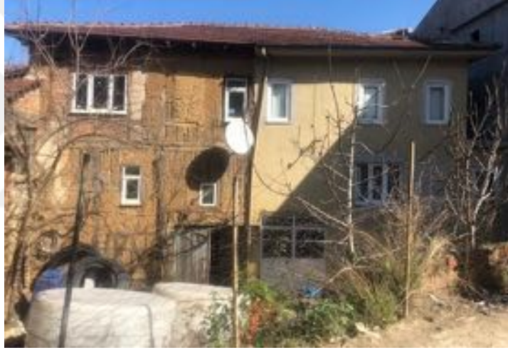
Şekil 4.12. Y110A-B no.lu Yapılar Giriş Cephesi
