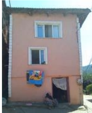
Şekil 4.6. Eternit Üst Örtü (Y45)
