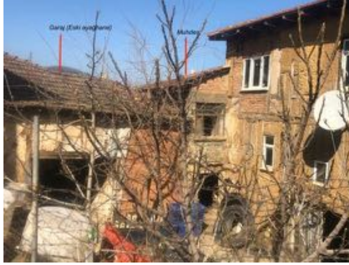
Şekil 4.11. Garaj (Eski Yağhane), Muhdes ve Y110A no.lu Yapıya Bakış
