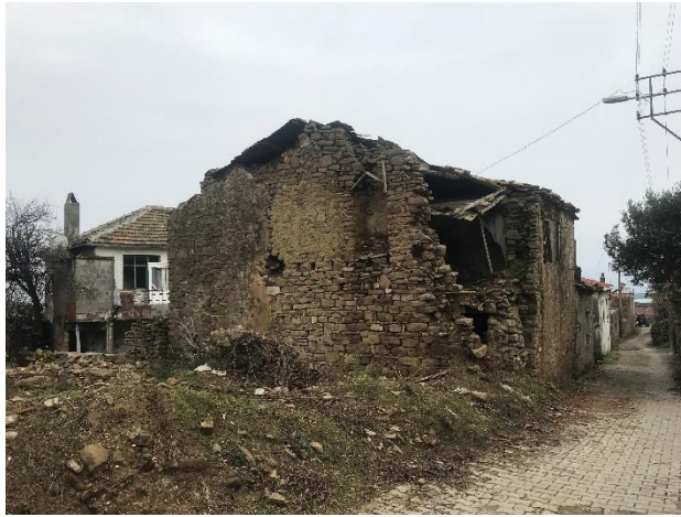
Şekil 5.92 Bitişik nizam kuzeydoğu duvarı, 177 ada 5 parsel (Uçar, 2021).
