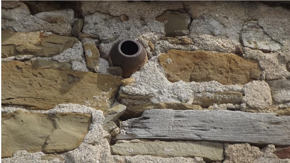
Şekil 5.111 Saçak altında sıralanan mermi kovani, 181 ada 5 parsel (Uçar, 2017).
