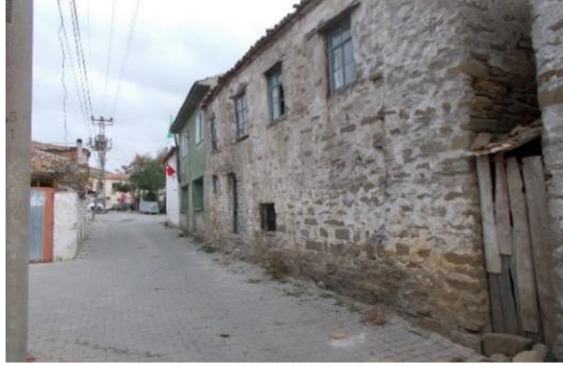
Şekil 4.8 Yığma taş yapı örneği, 181 ada 3 parsel (Uçar, 2020).
