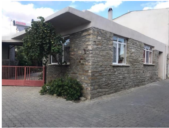
Şekil 5.132 Parsel girişinde günümüz malzemeleri ile onarımı yapılan tek katlı konut, 178 ada 5 parsel (Uçar, 2020).
