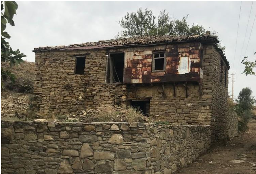
Şekil 5.10 170 ada 2 parselde bulunan konutun giriş cephesi (Uçar, 2021).
