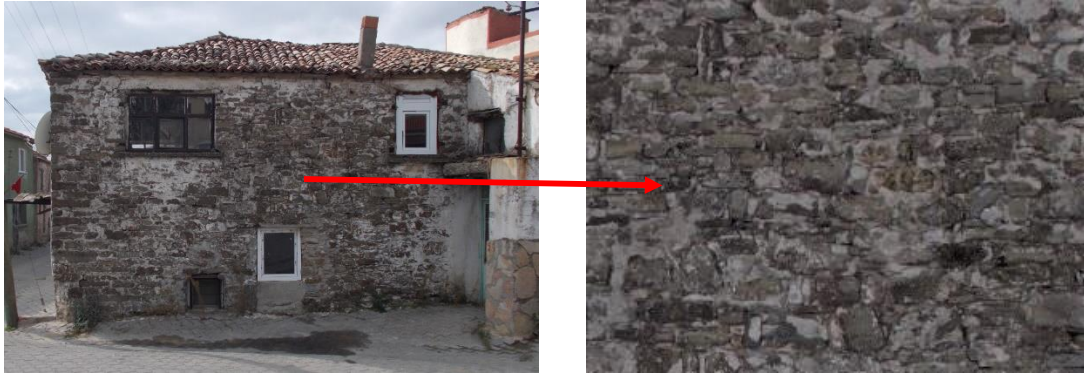
Şekil 4.7 Taş yüzeyini örter şekilde yapılmış derzli taş duvar örneği, 179 ada 12 parsel (Uçar, 2021).
