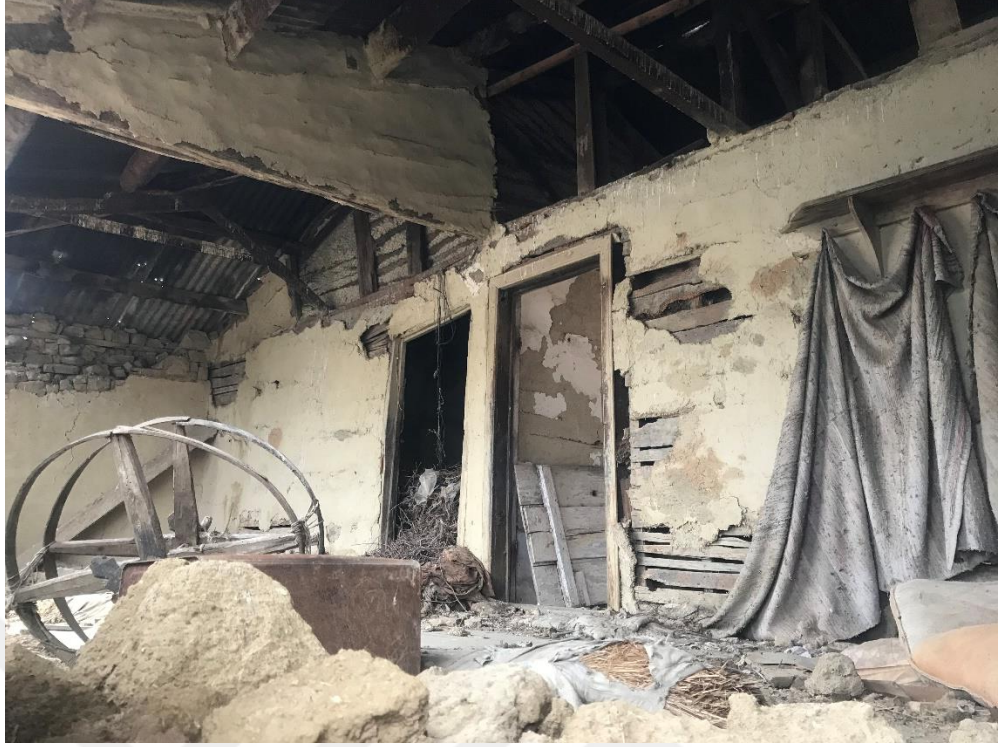
Şekil 5.96 Sofa, bağdadi ara duvar, 177 ada 5 parsel (Uçar, 2021).
