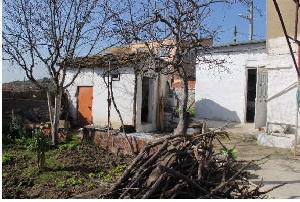
Şekil 4.33 Yapının bahçe içinde bulunan özgün hela yapısı ve yapı duvarına bitişik sonradan yapılan depo, 178 ada 1 parsel (Uçar, 2021).
