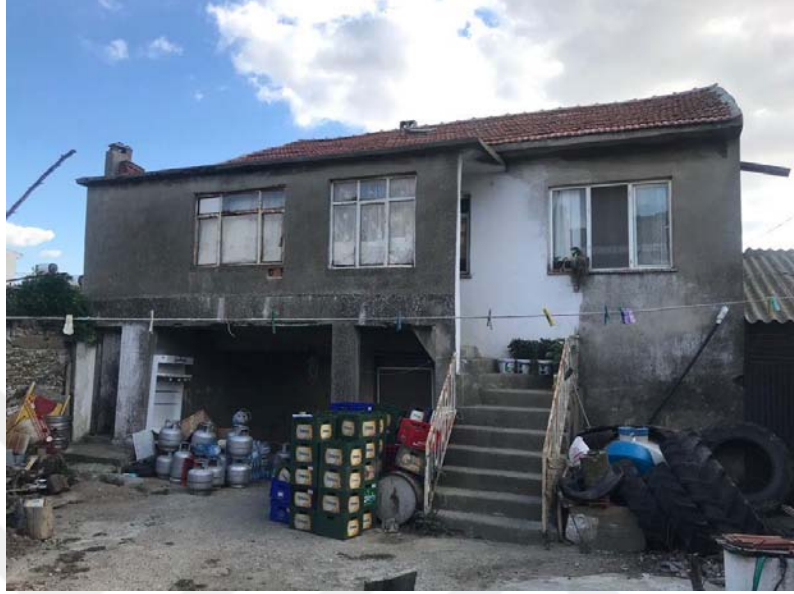
Şekil 5.137 Zemin katı yığma moloz taş duvar olan yapının üst katı betonarme döşeme ve tuğla duvar örülerek yapılmış yapı, 178 ada 2 parsel (Uçar, 2020).
