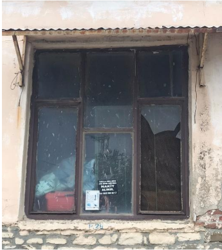
Şekil 5.118 Küçükanaftarta Köyü'nde dönem eki kabul edilebilecek demir doğrama pencereler (Uçar, 2020).
