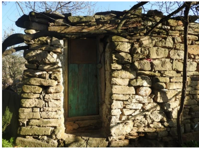
Şekil 5.44 171 ada 4 parselde parsel içinde bulunan hela yapısı (Uçar, 2020).
