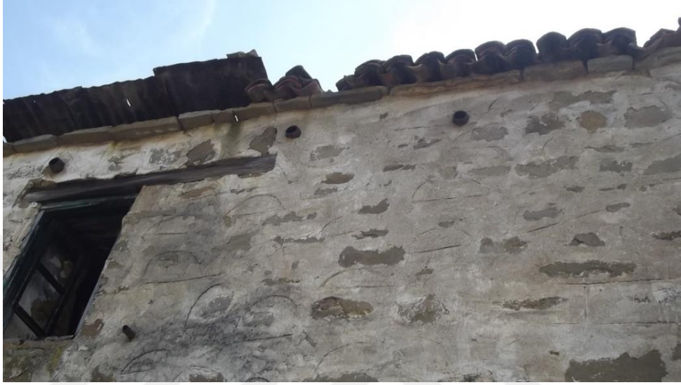
Şekil 5.110 Taş saçak silmesi altına yerleştirilen mermi kovanları, 181 ada 5 parsel (Uçar, 2017).
