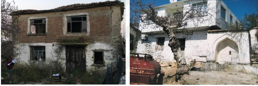
Şekil 4.9 Karma yapı örneği, solda 183 ada 12 parsel, sağda 170 ada 6 parsel (Uçar, 2020).
