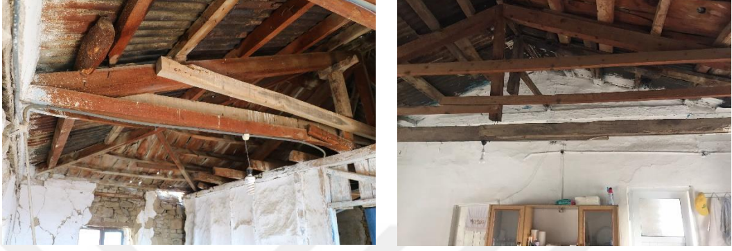
řekil 5.57 Solda 183 ada 9 parselde bulunan konutun ara duvarına oturan makaslı atı, saęda 179 ada 8 parselde bulunan konutun makaslı atısı (Uar, 2020).
