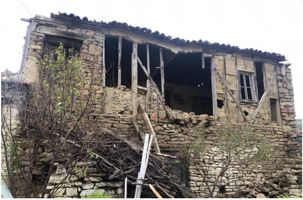
Şekil 5.52 Çatkılı duvar, üst kat giriş cephesi duvarı, 177 ada 5 parsel (Uçar, 2020).
