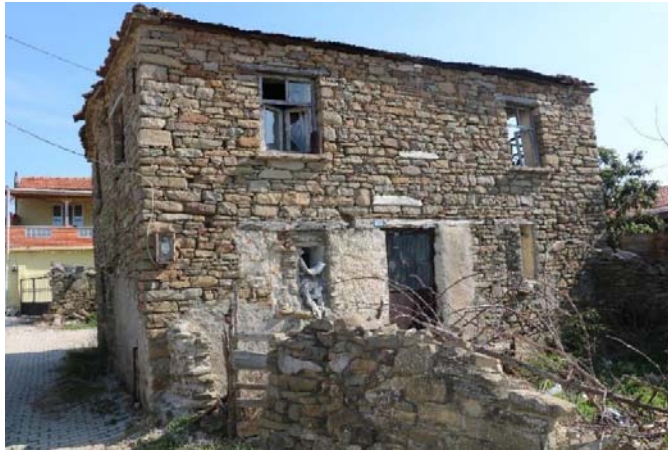
Şekil 5.64 Zemin kat ve üst katı moloz taş duvar olan konut yapısı, 183 ada 9 parsel (Uçar, 2020).
