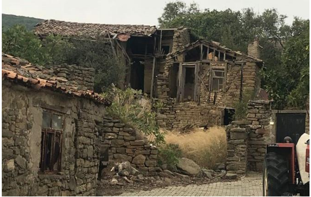
Şekil 5.53 Çatkılı duvar, üst kat giriş cephesi duvarı, 194 ada 2 parsel (Uçar, 2020).
