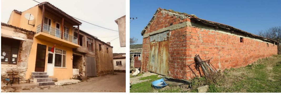
Şekil 4.10 Solda betonarme karkas yapı, 178 ada 11 parsel, sağda yığma tuğla yapı, 196 ada 1 parsel (Uçar, 2020).
