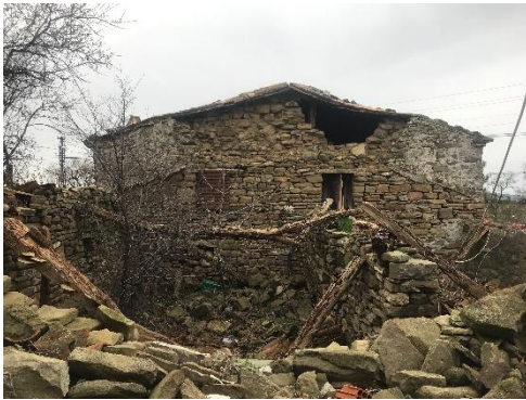
Şekil 4.39 Solda yapının yıkılmış dam yapısı ve kuzeybatı cephesi, sağda güneydoğu cephesi, 195 ada 3 parsel (Uçar, 2019).
