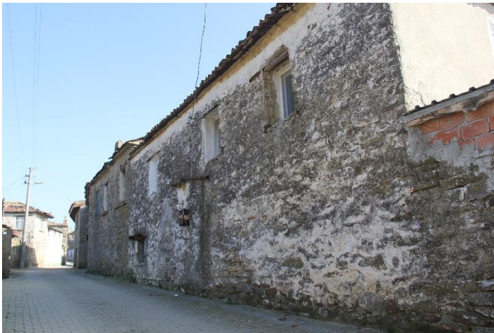
Şekil 4.34 Yapının arka sokaktan kuzeybatı cephesi, 178 ada 1 parsel (Uçar, 2021).
