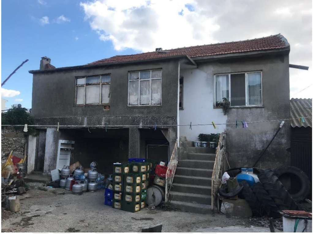
Şekil 4.11 Karma yapı örneği, 178 ada 2 parsel (Uçar, 2021).
