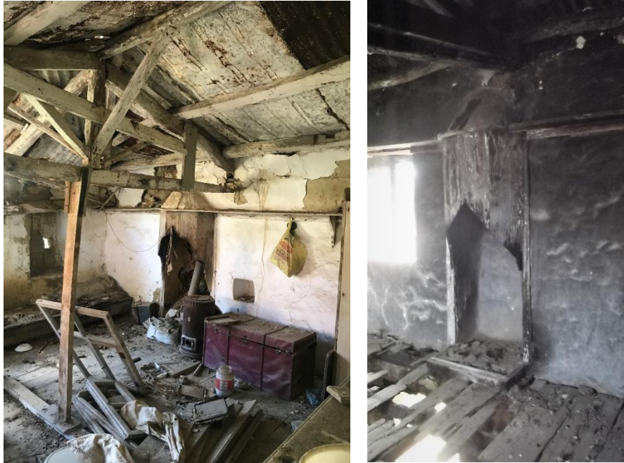
Şekil 5.31 Oda duvarını çevreleyen sergen ve ocak, solda 191 ada 1 parsel, sağda 181 ada 5 parsel (Uçar, 2020).
