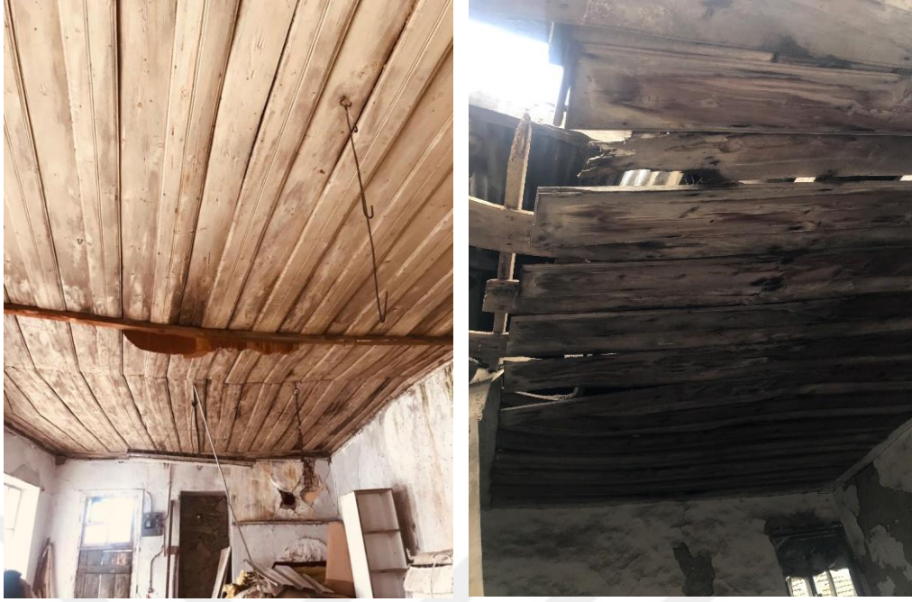
Şekil 5.59 Solda kahvenin tavan kaplaması 178 ada 12 parsel, sağda metruk yapının tavan kaplaması 177 ada 5 parsel (Uçar, 2020).
