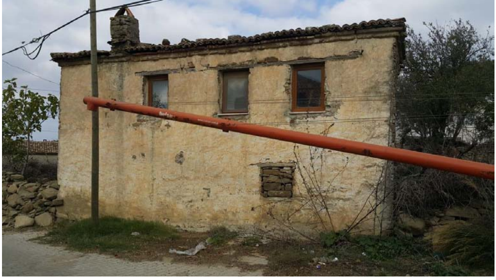
Şekil 5.25 195 ada 3 parselde yer alan yapının sokağa bakan cephesi (Uçar, 2021).
