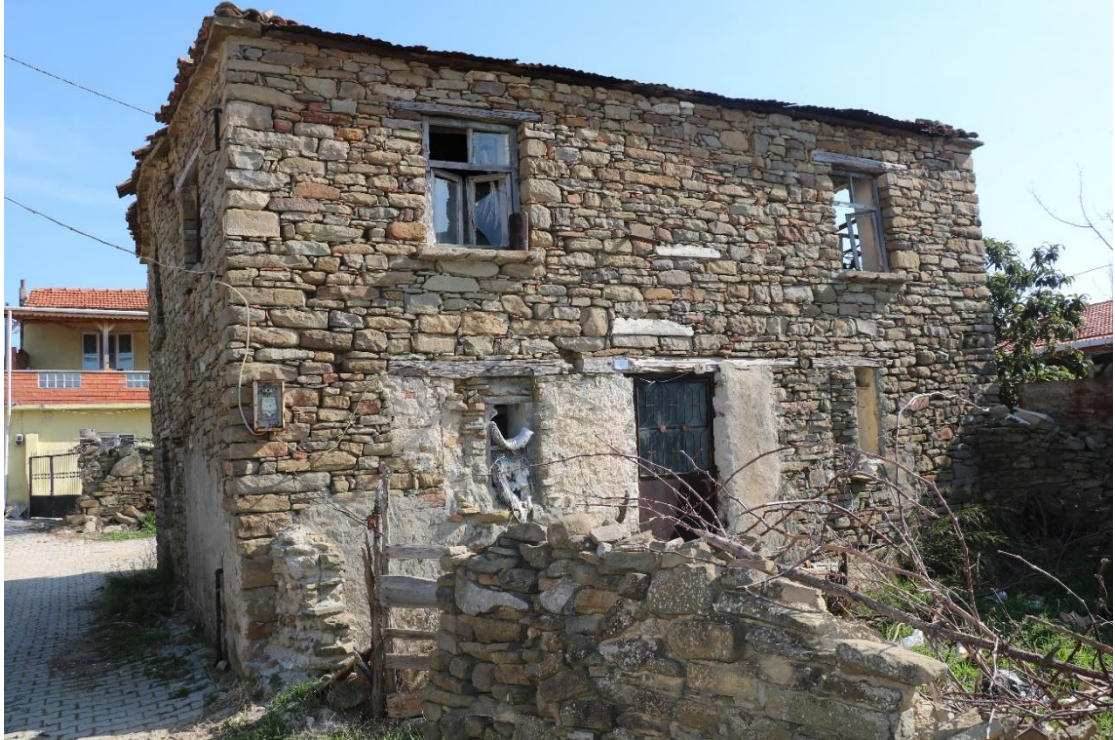
Şekil 5.20 183 ada 9 parselde yer alan yapının bahçeden giriş cephesi (Uçar, 2020).
