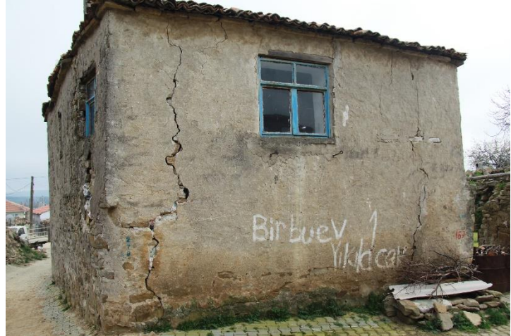
Şekil 5.121 Yapısal hasara uğramış moloz taş duvarda meydana gelen ayrılma, 177 ada 7 parsel (Uçar, 2020).
