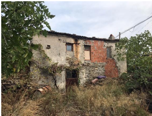
Şekil 5.138 Moloz taş duvar örgüsünde tuğla ile yapılan onarım, solda 195 ada 3 parsel, sağda 177 ada 7 parsel (Uçar, 2020).
