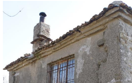
Şekil 5.62 Tek sıra taş saçak silmesi 190 ada 7 parsel, iki sıra taş saçak silmesi, 194 ada 3 parsel (Uçar, 2020).
