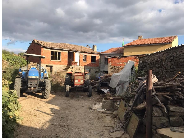
Şekil 5.130 Üst kat duvarları tuğla malzeme ile onarım gören yapı, 177 ada 11 parsel (Uçar, 2020).
