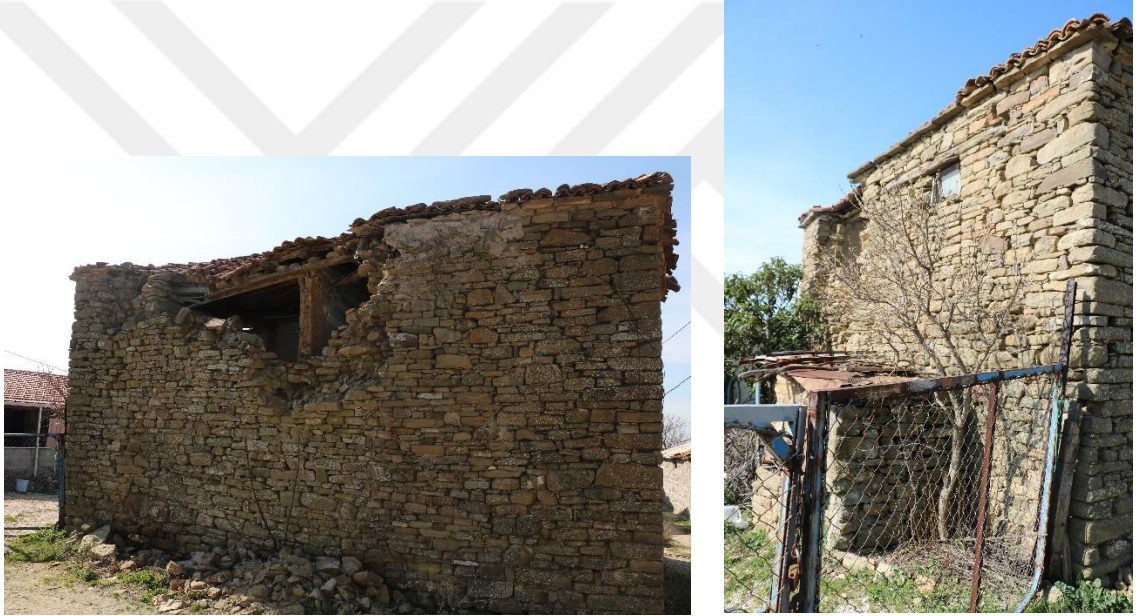
Şekil 4.30 Ayrık nizam ara parselde, bahçeli konut yapısının solda kuzeydoğu, sağda güneydoğu cepheleri, 183 ada 9 parsel (Uçar, 2020).
