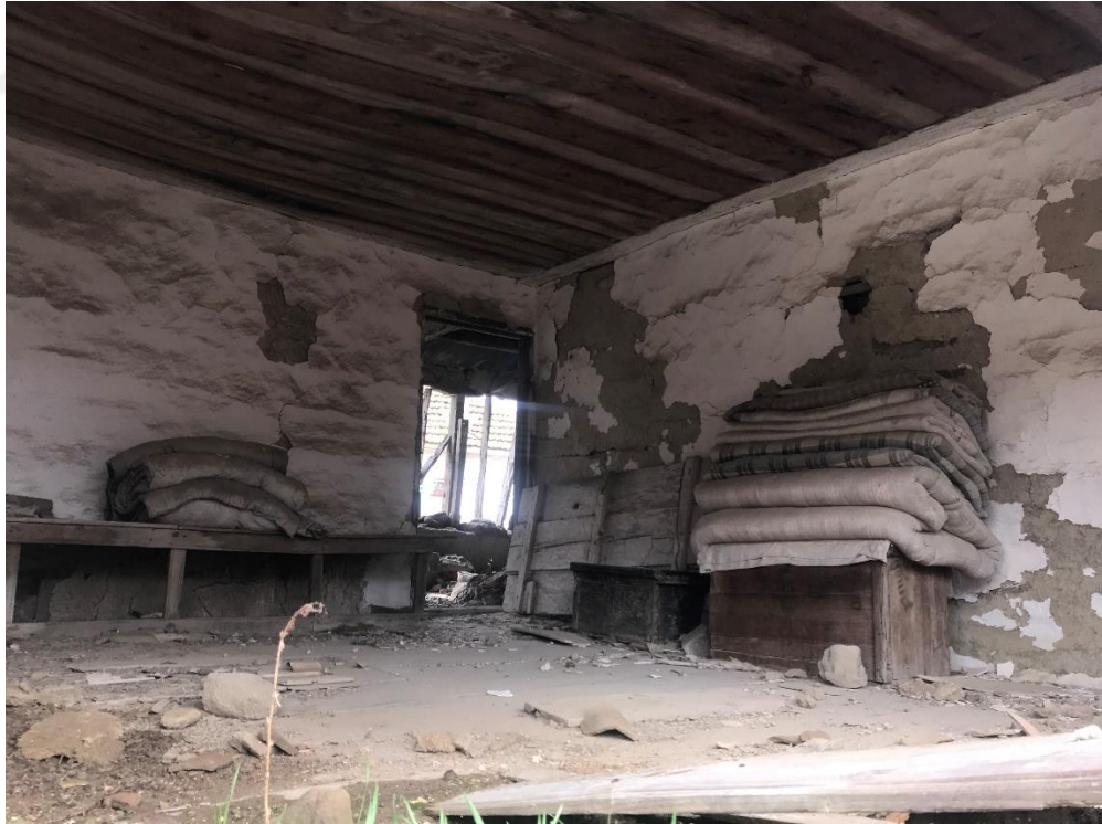
Şekil 5.97 Üst kat odada bulunan sedir ve ahşap tavan kaplaması, 177 ada 5 parsel (Uçar, 2021).
