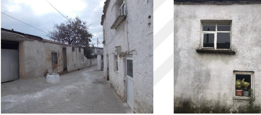
Şekil 5.83 Solda yapının çıkmaz sokağa bakan cephesi ve sokakta bulunan su kuyusu, sağda üst kat demir doğrama oda penceresi ve dam penceresi (Uçar, 2020).
