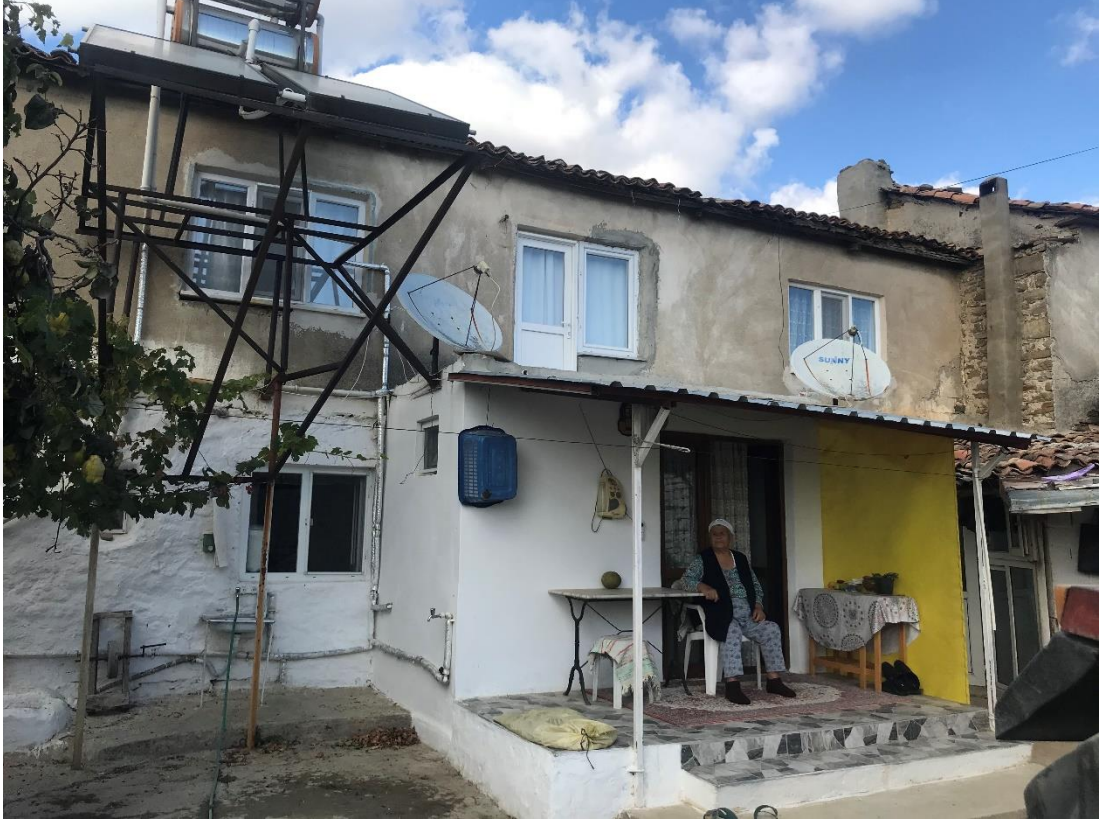
Şekil 5.127 Yapının giriş cephesine yapılan eklenti ve üst kat çatıklı duvarı tuęla ile yenilerek pvc pencere takılan yapı, 178 ada 1 parsel (Uçar, 2021).
