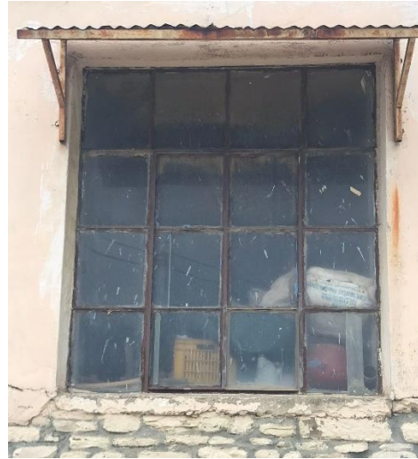
Şekil 5.118 Küçükanaftarta Köyü'nde dönem eki kabul edilebilecek demir doğrama pencereler (Uçar, 2020).
