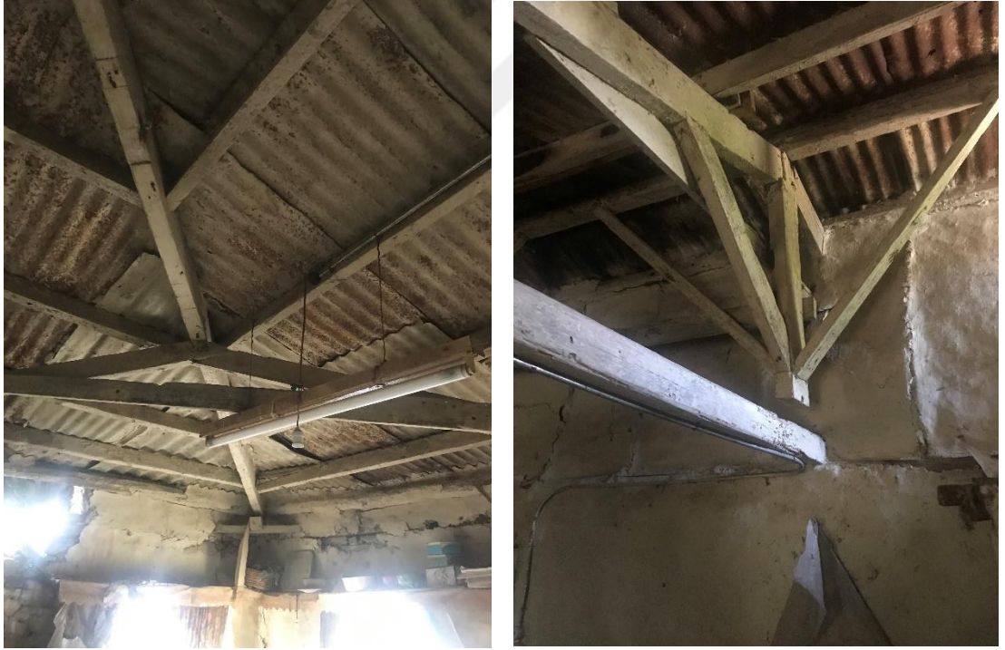
řekil 5.58 195 ada 3 parselde bulunan iki katlı konutun zgn ahřap atı makası (Uar, 2021).
