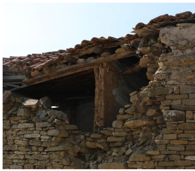
Şekil 5.50 Çatkılı ara duvar (Şekil 5.38), 183 ada 9 parsel (Uçar, 2020).
