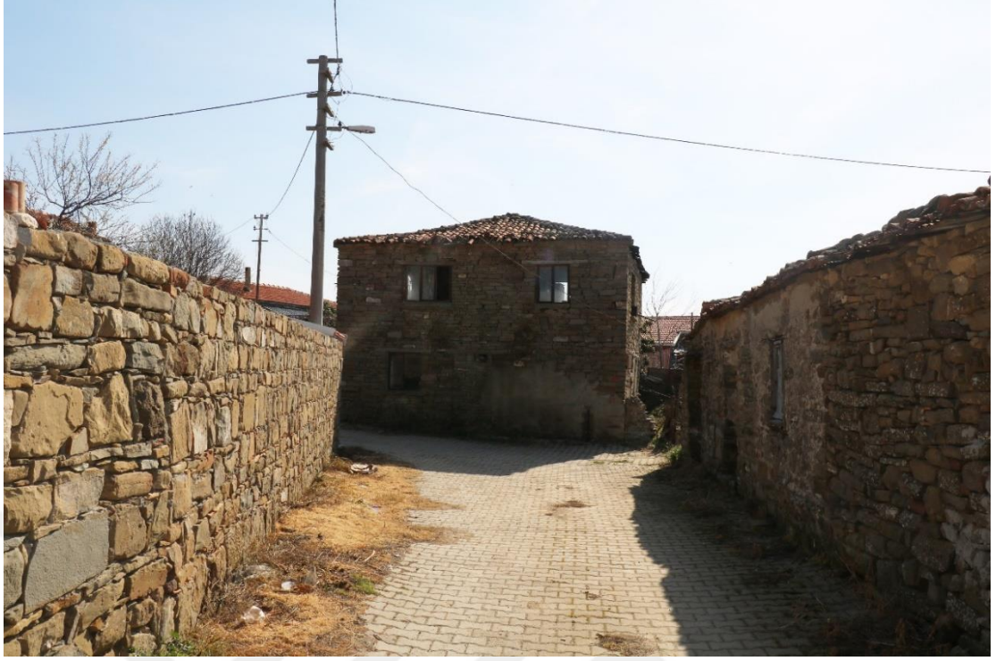
Şekil 5.19 Kuzeybatıdaki sokaktan 183 ada 9 parseldeki ayırık nizam yapının so-kağa bakan cephesi (Uçar, 2020).
