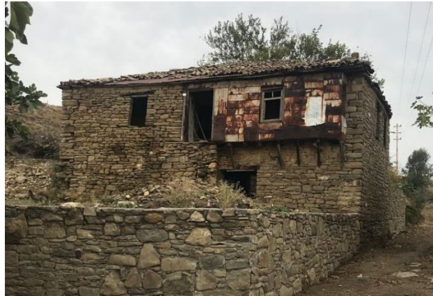
Şekil 5.103 Üst katına dışarıdan merdiven ile ulaşılan yapının dışı bakan çatkılı sofa duvarında görünen çıkma, 170 ada 2 parsel (Uçar, 2020).
