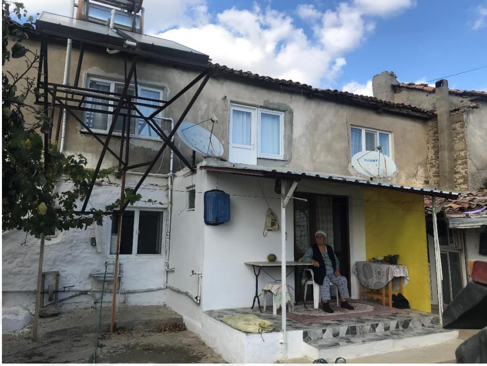
Şekil 5.22 178 ada 1 parselde yer alan yapının bahçeden giriş cephesi (Uçar, 2021).
