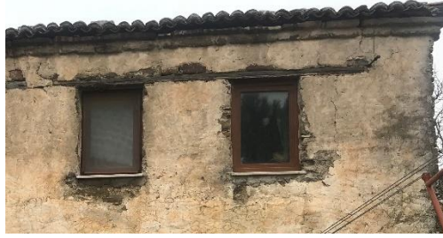
Şekil 5.113 İki sıralı taş saçak silmesi, 195 ada 3 parsel (Uçar 2021).
