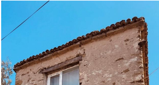
Şekil 5.62 Tek sıra taş saçak silmesi 190 ada 7 parsel, iki sıra taş saçak silmesi, 194 ada 3 parsel (Uçar, 2020).
