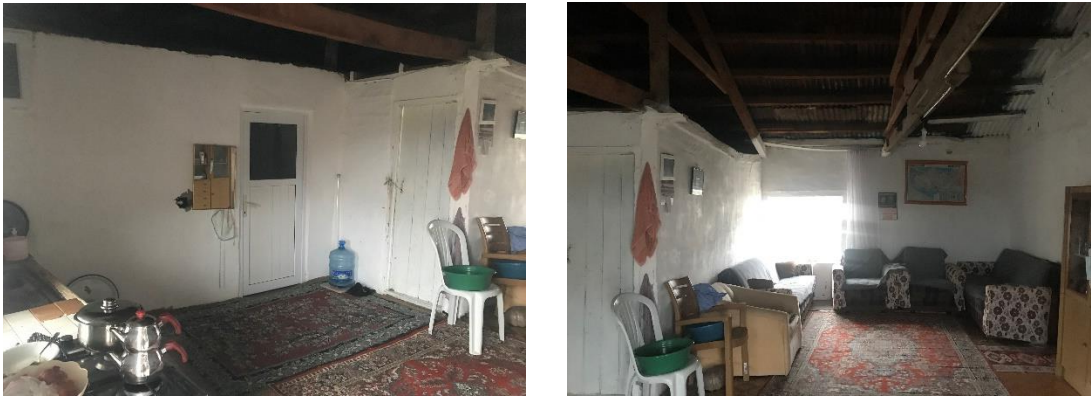
Şekil 5.84 Solda sofaya dahil edilerek değiştirilen oda duvarı, sağda sofa ve üzerinde makashlı kırma çatı (Uçar, 2020).
