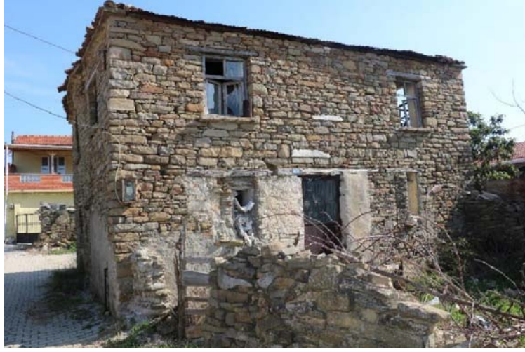
Şekil 5.54 Zemin ve 1.katı moloz taş duvar yapı, 183 ada 9 parsel (Uçar, 2020).
