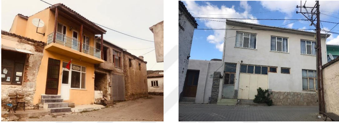
Şekil 5.135 Geleneksel konut dokusuna aykırı betonarme yapılar, solda 178 ada 11 parsel, sağda 178 ada 17 parsel (Uçar, 2020).
