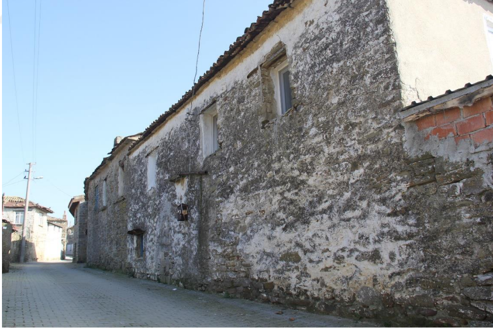
Şekil 5.23 178 ada 1 parselde yer alan yapının sokağa bakan arka cephesi (Uçar, 2021).
