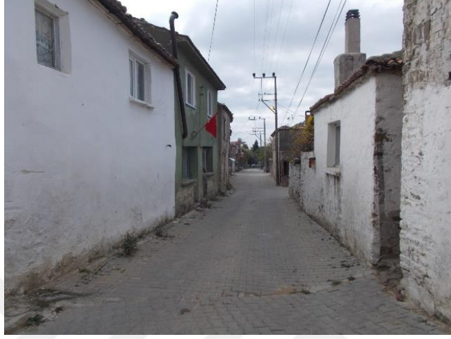
Şekil 5.106 Çamur sıva üzeri kireç sıva ve badana yapılmış cephe, solda 181 ada 1 parsel, sağda 179 ada 13 parsel (Uçar, 2020).
