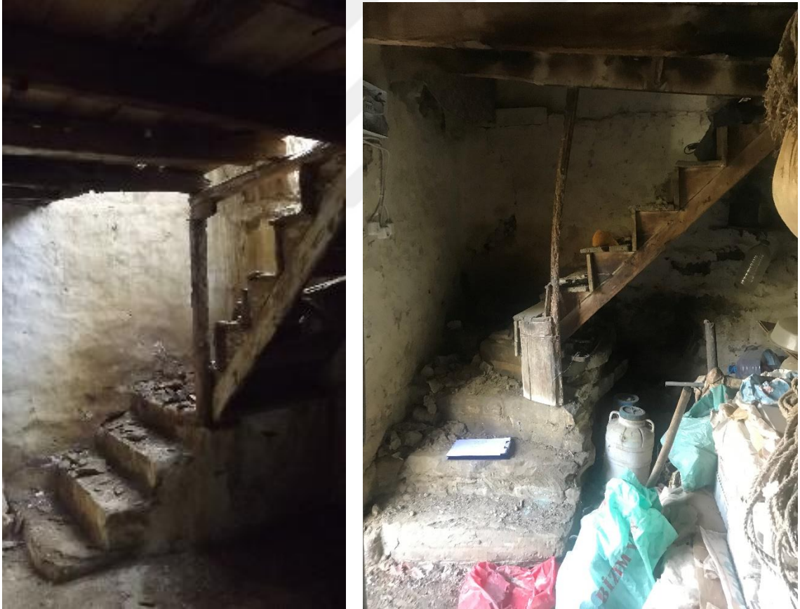
Şekil 5.29 L şeklinde tek kollu merdiven, solda 181 ada 5 parsel, sağda 195 ada 3 parsel (Uçar, 2020).
