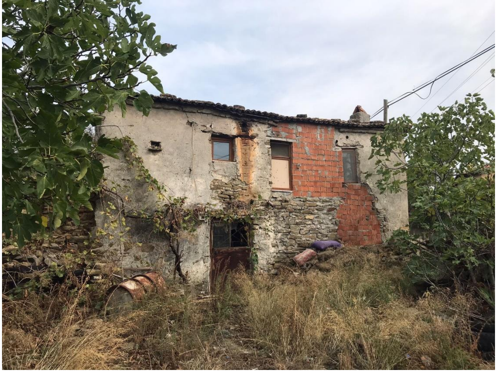
Şekil 5.26 195 ada 3 parselde yer alan yapının bahçeden giriş cephesi (Uçar, 2021).
