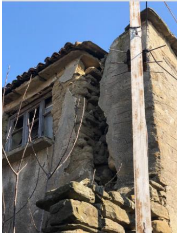
Şekil 5.121 Yapısal hasara uğramış moloz taş duvarda meydana gelen ayrılma, 177 ada 7 parsel (Uçar, 2020).
