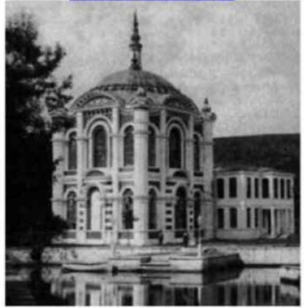
Sa'dabad Camisi güneydoğu cephesi. Kubbe kasnağı kaldırılmadan önce. (Abdullah Freres, 1880-1893)
