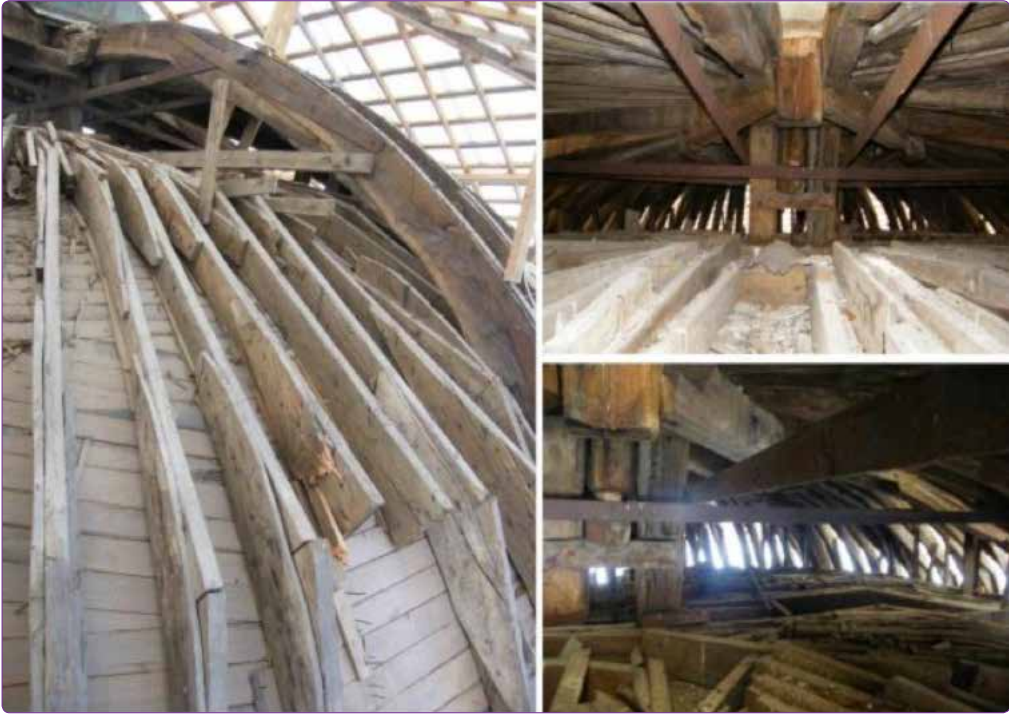
Şekil 20. Ahşap Kubbeden detaylar (Kübra İnşaat, Salar).
