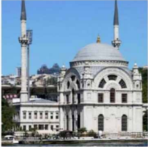
Dolmabahçe Camisi güneybatı cephesi
