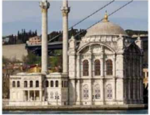
Büyük Mecidiye Camisi güneybatı cephesi
