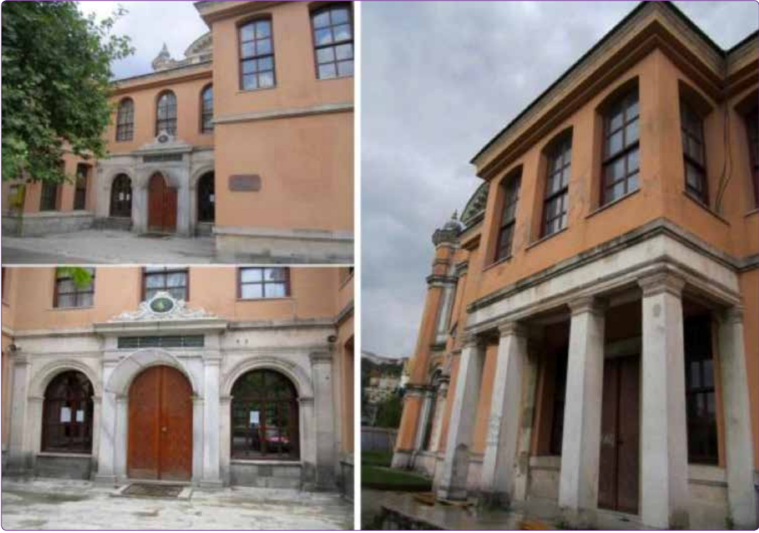
Şekil 11. Cami- Hünkar Kasrı ana giriş kapısı ve hünkar girişi (Kübra İnşaat, Salar).
