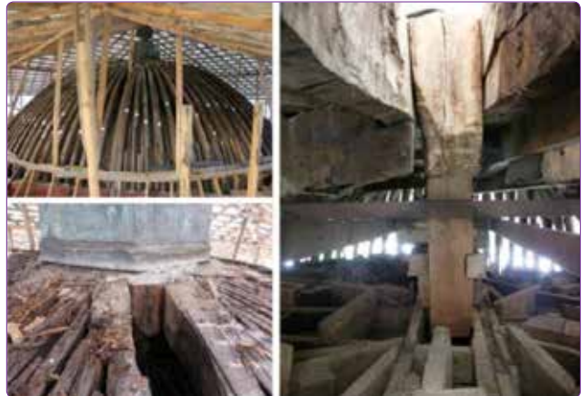
Şekil 19. Ahşap Kubbeden detaylar (Kübra İnşaat, Salar).
